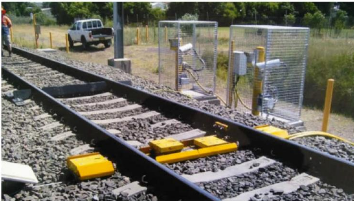
شکل ۱۲- تصویر Hot Box Detector از تجهیزات ثابت قابل نصب در فونداسیون
