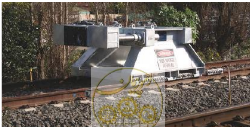
شکل ۱۱- نمونه ای باز بافر استاپ های ترکیبی (لغزنده-هیدرولیکی)
