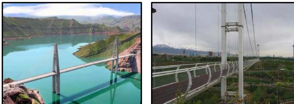
شکل ۲-۱۰- به ترتیب از راست به چپ: پل معلق و پل کابل ایستا
