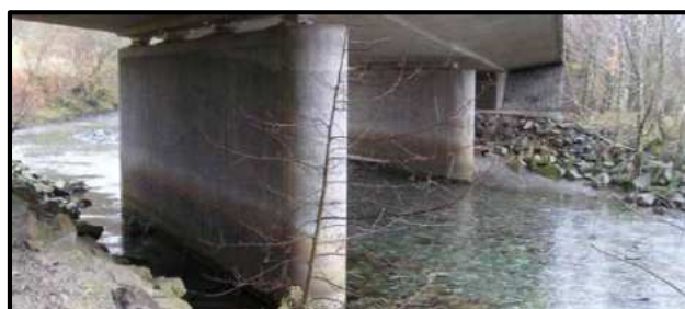
شکل ۳-۱۵- شکل پایه‌های مناسب برای تسهیل عبور مواد شناور چوبی بزرگ و شاخ و برگ‌ها
