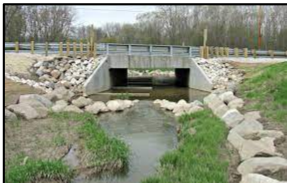
شکل ۳-۲۴- آبگذر تک‌دهانه با تکیه‌گاه‌های کناری برای عبور حیوانات و ماهیان با حفظ سیمای طبیعی بستر
