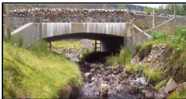
شکل ۲-۱۴- آبگذر تک‌دهانه با تکیه‌گاه‌های کناری برای حفظ سیمای طبیعی بستر
