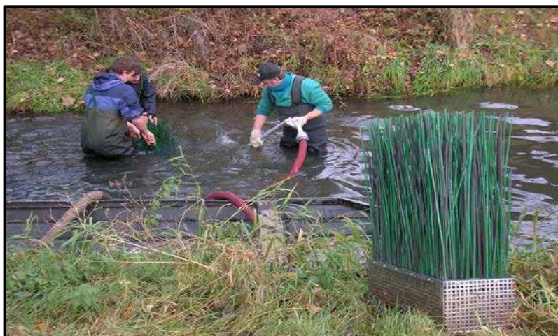
شکل ۳-۱۰۳- استقرار برس‌های علفی در بستر رودخانه برای حفاظت از صدف‌های رودخانه‌ای (دانشگاه کاسل المان، ۲۰۰۷)
