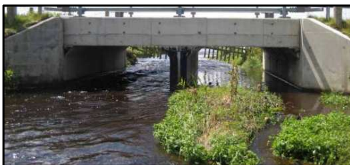
شکل ۲-۱۵- آبگذر دو دهانه برای حفظ عرض آبراهه بزرگ
