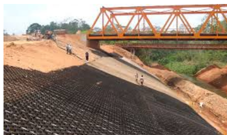
حفاظت طبیعی - سازه‌ای دیواره رودخانه در بالادست پل
