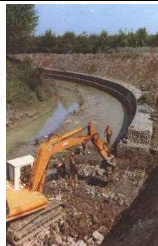
دیواره تورسنگ در حفاظت دیواره پایین پیچ و اصلاح شیب و پوشش گیاهی در دیواره بالای پیچ رودخانه
