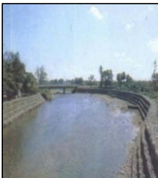
شکل پ. ۴-۲۱- دیواره تورسنگ در حفاظت پیچ رودخانه در بالادست پل
