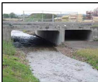
شکل ۲-۱۴- آبگذر تک‌دهانه با تکیه‌گاه‌های کناری برای حفظ سیمای طبیعی بستر
