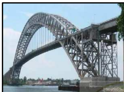
شکل ۲-۹- به ترتیب از راست به چپ: پل قوسی با عرشه روگذر و اسپندرل باز و پل قوسی میان‌گذر
