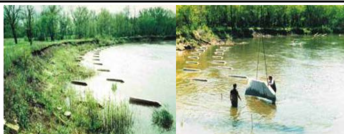
صفحات مستغرق بتنی در حفاظت پیچ رودخانه در بازه پل
