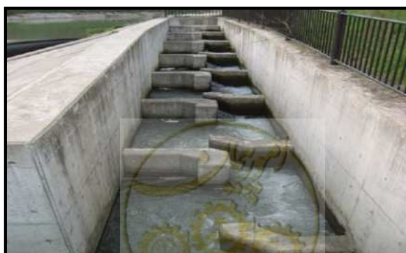
شکل ۳-۹۷- نمایی از راهماهی نوع بازشدگی قائم و زاویه بازشدگی ۴۵ درجه نسبت به جهت جریان
