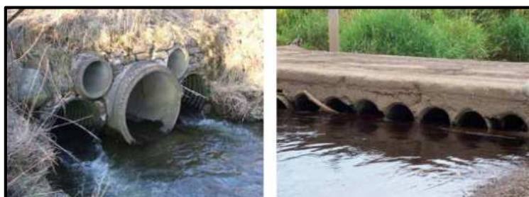
شکل ۳-۲۱- کاربرد نامناسب آبگذر با مجموعه لوله‌های کوچک و خطر انسداد و مخاطرات محیط‌زیستی
