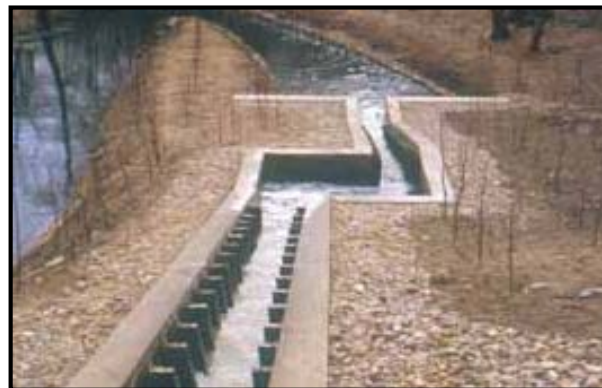
شکل ۹۹-۳- نمایی از راه‌ماهی دنیل
