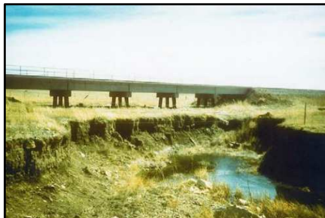
شکل ۳-۴۱- تغییر ابعاد رودخانه در اثر مهاجرت سر آبکند به طرف بالادست
