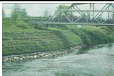
حفاظت طبیعی دیواره رودخانه در محل پل
