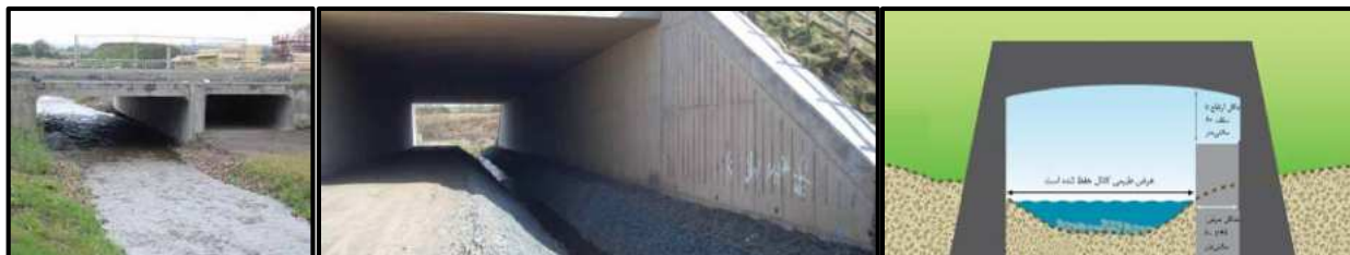
شکل ۳-۲۶- آبگذر با حفظ عرض آبراهه و گذرگاه حیوانات توسط سکوی کناری در زیر آبگذر و بیرون از بستر آبراهه
