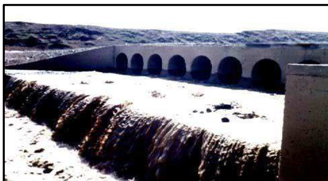
شکل ۳-۸۸- مجموعه آبگذرها و آبشار موجود در پایین دست، مانع گذر ماهی مهاجر به بالادست
