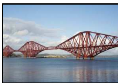
شکل ۲-۷- پل خرپایی طره‌ای
