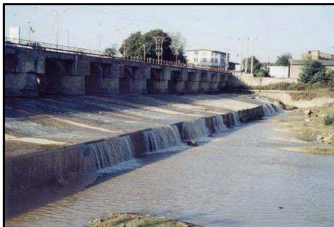
شکل ۳-۸۷- مانع پل تجن
