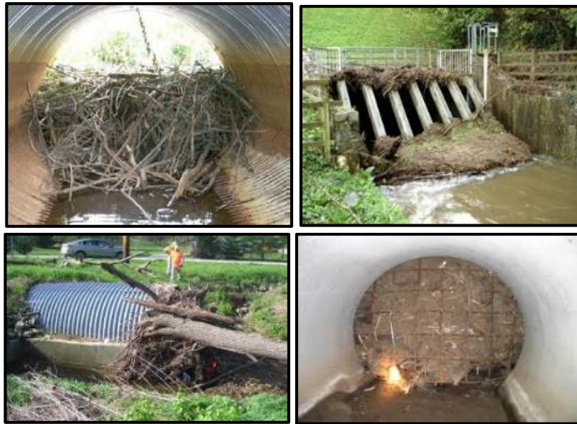
شکل ۳-۷۴- نمونه‌هایی از انواع انسداد در ورودی آبگذر
