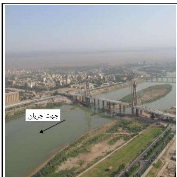
شکل ۳-۶۸- جداسازی جریان در اثر خاکریزی در رودخانه
