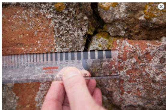
شکل (۲-۴): خط‌کش مدرج شفاف برای تعیین عرض ترک
