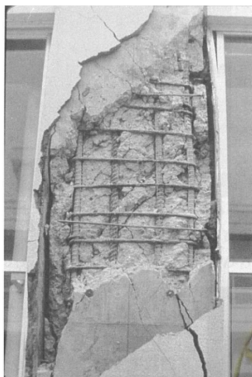
شکل (۳-۱۳): سطح آسیب ۱، ستون در رفتار غالب برشی
