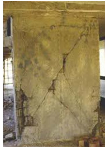
شکل (۳-۱۵): سطح آسیب ۳، دیوار برشی در رفتار غالب خمش/کشش مورب
