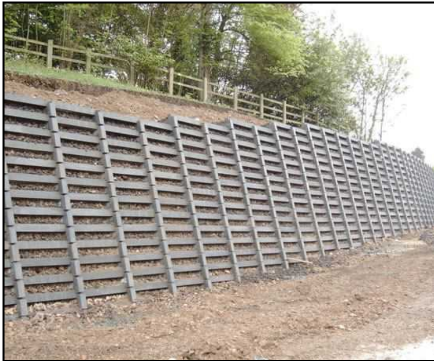
شکل ۱۱-۸ - نمونه‌ای از دیوار حائل صندوقه‌ای اجرا شده
