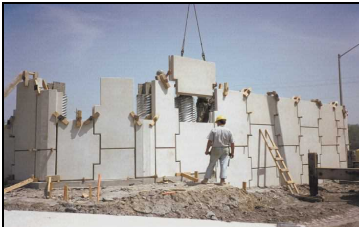
شکل ۱۲-۴- اجرای دیوار خاک مسلح با نمای بتنی
