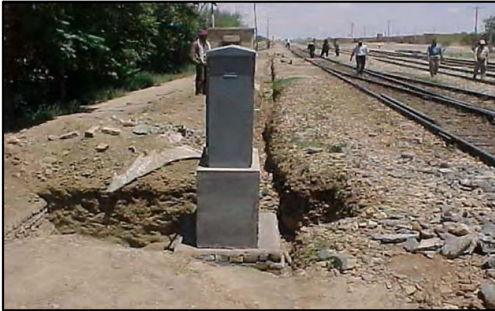
شکل ۵-۳- نمونه‌ای از فاصله فونداسیون از لبه ریل
