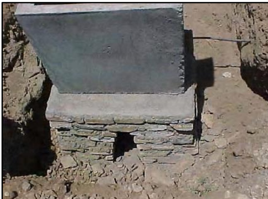
شکل ۵-۱- نمونه‌ای از فونداسیون DC
