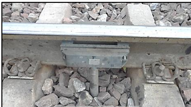
شکل ۹-۱- نمونه‌ای از نصب محور شمار
