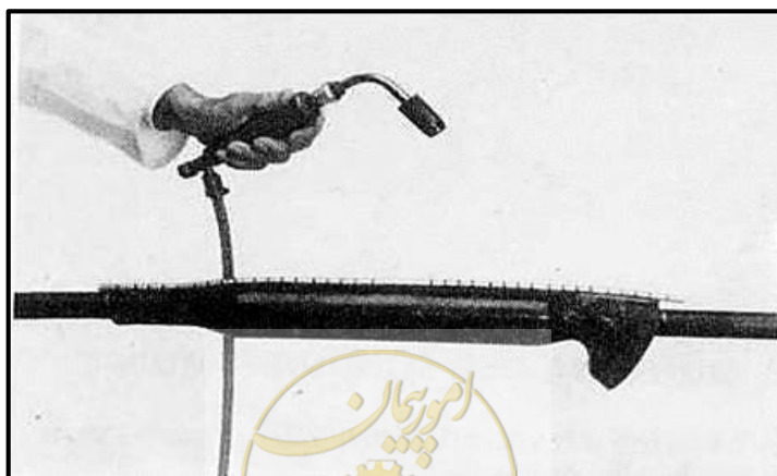
شکل ۴-۹- نحوه حرارت دادن ابتدا و انتهای کپ
