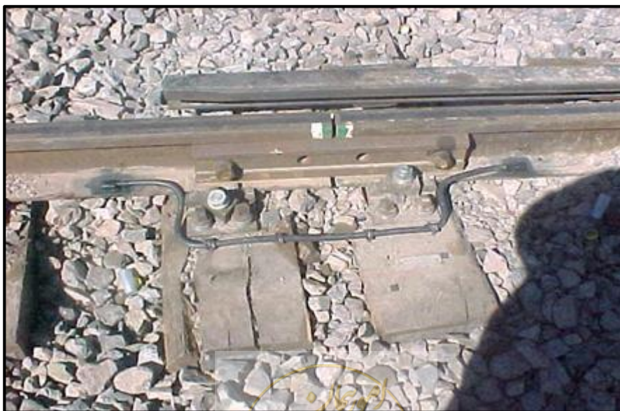
شکل ۷-۱۱- نمایی از یک ریل باند جوشکاری شده
