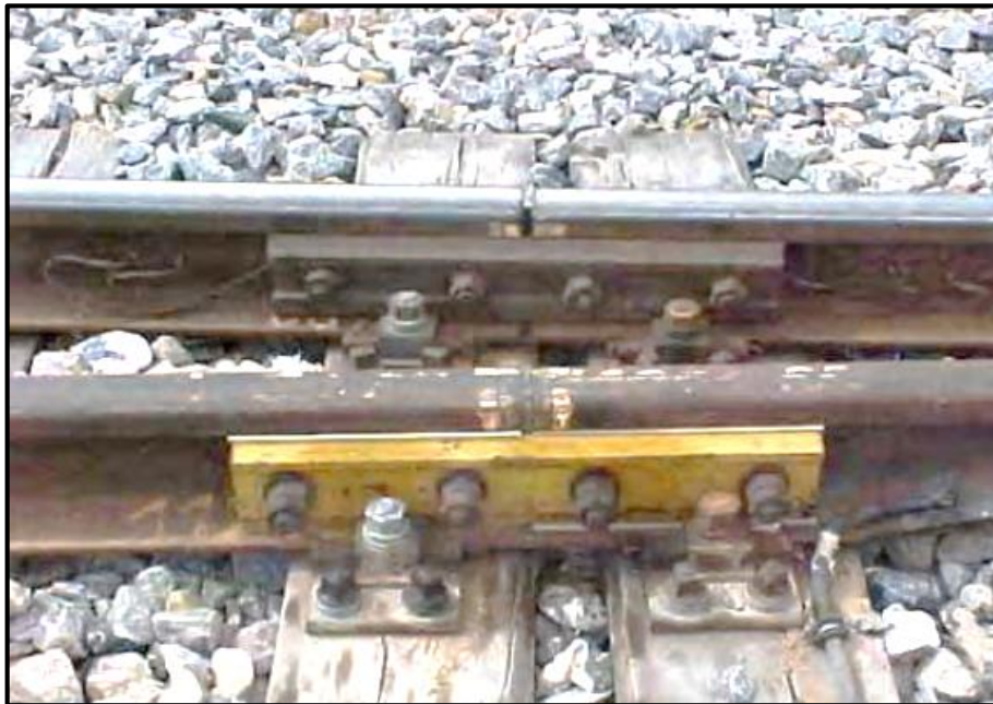
شکل ۷-۱۳- نمونه‌ای از عایق‌بندی
