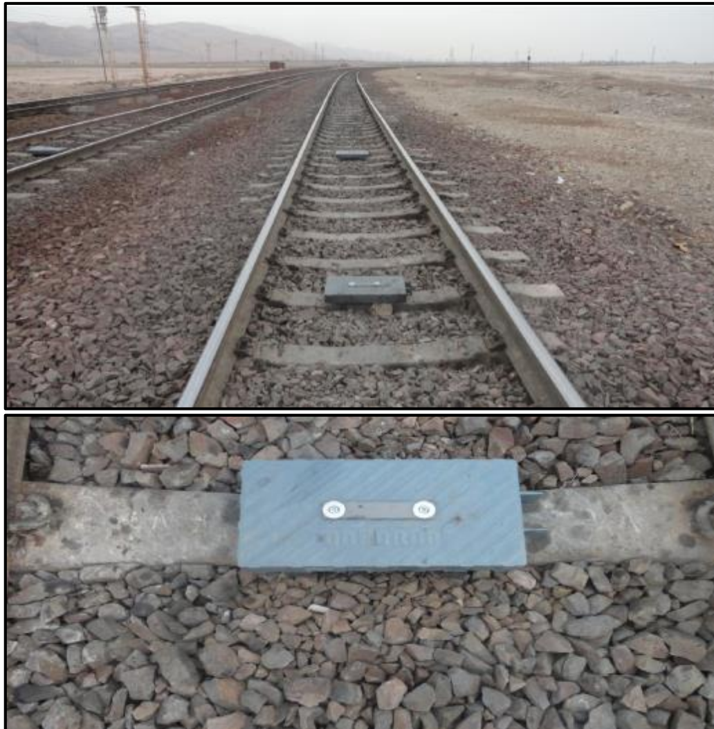
شکل ۱۰-۱۳- نمونه‌ای از نصب بالیزها
