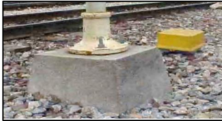
شکل ۶-۱- نمونه ای از فونداسیون چراغ پایه بلند
