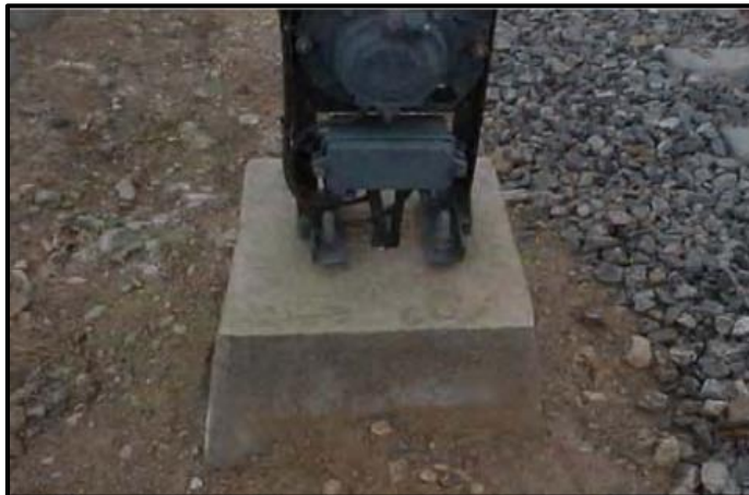
شکل ۶-۲- نمونه‌ای از فونداسیون چراغ پایه کوتاه
