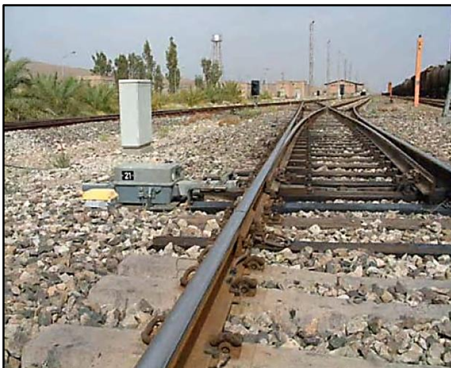
شکل ۵-۲- نمونه‌ای از یک DC و DB ماشین سوزن نصب شده
