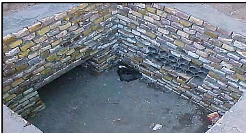
شکل ۳-۲- نمونه یک منهول
