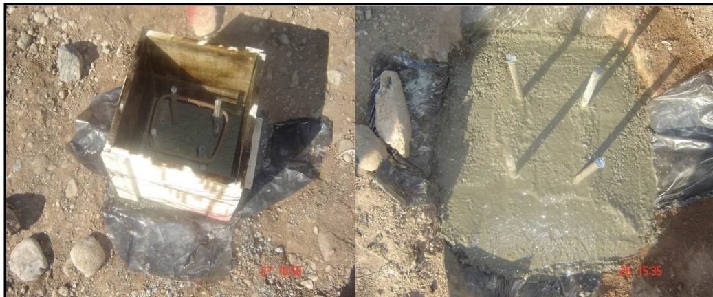
شکل ۲-۵۳- نمایی از نحوه آرماتوربندی و بتن‌ریزی ایستگاه‌ها
