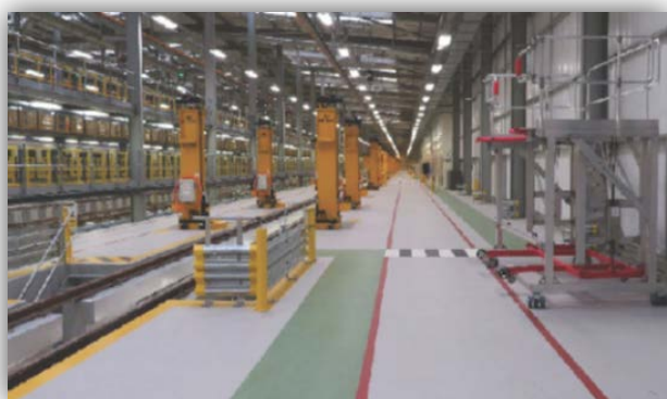
شکل ۲-۱۸- نمونه پوشش و کف سازی مناسب فضاهای تعمیراتی
