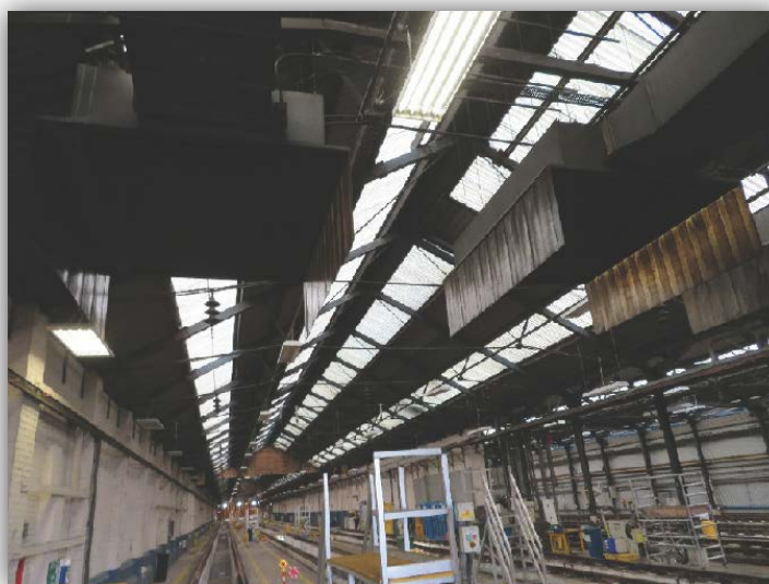
شکل ۳-۳- نمونه‌ای از هودهای سقفی خروج دودهای موتورهای دیزلی
