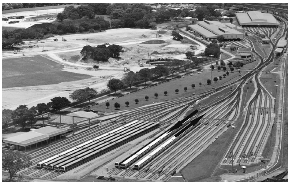
شکل ۲-۲- نمونه دپوی مترویی - ورود و خروج قطارها به خطوط پارکینگ از یک سمت انجام می‌شود.
