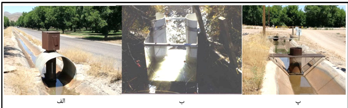
شکل ۴-۲۳- تصاویر فلوم‌های ساده اجرا شده. (الف) فلوم مدور (ب) مستطیلی (S-M) (پ) مدول دوزنقه‌ای
