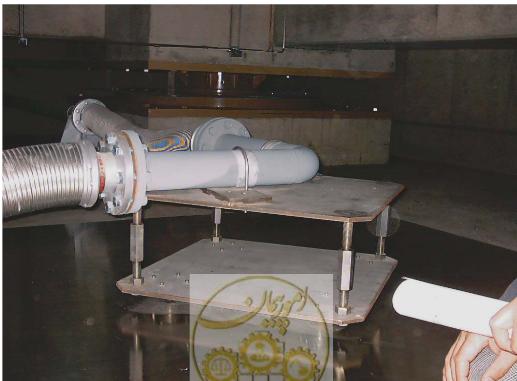
۵-۳-ب- استفاده از تکیه‌گاه متحرک در محل عبور لوله‌های تاسیسات انعطاف‌پذیر از طبقه‌ی جداسازی
