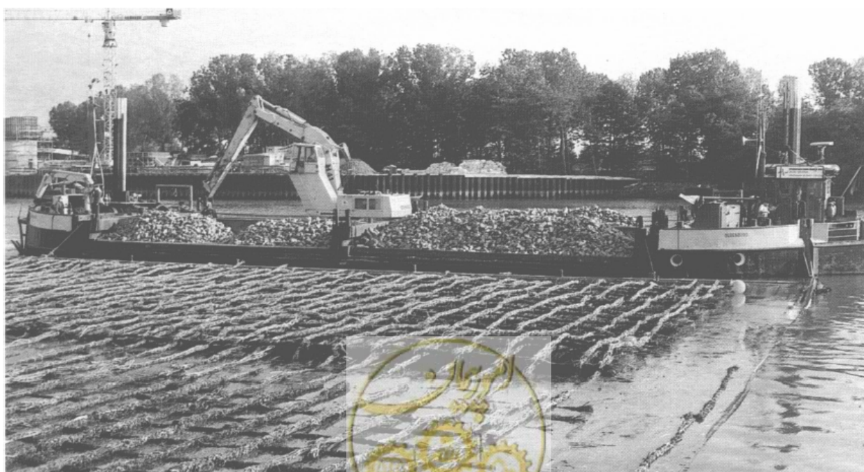
شکل پ-۳-۷- ژئوتکستایل با ملحقات شبکه‌ی چپری (تشک استغراق) (ر.ک. ۳-۶-۶)
