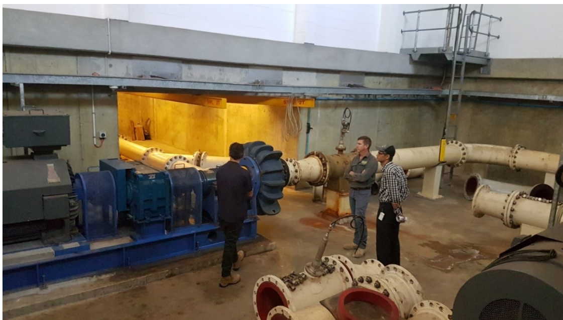
شکل ۲-۶- نمایی از داخل ساختمان پمپاژ سیستم گذردهی رسوب رودخانه توتید
