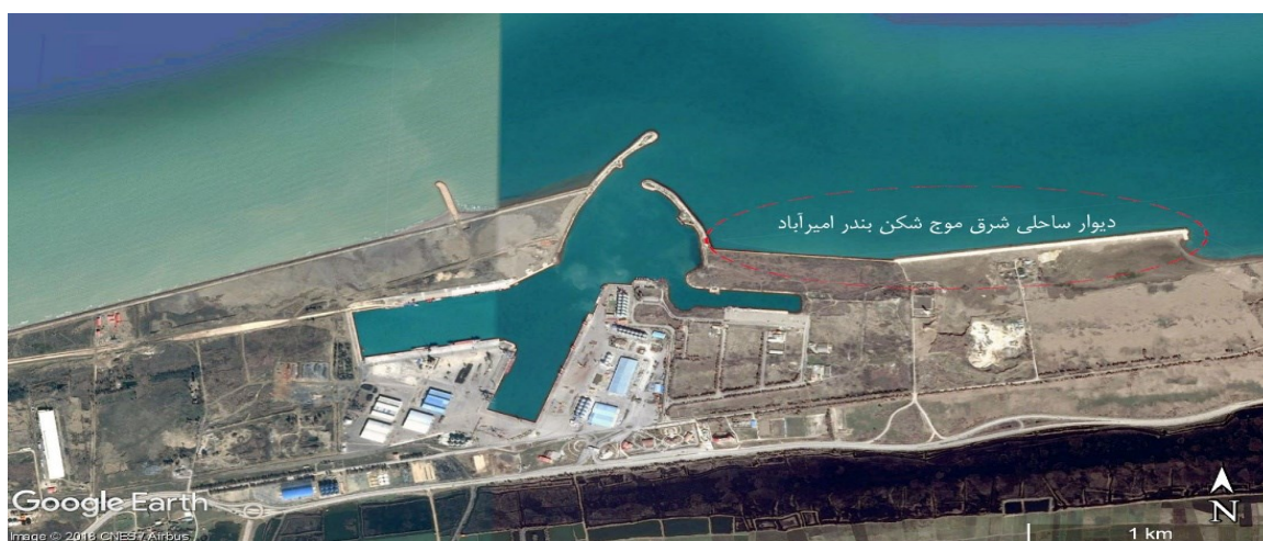
شکل پ. ۴-۱: بندر امیرآباد، انباشت رسوب در غرب بندر و فرسایش ساحل در شرق بندر بعد از اتمام دیوار ساحلی، دیده می‌شود.
