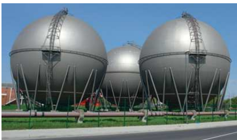
شکل ۳-۴: نمایی از مخازن کروی شکل جهت ذخیره گاز
