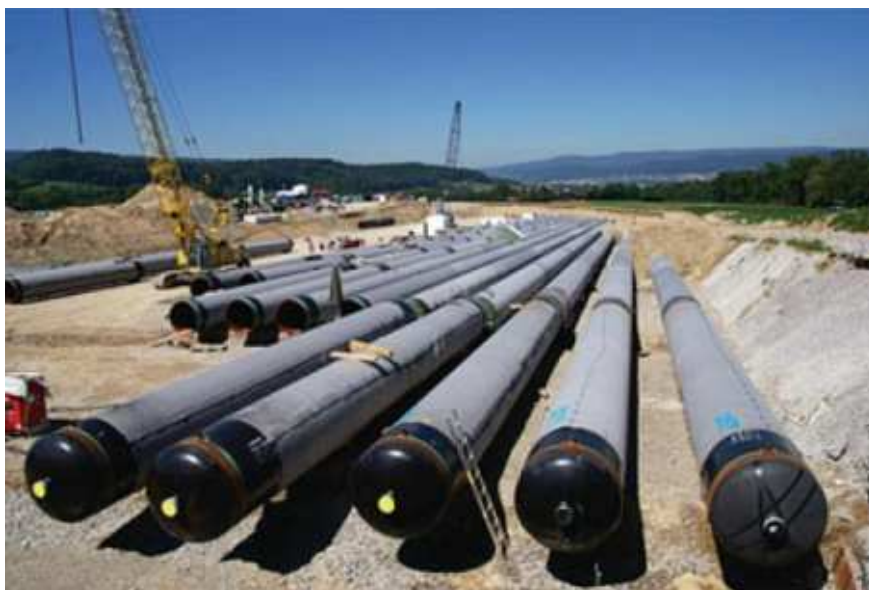
شکل ۴-۴: نمونه‌ای از تأسیسات ذخیره‌سازی لوله‌ای گاز
