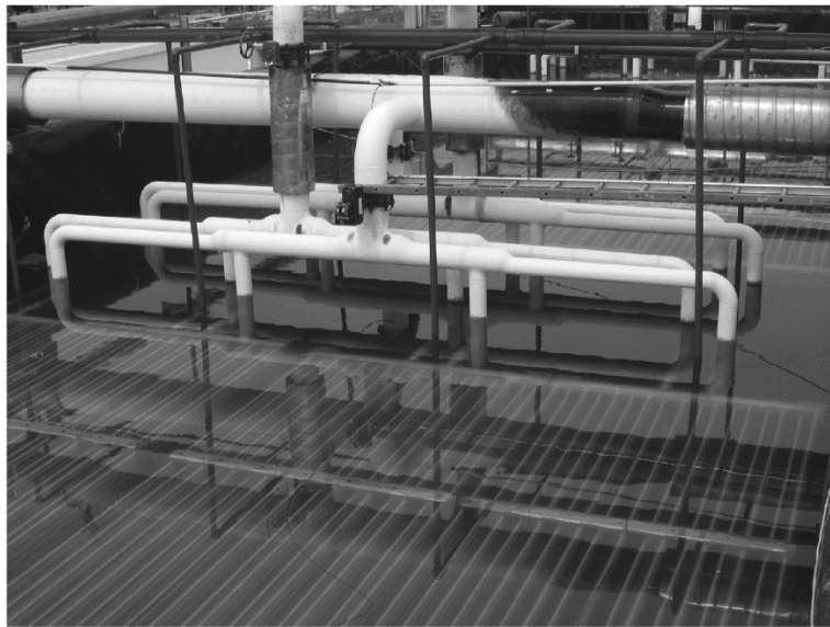
شکل ۸-۳۰: یک نمونه سیستم ذوب از خارج یخ روی کویل در مقیاس بزرگ در کشور مالزی
