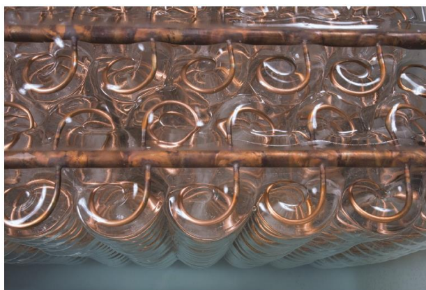
شکل ۸-۱۱: یخ موجود بر روی کوئل در یک سیستم ذخیره‌ساز واحد
