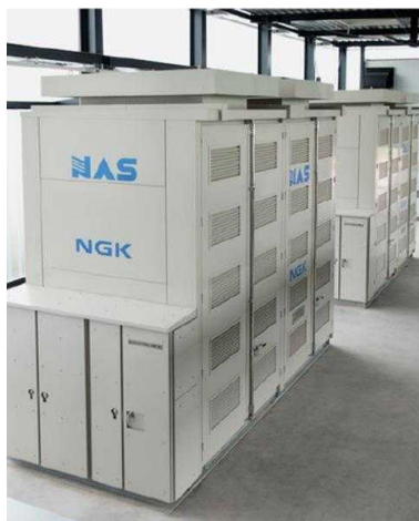
شکل ۵-۶: سیستم بلوک باتری سدیم سولفور نمونه
