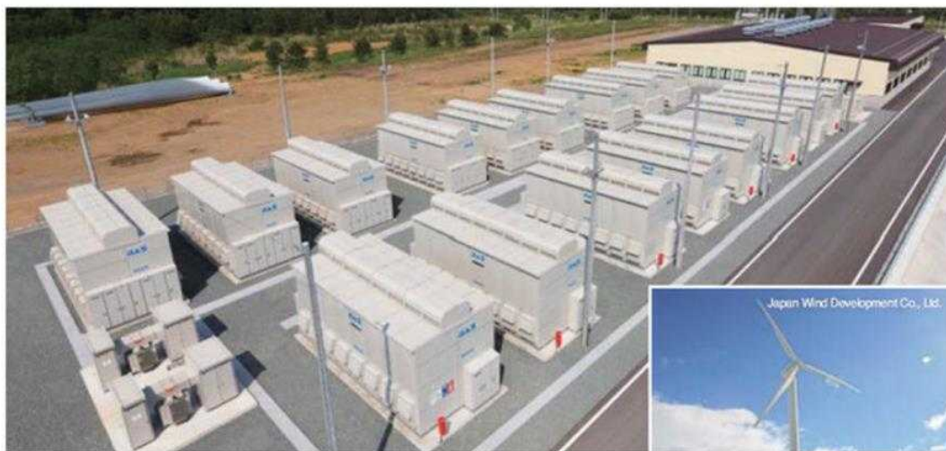
شکل ۵-۸: سیستم بلوک سدیم سولفور با ظرفیت ۳۴ مگاوات
