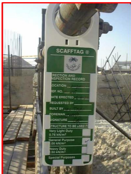
شکل ۵-۱۵- نمونه ای از آویز بازرسی داربست
