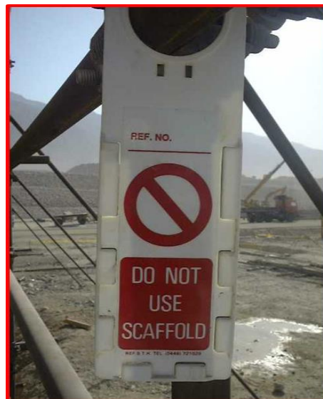
شکل ۵-۱۵- نمونه ای از آویز بازرسی داربست
