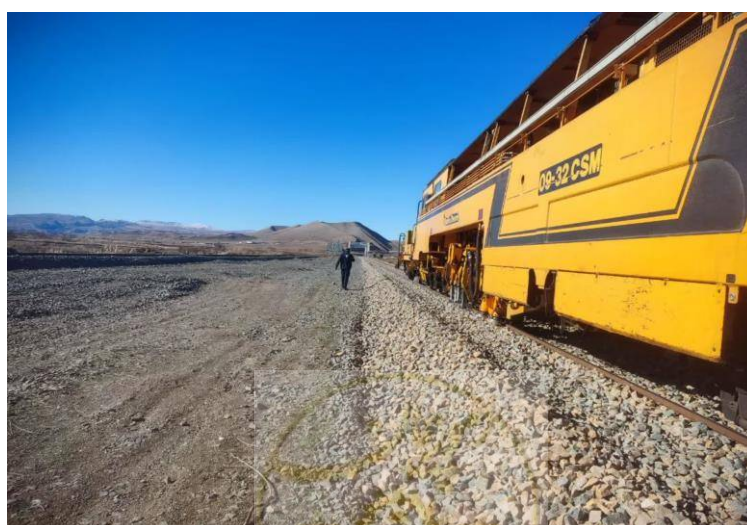
شکل ۱۱-۱- عملیات زیرکوبی خط
