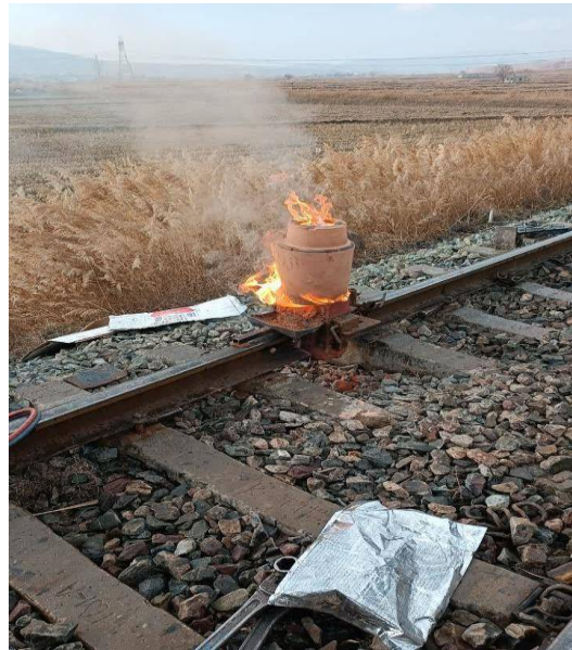
شکل ۱-۲۲- عملیات جوش کاری ترمیت توسط اپراتور
