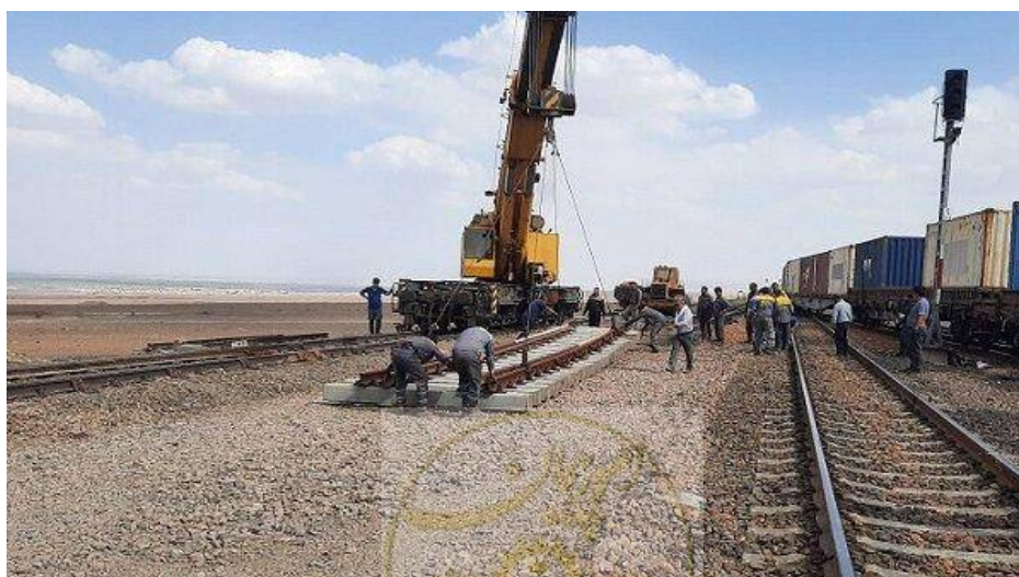
۱-۸- نصب و بهره‌برداری از سوزن‌های بتنی
