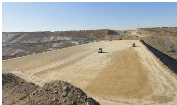
شکل ۱-۶- نمایشی از خاکریزی، خاکبرداری و تسطیح و کوبیدن خط
