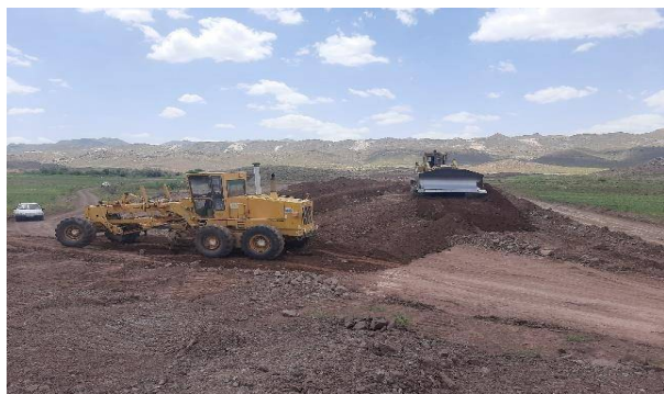
شکل ۱-۶- نمایشی از خاکریزی، خاکبرداری و تسطیح و کوبیدن خط
