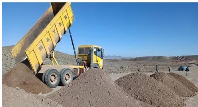
شکل ۱-۶- نمایشی از خاکریزی، خاکبرداری و تسطیح و کوبیدن خط
