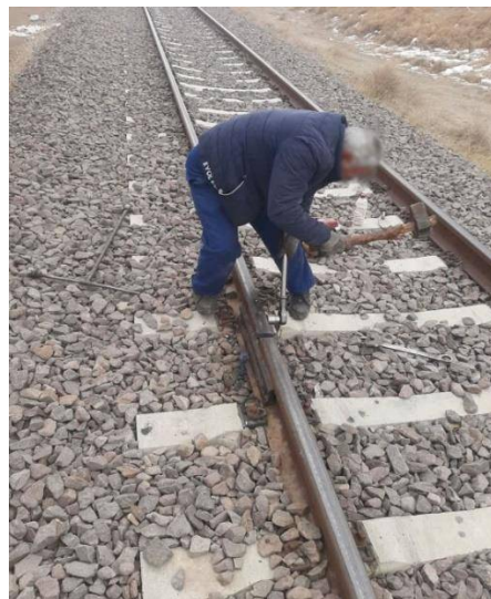
شکل ۲-۱۲- بستن اتصالی محل جوش های شکسته
