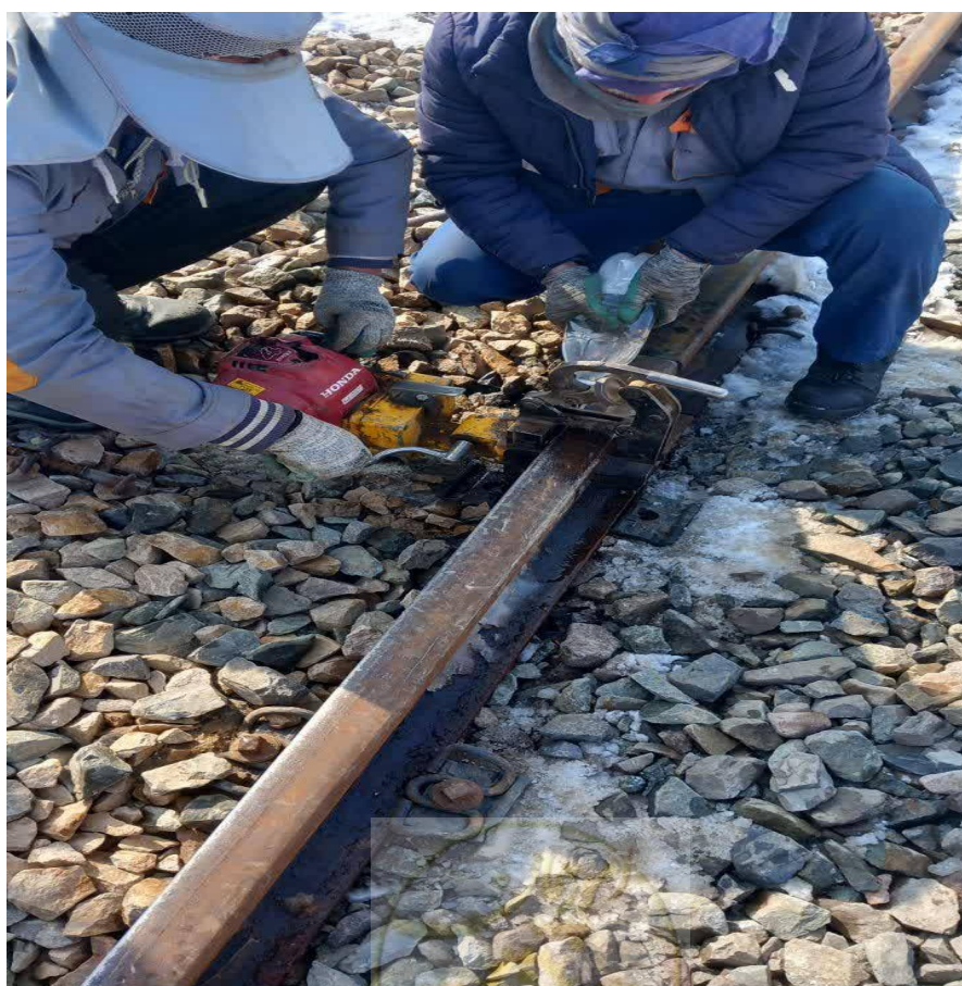
شکل ۲-۱۵- عملیات سوراخکاری ریل
