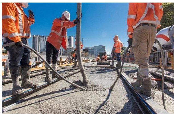
شکل ۱-۲۵- بتن ریزی در روسازی اسلب تراک
