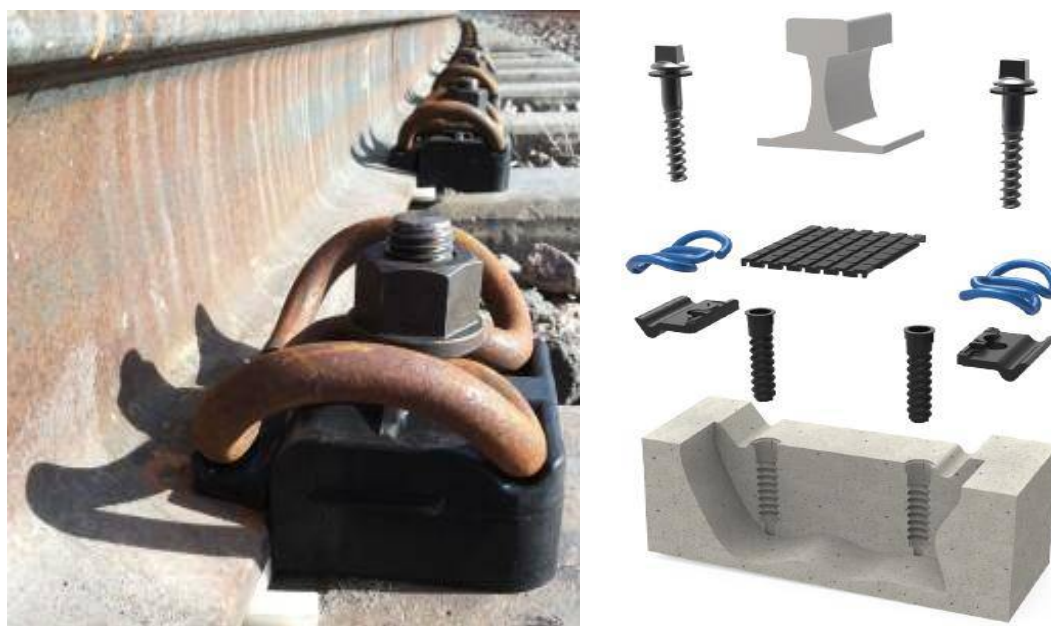
شکل ۲-۱۴- نمونه ای از مجموعه پابندها و اتصالات ریلی
