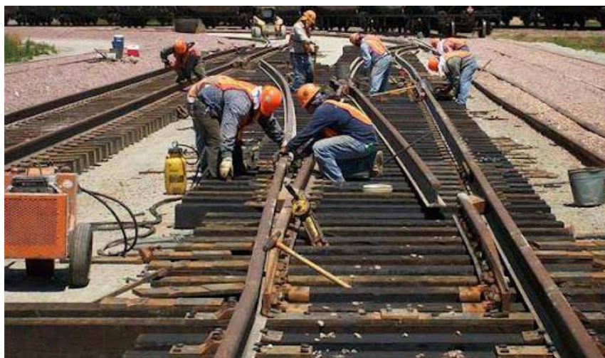
شکل ۲-۶- تعمیرات سوزن
