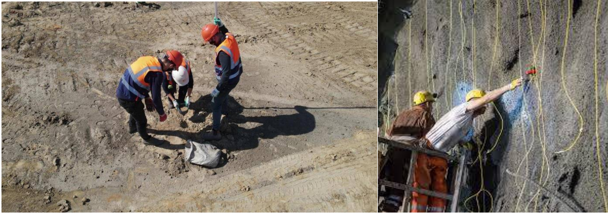
شکل ۱-۸- خرج گذاری تونل و ترانشه های سنگی
