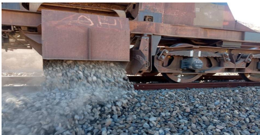
شکل ۱-۷- بالاست ریزی با واگن شکن روی سوزن
