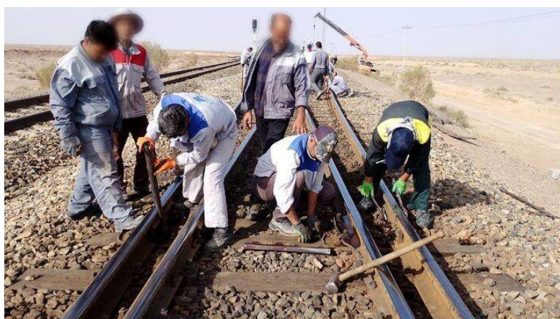
شکل ۲-۱۳- تعویض و نصب سوزن
