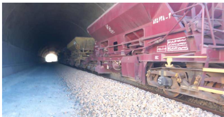
شکل ۱۰-۱- بالاست ریزی داخل گالری
