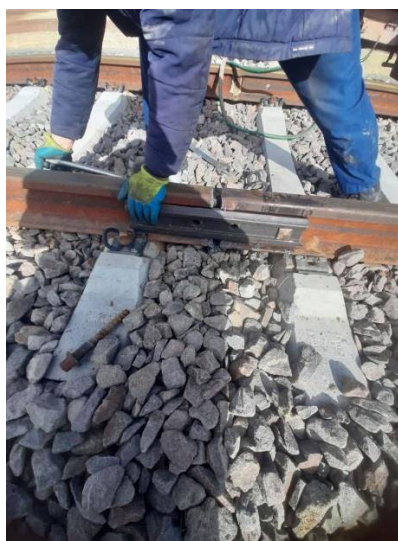
شکل ۲-۱۲- بستن اتصالی محل جوش های شکسته
