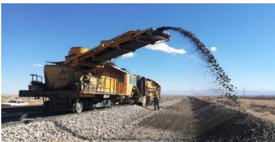
شکل ۳-۲۶- ماشین سرنده بالاست
