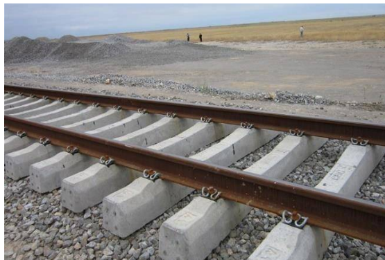
شکل ۲-۱۷- جمع‌آوری ضایعات و پاکیزه نمودن محیط پروژه و خط آماده بهره‌برداری است
