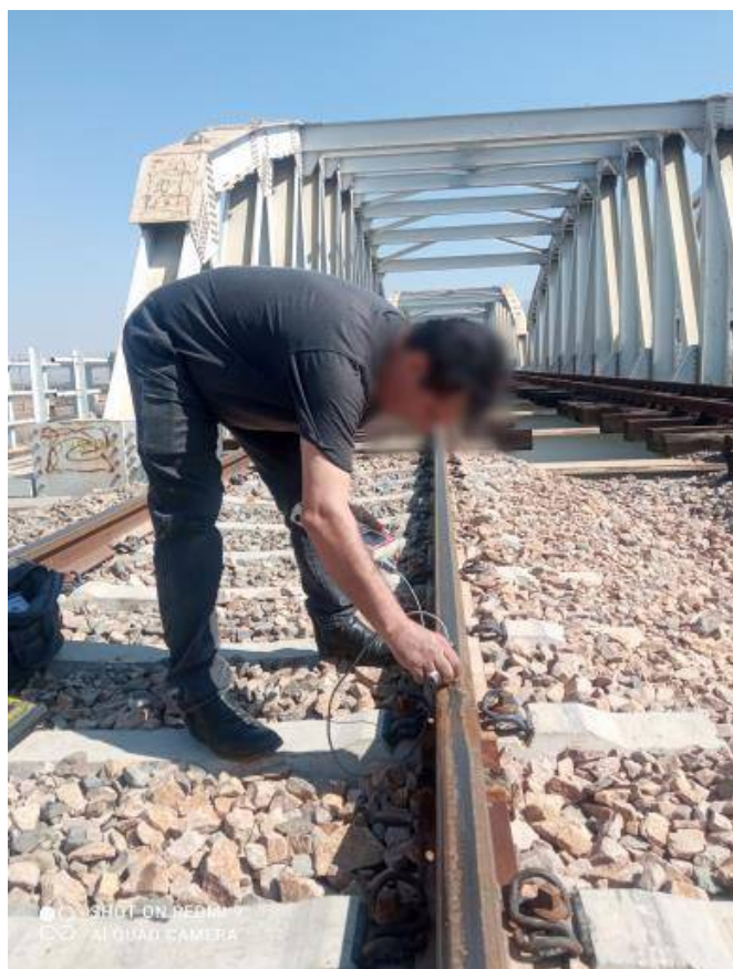
شکل ۱-۲۴- عملیات تست جوش جهت صحت سنجی نصب صحیح ریل
