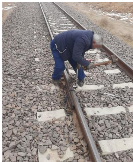
شکل ۲-۱۲- بستن اتصالی محل جوش‌های شکسته
