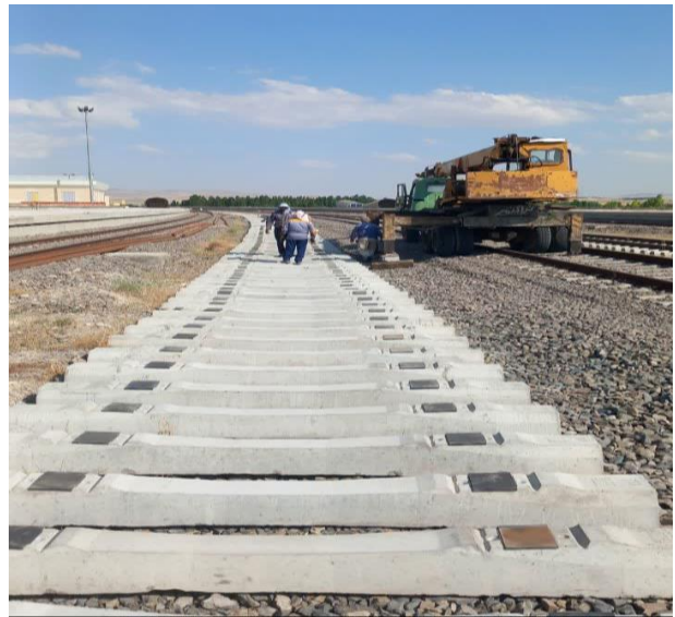
شکل ۱-۹- چیدن تراورس‌ها
