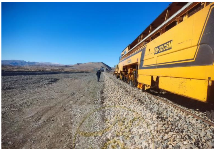
شکل ۱-۱۱- عملیات زیرکوبی خط
