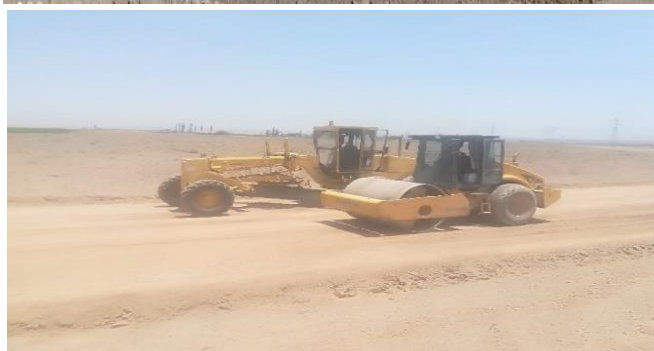
شکل ۱-۷- مثالی از عملیات خاکی
