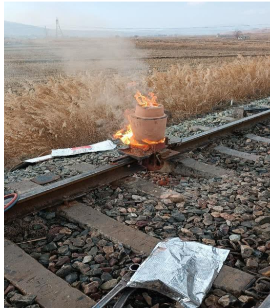
شکل ۱-۲۲- عملیات جوش کاری ترمیت توسط اپراتور
