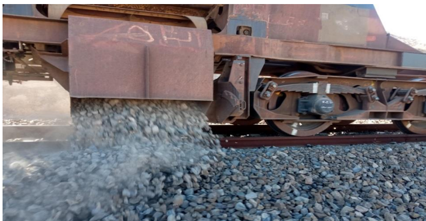
شکل ۱-۷- بالاست ریزی با واگن شکن روی سوزن
