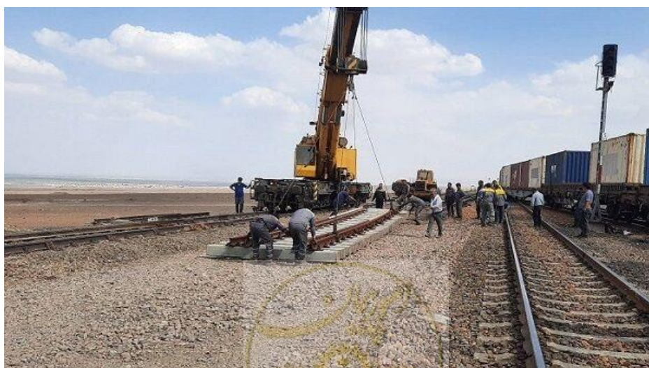
۱-۸- نصب و بهره‌برداری از سوزن‌های بتنی
