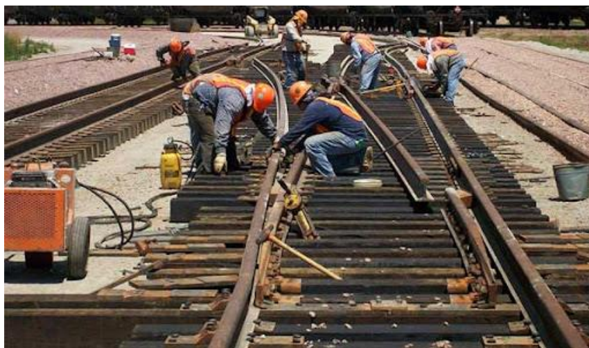
شکل ۲-۶- تعمیرات سوزن
