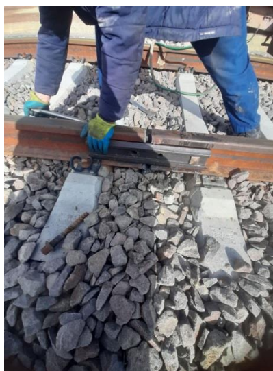
شکل ۲-۱۲- بستن اتصالی محل جوش‌های شکسته
