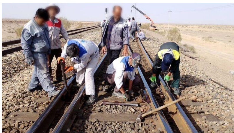
شکل ۲-۱۳- تعویض و نصب سوزن
