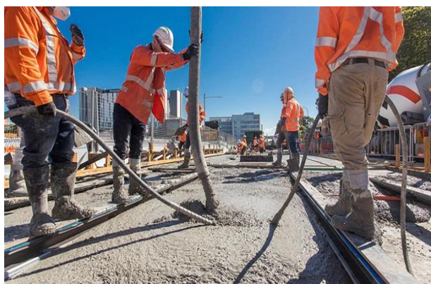
شکل ۱-۲۵- بتن ریزی در روسازی اسلب تراک
