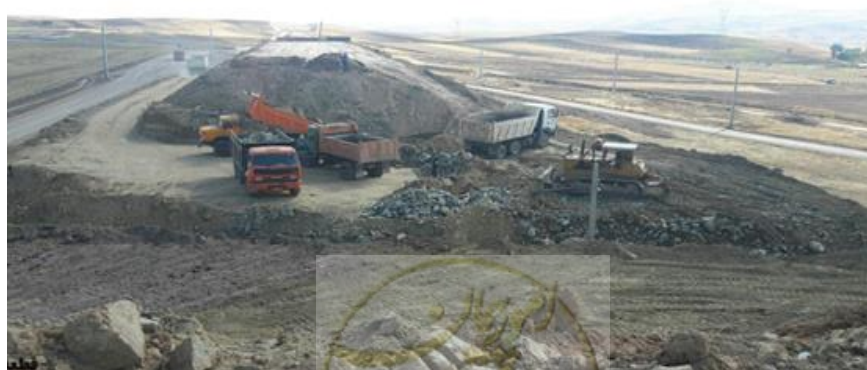
شکل ۱-۲- نمایی از خاک برداری و استفاده از بیل مکانیکی برای خاک برداری
