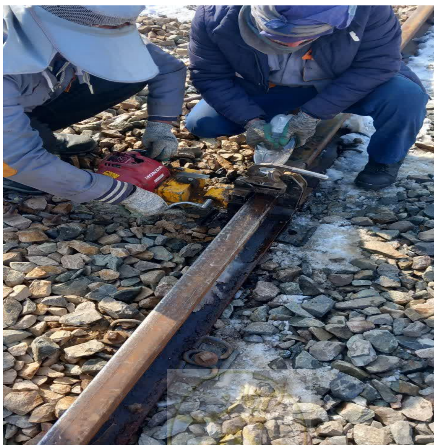
شکل ۲-۱۵- عملیات سوراخکاری ریل
