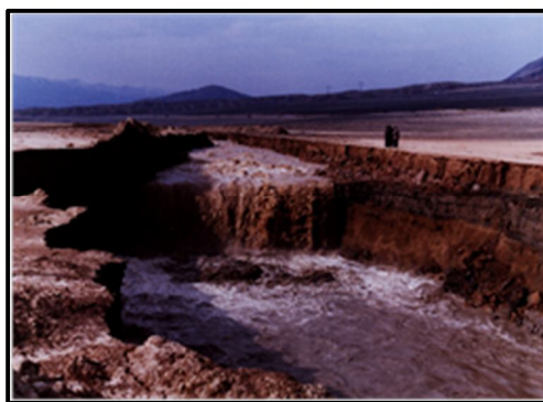
شکل ۱-۷- فرسایش پس‌رونده آبخاری در کانال فرسایشی در حین عملیات رسوب‌دایی منبع: کمیته‌ی رسوب سد سفیدرود
