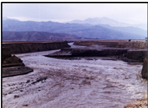
شکل ۱-۶- تعریض کانال تحت اثر فرسایش در حین عملیات رسوب‌دایی منبع: کمیته‌ی رسوب سد سفیدرود
