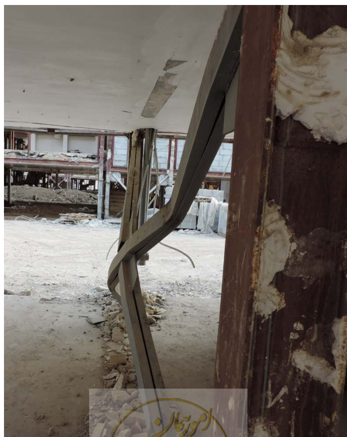
شکل (۴-۱۶): تسلیم مهاربند
