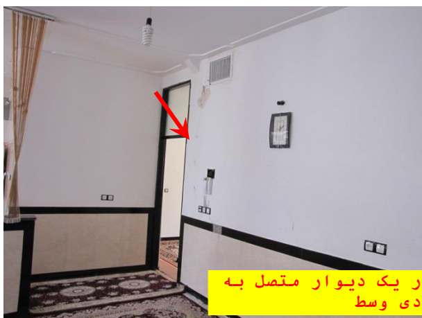
طبقه اول دارای ترک در یک دیوار متصل به ستون فولادی وسط
