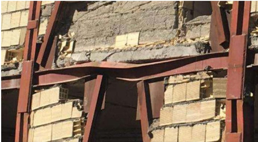
شکل (۴-۲۲): کمانش پیچشی- جانبی و له شدگی تیر پیوند
