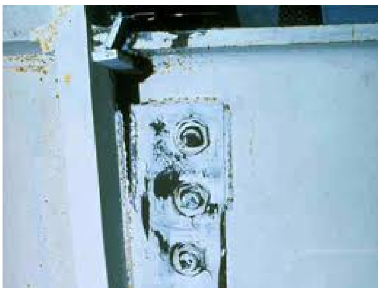
شکل (۴-۳۰): شکست پیچ
