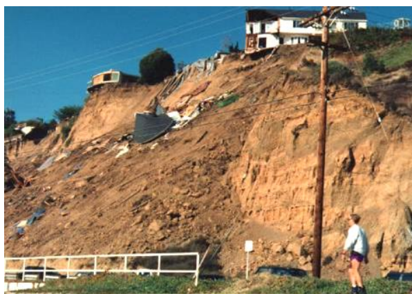
شکل (۷-۳): زمین‌لغزش و تخریب سازه‌های بالا و پایین دست شیروانی
