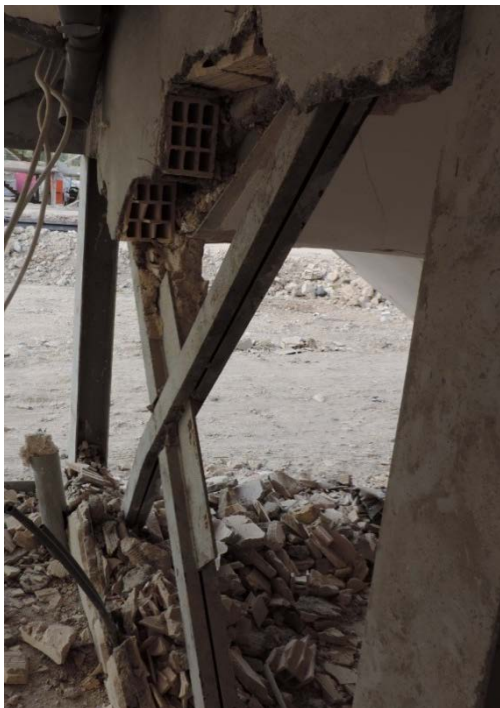
شکل (۴-۱۹): کماتش و طولیل شدگی مختصر مهاربند
