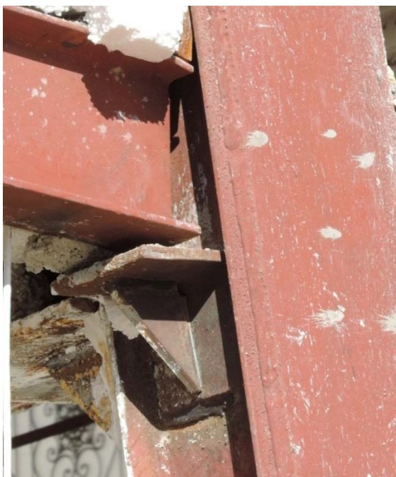
شکل (۴-۲۸): جدا شدن تیر از نبشی نشیمن
