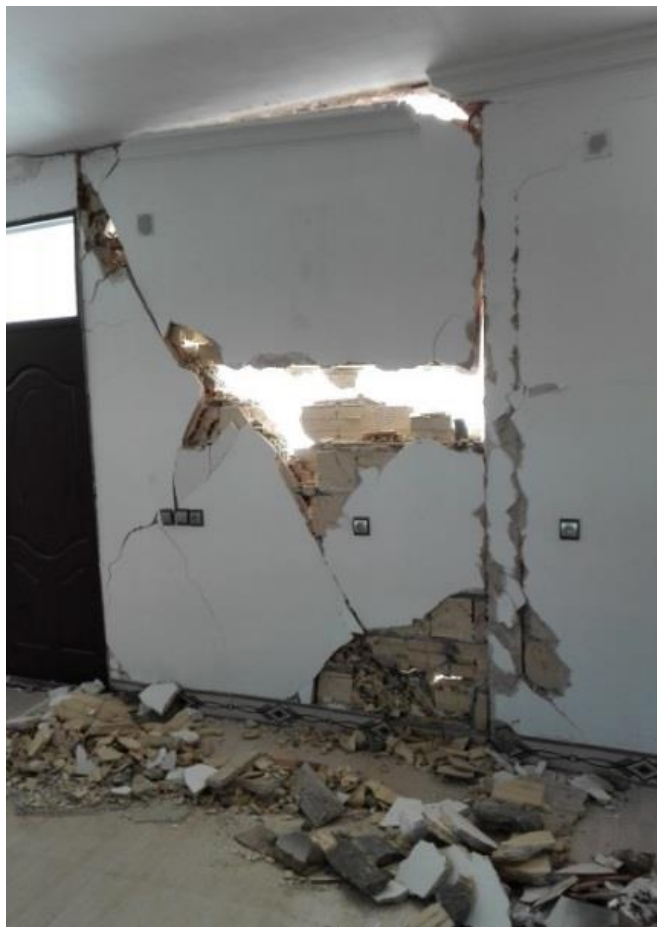
الف) آسیب در دیوارهای جداکننده داخلی ب) آسیب در دیوارهای جداکننده پیرامونی شکل (۳-۸): آسیب وارده و خطر فروریزش دیوارهای جداکننده
