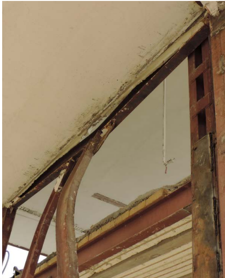
شکل (۴-۲۰): کمانش مهاربند در سیستم مهاربندی واگرا
