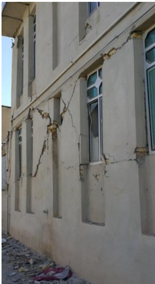
الف) آسیب در دیوارهای جداکننده داخلی ب) آسیب در دیوارهای جداکننده پیرامونی شکل (۳-۸): آسیب وارده و خطر فروریزش دیوارهای جداکننده
