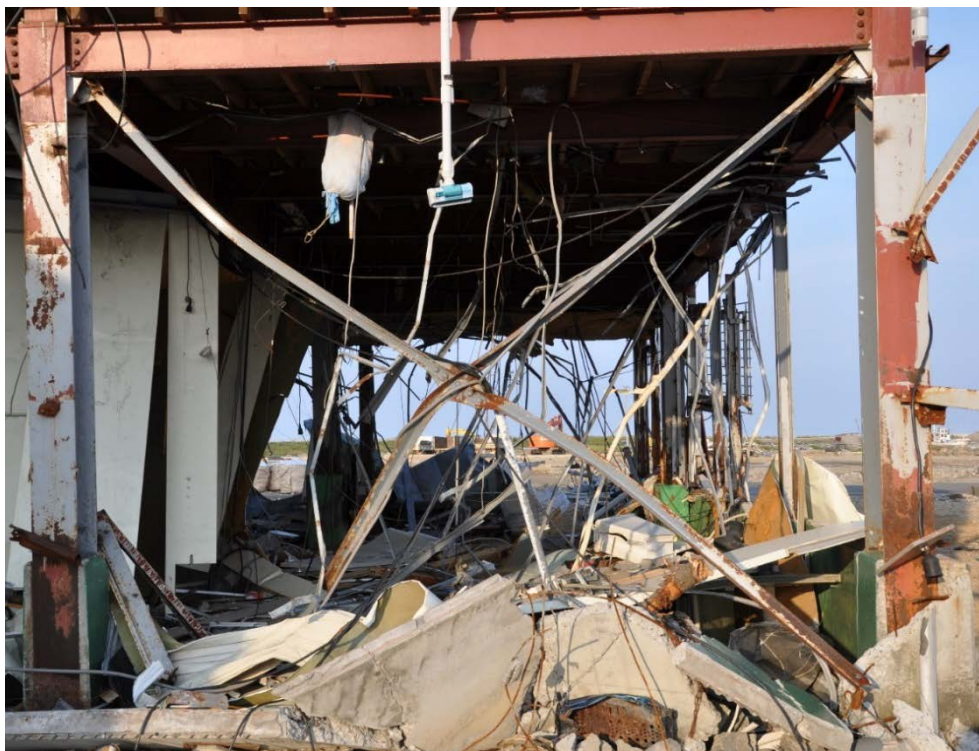
شکل (۴-۱۷): تسلیم مهاربند در ساختمان صنعتی
