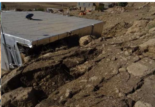
شکل (۷-۳): زمین‌لغزش و تخریب سازه‌های بالا و پایین دست شیروانی
