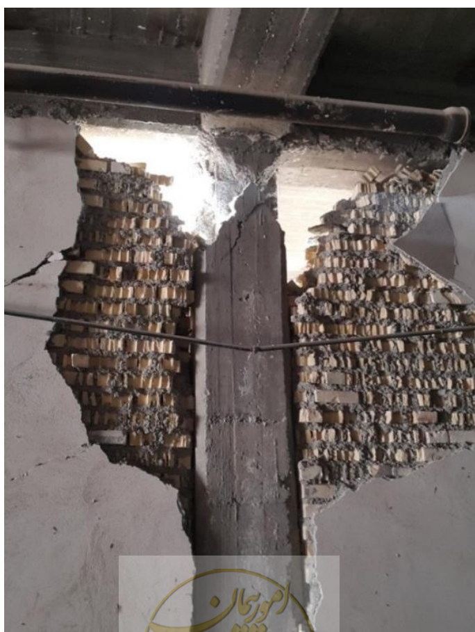
شکل (۵-۶): شکل‌گیری رفتار ستون کوتاه به علت تخریب کنج میان‌تقاب مصالح بنایی متصل به قاب
