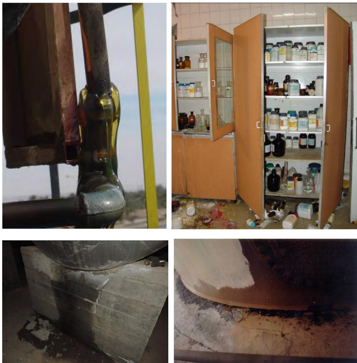
شکل (۸-۱): نشت مواد ذخیره‌ی مخازن، ریختن مواد شیمیایی خطرناک
