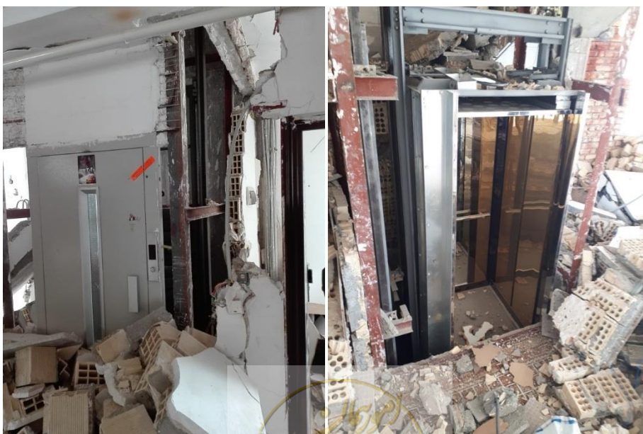
شکل (۸-۷): آسیب‌های وارده به پیرامون و مسیر ورود و خروج بالابرها
