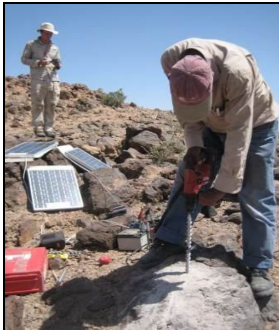
شکل ۲-۳۱- نمونه‌ای از بنای در حال ساخت از نوع پایه پیچ شده
