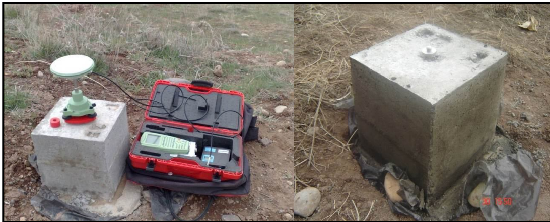
شکل ۲-۵۴- نمای کلی ایستگاه ساخته شده و نحوه قرارگیری GPS دو فرکانسه
