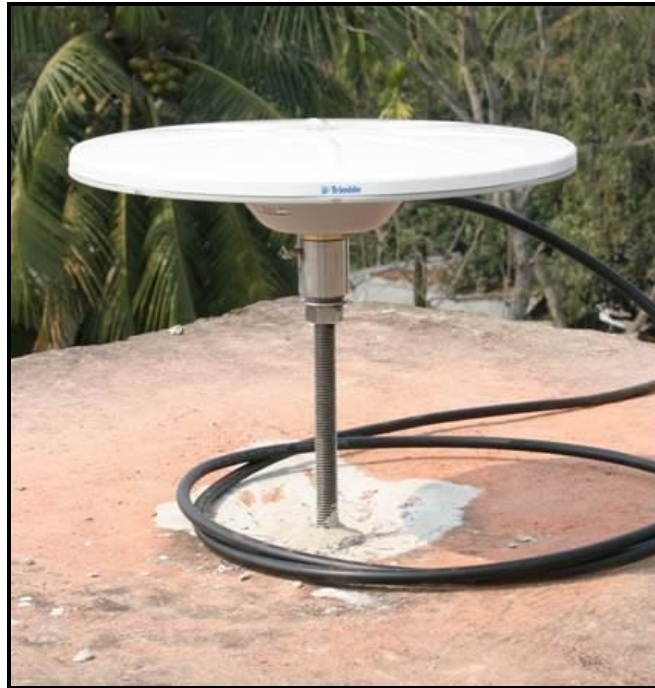
شکل ۲-۳۶- نمونه‌ای از بنای ایستگاه GPS از پایه فولادی
