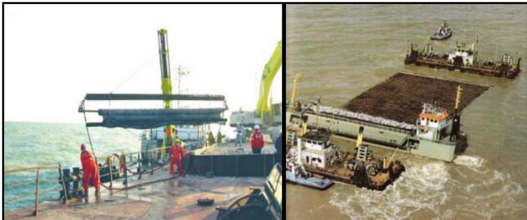
شکل ۳-۷- نصب ژئوسینتتیک‌ها در بستر دریا توسط بارج [۲۰-۲۱]
