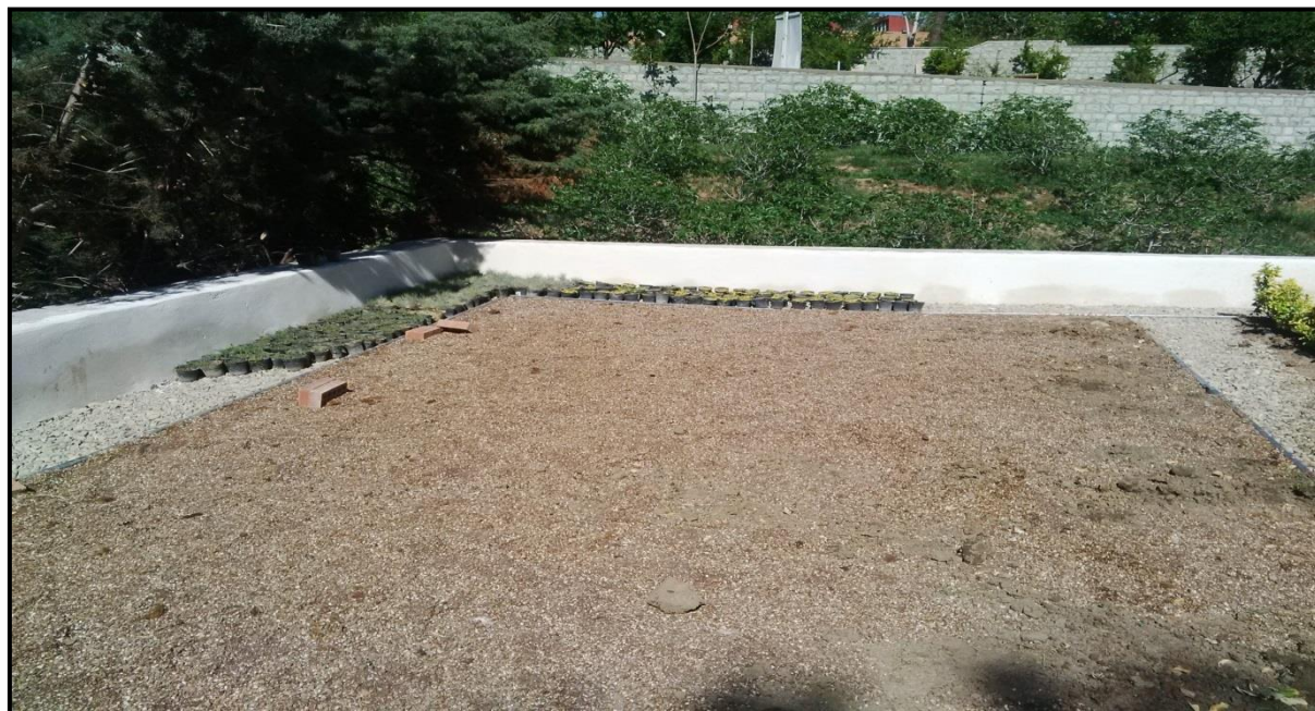
شکل پ.۱-۱۴- اندود بدنه جان پناه و پرکردن محل در نظر گرفته شده برای فضای سبز با خاک
