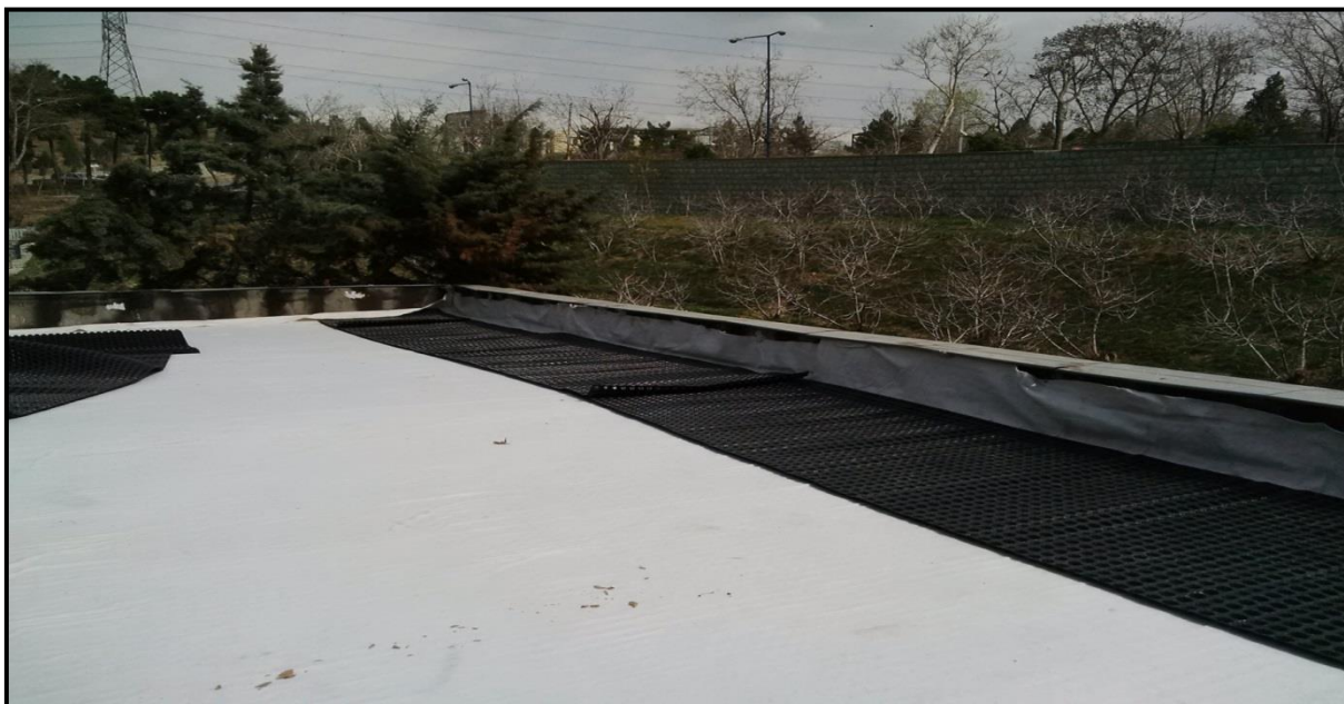
شکل پ.۱-۷- قرار دادن لایه ژئوتکستایل جداکننده؛ پهن کردن این لایه با هم پوشانی ۱۰ سانتی متری بر روی سقف صورت می گیرد. این لایه در بدنه عمودی جان پناه امتداد می یابد.
