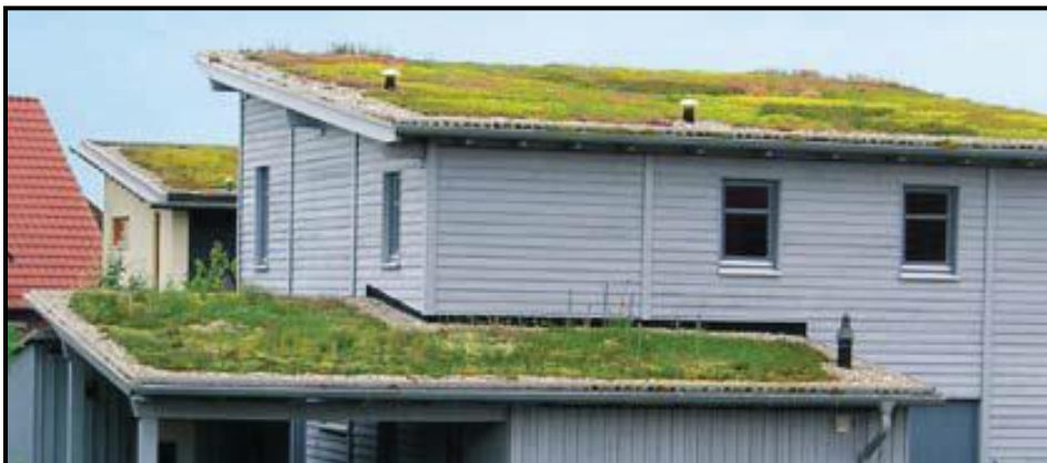
شکل ۲-۱۱- اجرای بام سبز در سقف شیب‌دار
