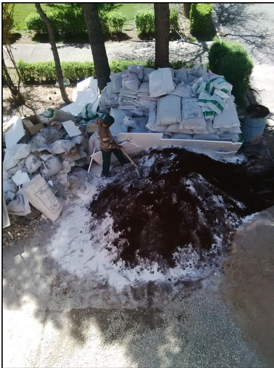
شکل پ.۱-۱۳- ترکیب خاک و انتقال آن به سقف
