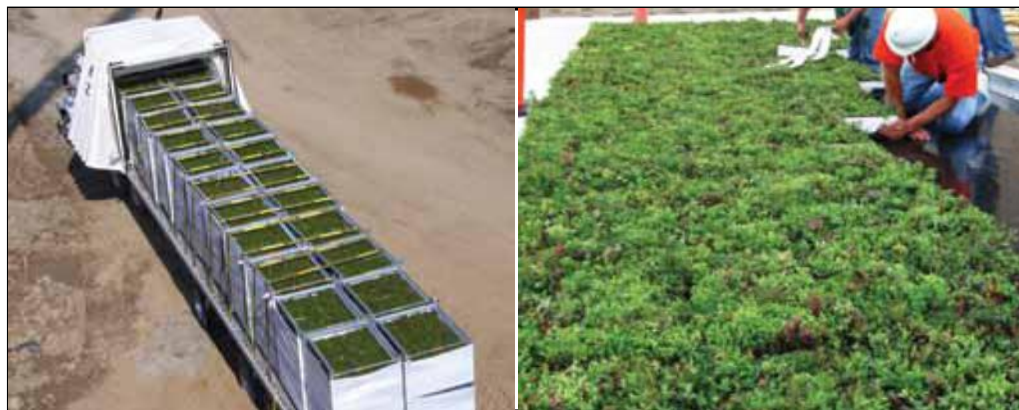
شکل ۱-۷- سیستم بام سبز مدولار
