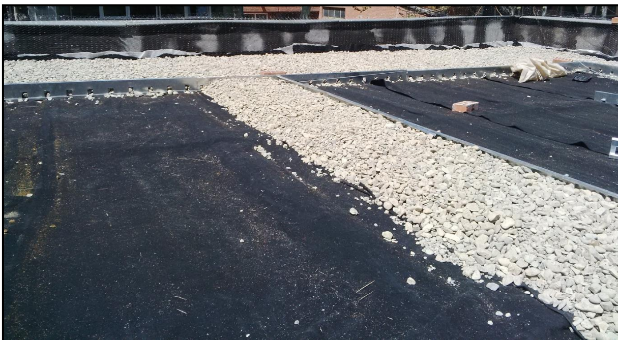
شکل پ. ۱-۱۲- شن ریزی مسیر حرکت
