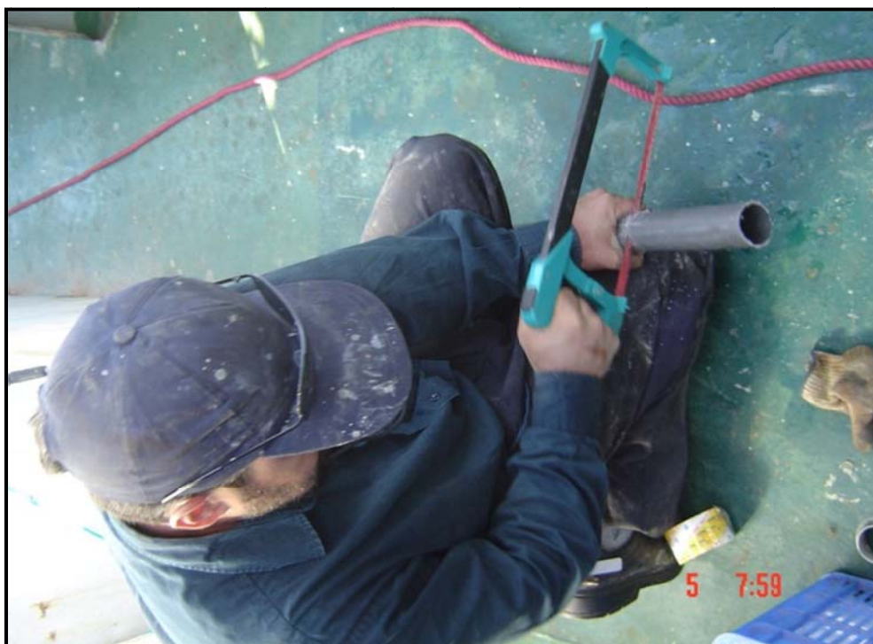
شکل ۲-۱۴- برش بخش اضافی لوله پی وی سی
