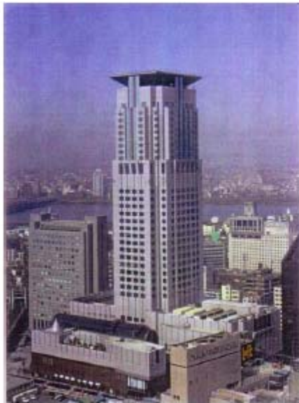
شکل الف-۴۴- جرم میراگر فعال (AMD) نصب شده بر روی محل فرود هلی کوپتر در یکی از ساختمان های ژاپن
