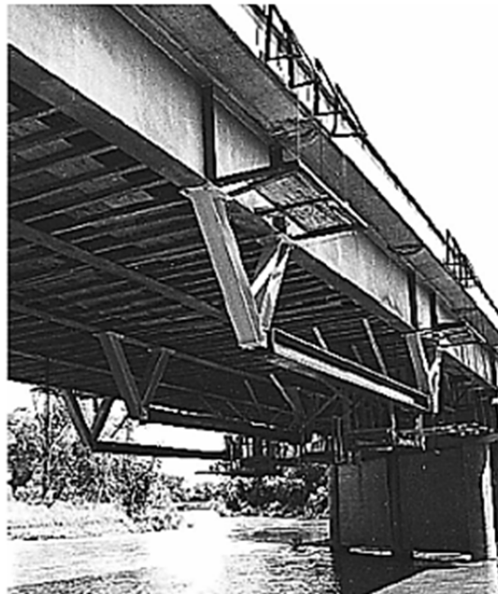
شکل الف-۵۰- میراگر روزنه متغییر نصب شده بر روی پل اینتر استیت در اکلاهاما
