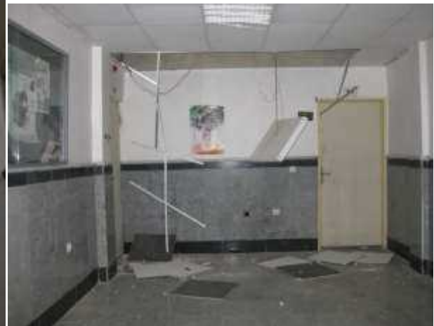
شکل ت ۹-۳- آسیب و سقوط سقف کاذب در ساختمان آموزشی به دلیل عدم کفایت اتصال سقف کاذب به سازه و مهار نامناسب
