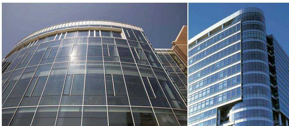
شکل 1-6- نمای شیشه‌ای بیرونی یکسره بدون قطع در کف طبقات
