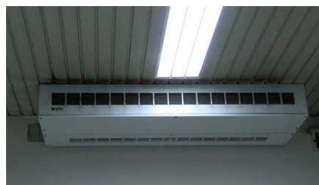
شکل 1-25- واحد تهویه مطبوع داخلی
