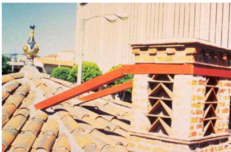
شکل 5-22- نمونه‌ای از نحوه مهار دودکش
