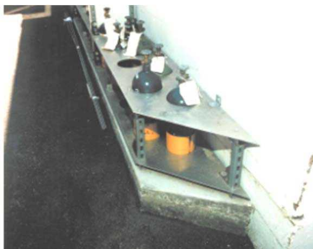
شکل 5-46- نگهدارنده سیلندرهای کوچک گاز
