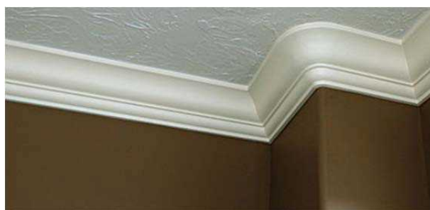
شکل 9-1- پوشش سقف به همراه تزئینات گچبری
