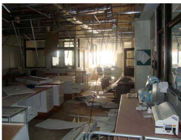
شکل پ 2-9- خرابی کلی شبکه سقف، بلوک‌های گچی سقف کاذب، چراغ‌ها و دیفیوزرها در بیمارستانی با نام لوس انجلس در زلزله 2010 شیلی با بزرگای 8/8
