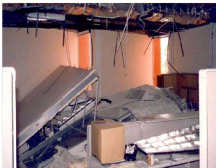
شکل پ 3-2- خرابی پارتیشن‌های اداری، سقف‌ها و چراغ‌های سقف در زلزله نورث ریج 1994
