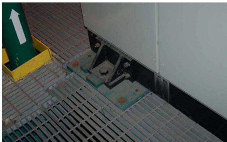
شکل 5-37- نمونه اجرا شده اتصال جزء غیر سازه‌ای به وسیله نبشی
