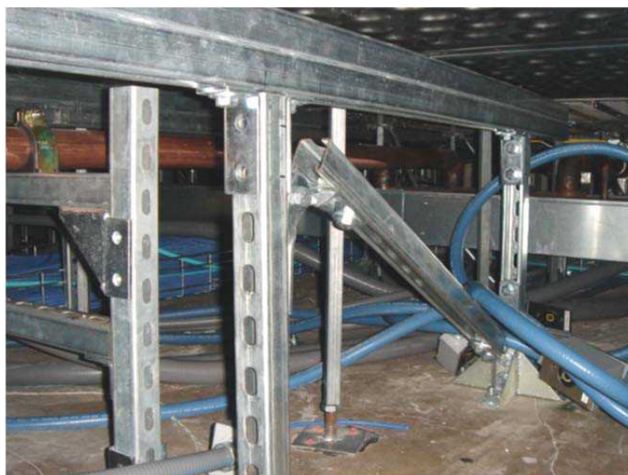
شکل 5-26- قاب بندی فولادی برای مهار کف کاذب
