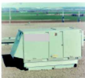
شکل 1-30- واحد هواساز کوچک قرار گرفته بر روی بام
