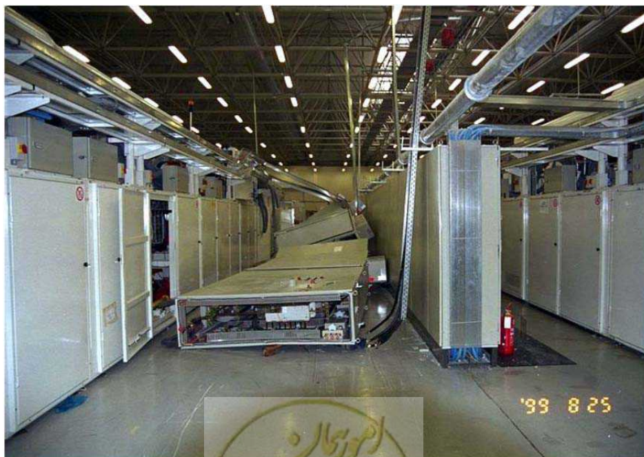
شکل پ 2-22- واژگونی کابین‌های الکتریکی مهار نشده در کارخانه تولید کاغذ در زلزله 1999 ازمیت ترکیه با بزرگای 7/4
