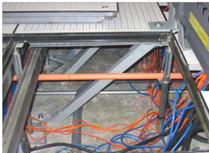
شکل 5-25- نمونه‌ای از نحوه مهار اجزای کف کاذب
