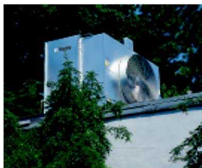
شکل 1-54- کولر با مخزن آب همراه
