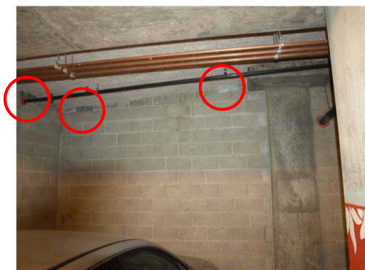
شکل 5-6- استفاده از نبشی برای مهار دیوار در جهت خارج از صفحه
