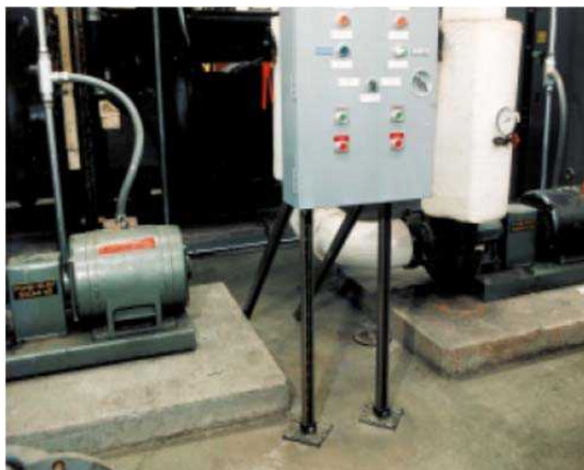
شکل 5-150- اتصال کنترل پانل با مهار (مهار به این شکل کافی نیست)
