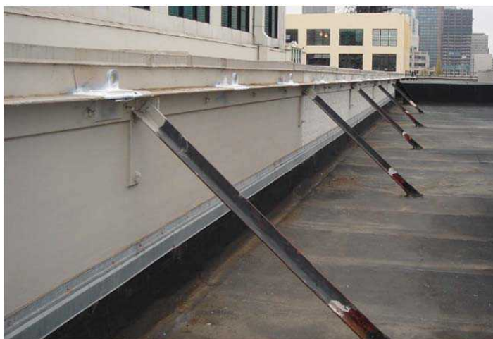
شکل 5-19- نمونه‌ای از نحوه مهار جان‌پناه غیر مسلح بنائی
