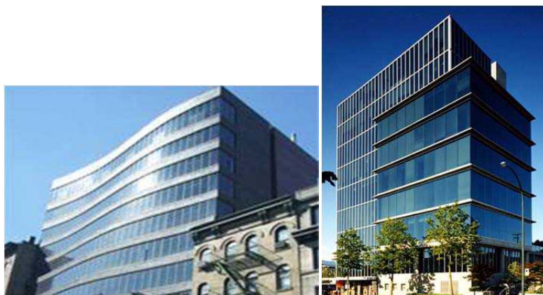
شکل 1-7- نمای شیشه‌ای بیرونی بین کف‌های طبقات
