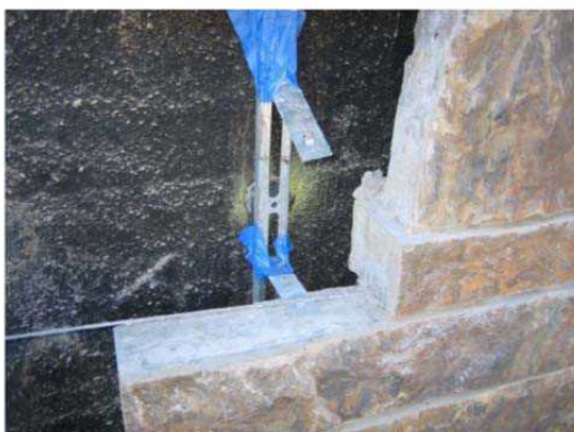
شکل 3-5- نصب نمای سنگی
