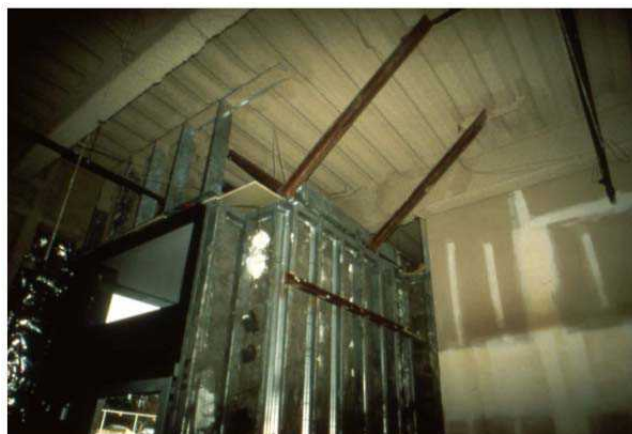
شکل 5-10- مهار پارتیشن با ارتفاع جزئی با چهارچوب فلزی به سقف بالا
