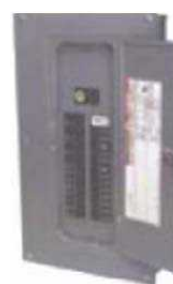
شکل 1-104- مرکز بار (نصب شده داخل دیوار)
