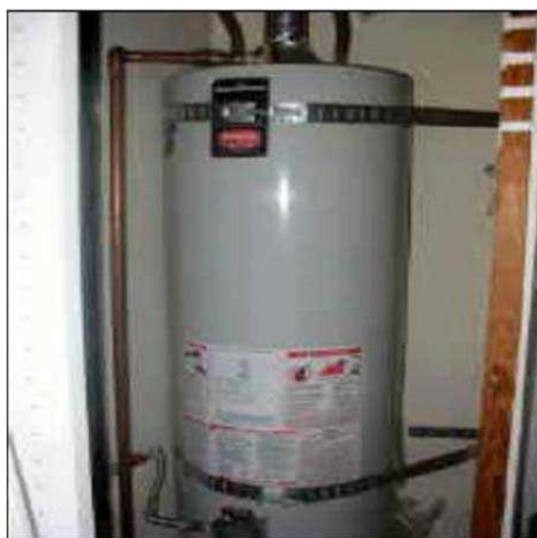
شکل 5-47- اتصال اعضای استوانه‌ای به کمک تسمه کششی
