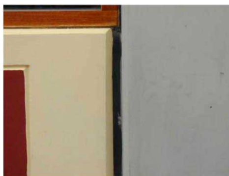
شکل 5-7- جزئیات جداسازی پارتیشن از ستون برای جلوگیری از پدیده "ستون کوتاه"
