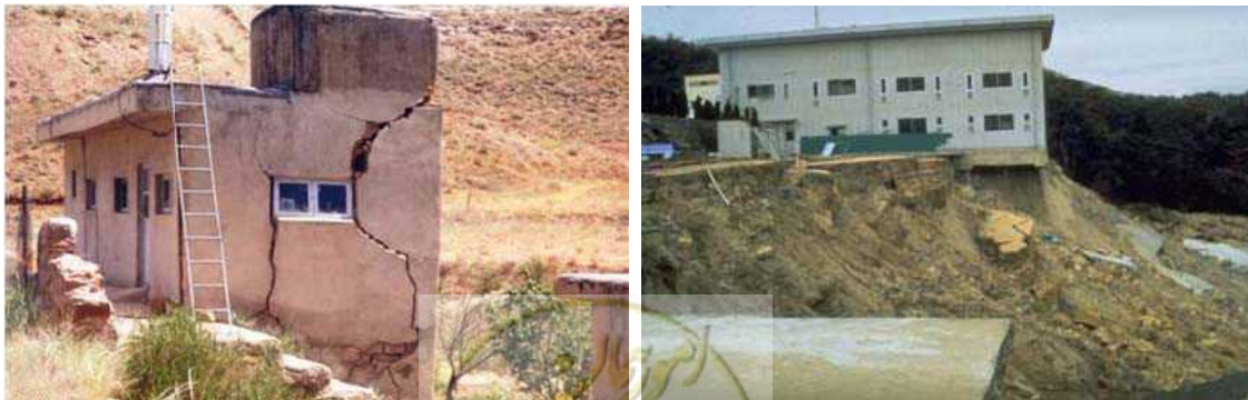
شکل پ-2-6- انتخاب ساختمانی مناسب و اجرای غلط ساختمان بر روی سطح شیب دار
