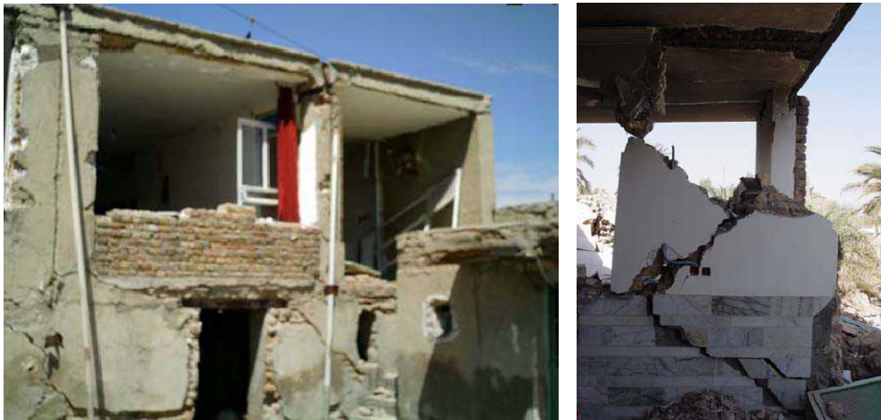
شکل پ-2-19- فروریختن دیوارها و در پی آن سقف
