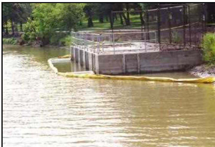
شکل پ.۴-۱۵- استفاده از بوم‌ها برای محافظت از مناطق حساس (مانند تانک‌های ذخیره آب)
