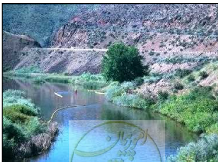
شکل پ.۴-۱۶- انحراف مسیر لکه نفتی به سمت دیگر رودخانه با کمک بوم‌های تجاری
