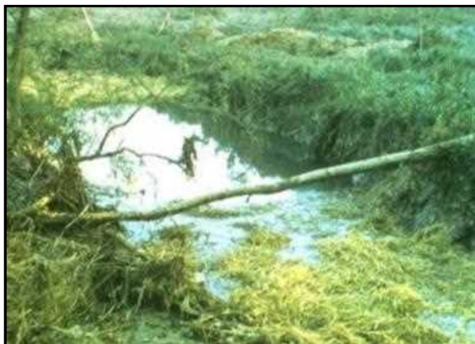
شکل پ. ۴-۱۳- استفاده از شاخ و برگ درختان برای محدود کردن آلودگی و جلوگیری از گسترش بیش‌تر
