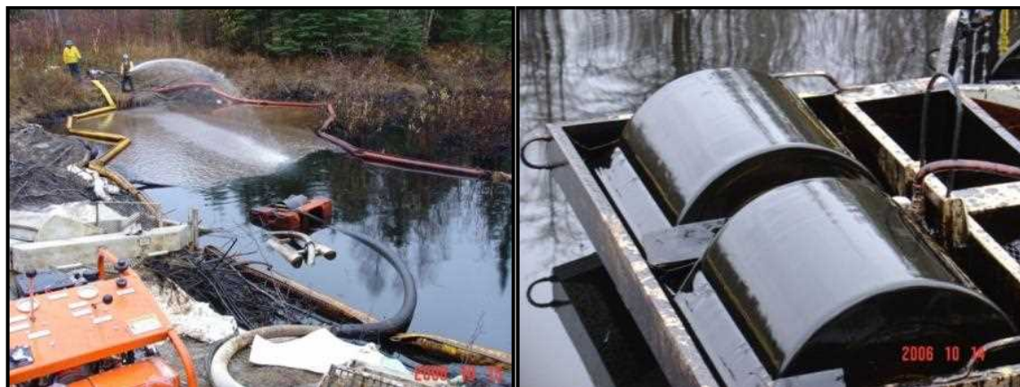
شکل پ.۴-۱- استفاده از تجهیزات جمع‌آوری نفت نشت شده شامل بوم‌ها و اسکیمرها
