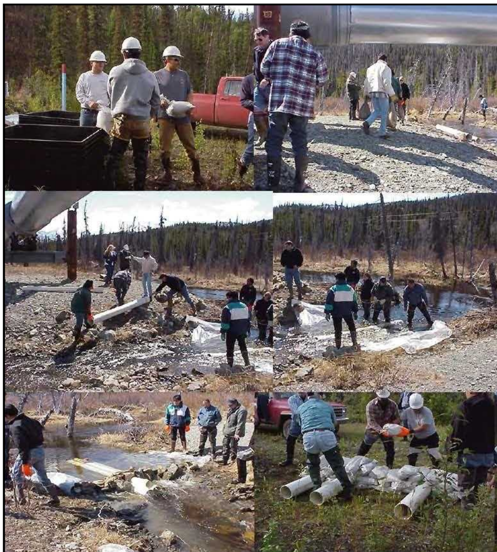
شکل پ.۴-۸- نمونه‌ای از احداث سد‌های کوتاه به منظور عبور جریان و ممانعت از عبور آلودگی
