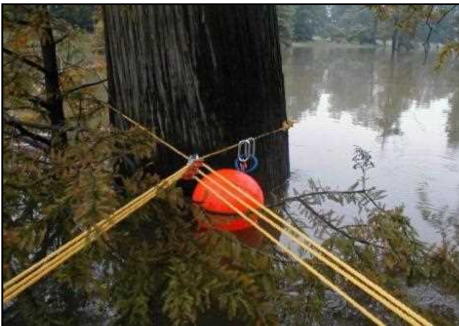
شکل پ.۴-۴- استفاده از تکیه‌گاه‌های طبیعی برای نصب بوم‌ها در مناطق ساحلی
