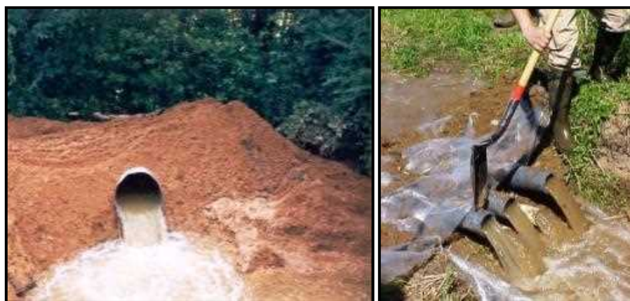
شکل پ.۴-۷- ایجاد سدهای کوتاه و محدود کردن گسترش نفت به مناطق مختلف و عبور جریان از زیر آن
