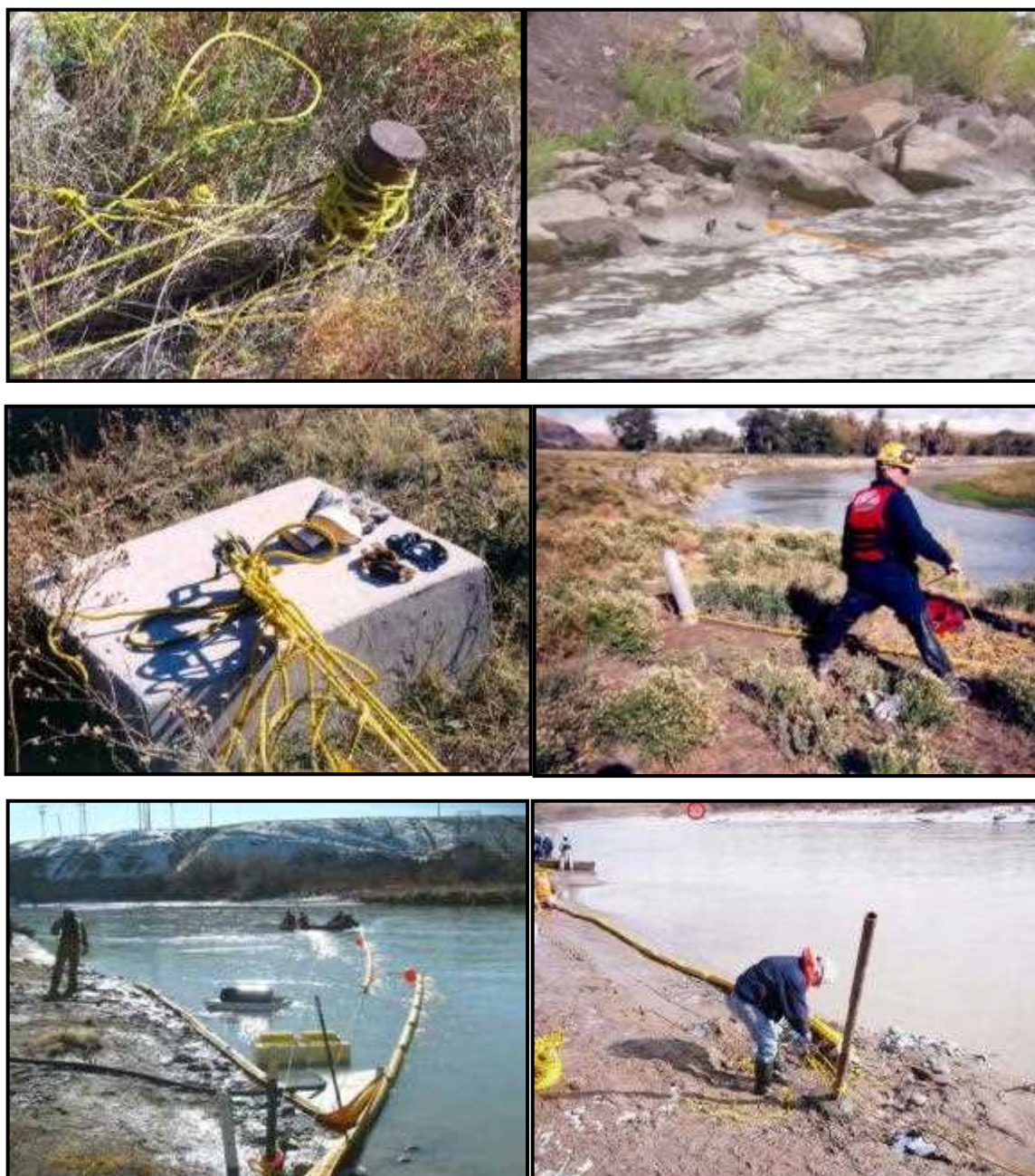
شکل پ. ۴-۴۷- نصب تکیه‌گاه‌های دائمی در کنار رودخانه‌ها به منظور افزایش سرعت بوم‌گذاری در حین مقابله
