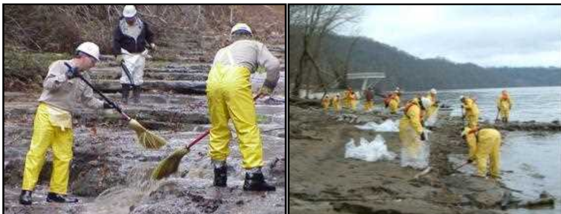
شکل پ.۴-۲- جمع‌آوری نفت از سطح و سواحل دریاچه‌ها با کمک نیروی انسانی و تجهیزات ابتدایی
