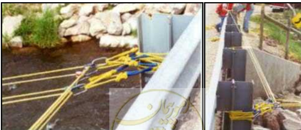
شکل پ.۴-۴- انواع تکیه‌گاه‌ها در بوم گذاری (ساحل به پل)
