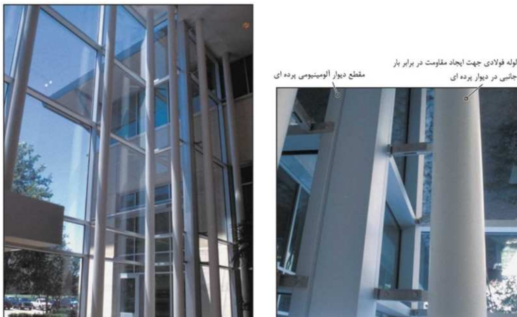
شکل ۸-۱۵- دیوار پرده‌ای بلند، جهت تامین مقاومت جانبی به قاب فولادی سازه متصل شده است
