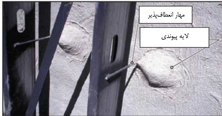
شکل ۶-۳۸ - لایه پیوندی و مهارهای انعطاف‌پذیر
