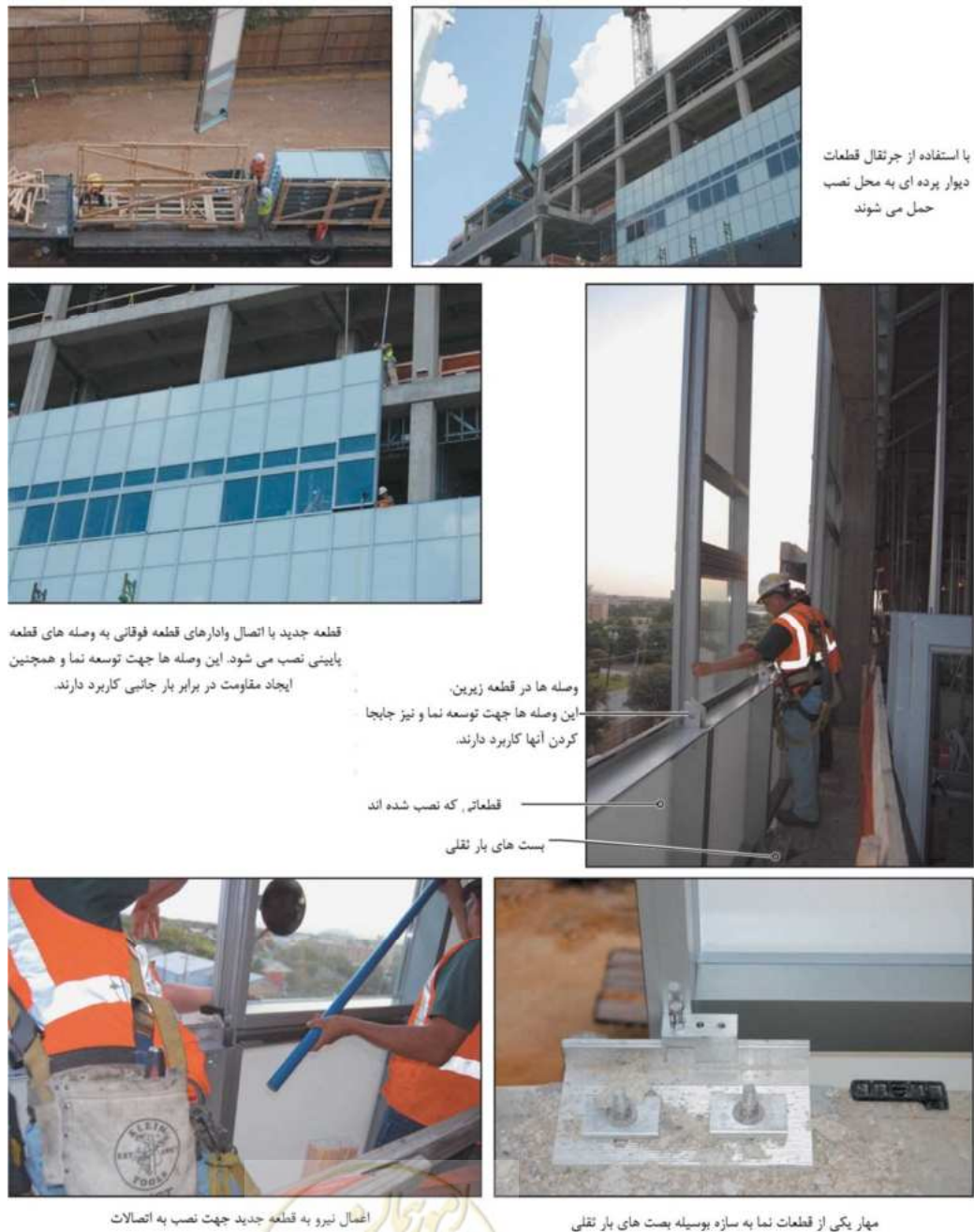
شکل ۸-۱۳ - مراحل نصب دیوار پرده ای یکپارچه
