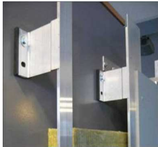
شکل ۶-۴۵- نمونه‌های زیرقاب ساخته‌شده با قطعات آلومینیومی
