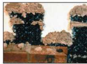
الف- وسیله مهار ملات همراه تکه‌های ملات به گونه‌ای که اجازه می‌دهد آب از آن عبور نموده و روانه حفره‌های زهکشی شود.
