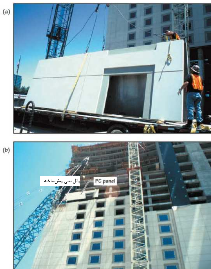
شکل ۶-۲۴ (a) پانل بتنی پیش‌ساخته در حال تخلیه از وسیله حمل (b) پانل در حال نصب در محل مورد نظر روی قاب سازه‌ای
