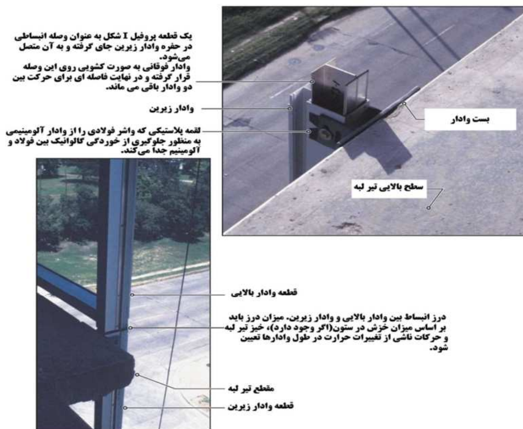
شکل ۸-۸- نمونه اتصال انبساطی بین دو قطعه وادار
