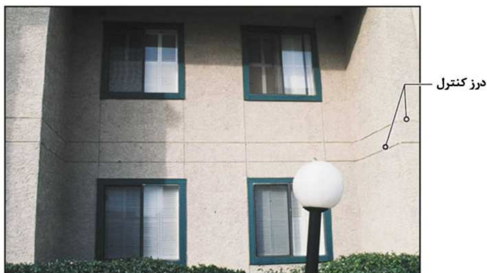
شکل ۶-۸- نمونه درزهای کنترل بر روی نمای سیمانی
