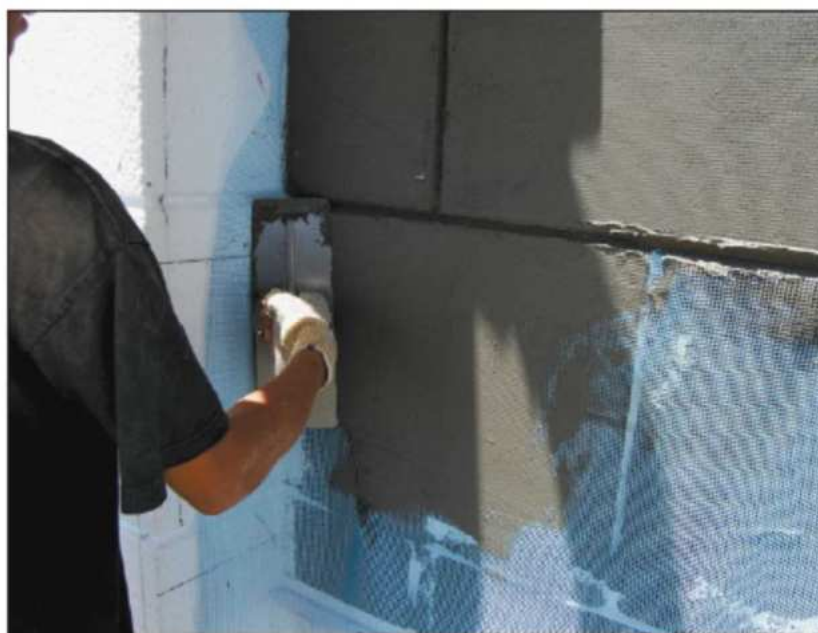
شکل ۶-۱۸- اجرای لایه‌های پوششی
