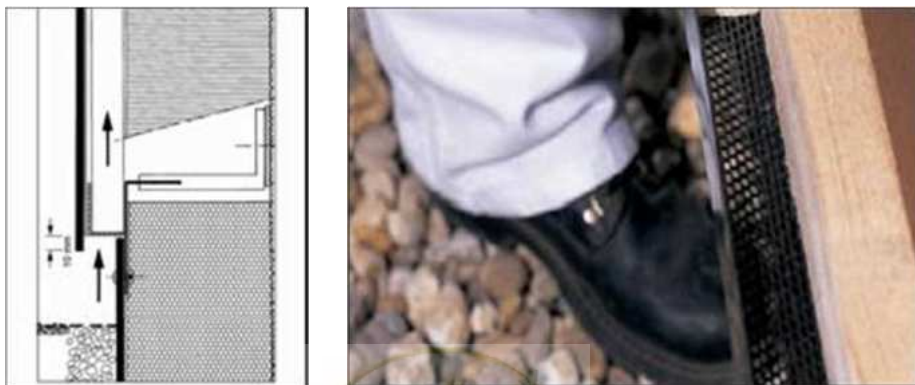
شکل ۶-۶۱- اجرای شبکه توری زیر دیوار
