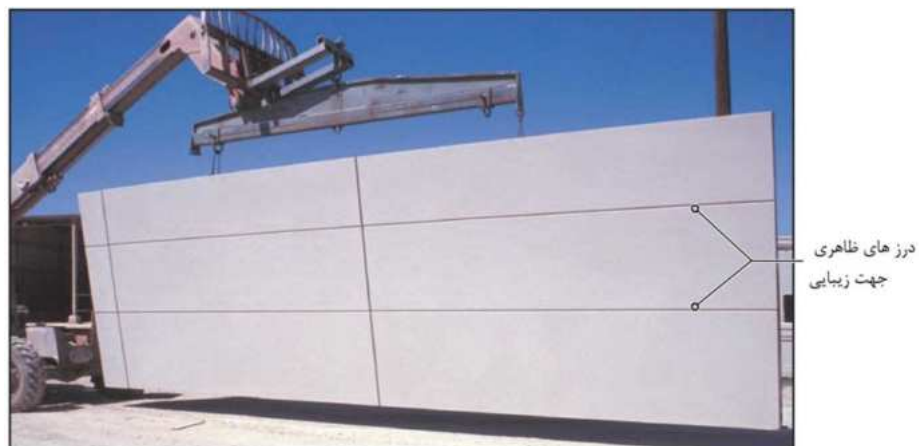
شکل ۶-۳۷ الف - سطح بیرونی یک پانل GFRP، در حال حمل در کارگاه
