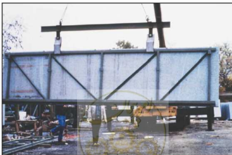
شکل ۴-۲۵- پانل دیواری پرده‌ای پیش‌ساخته سنگی
