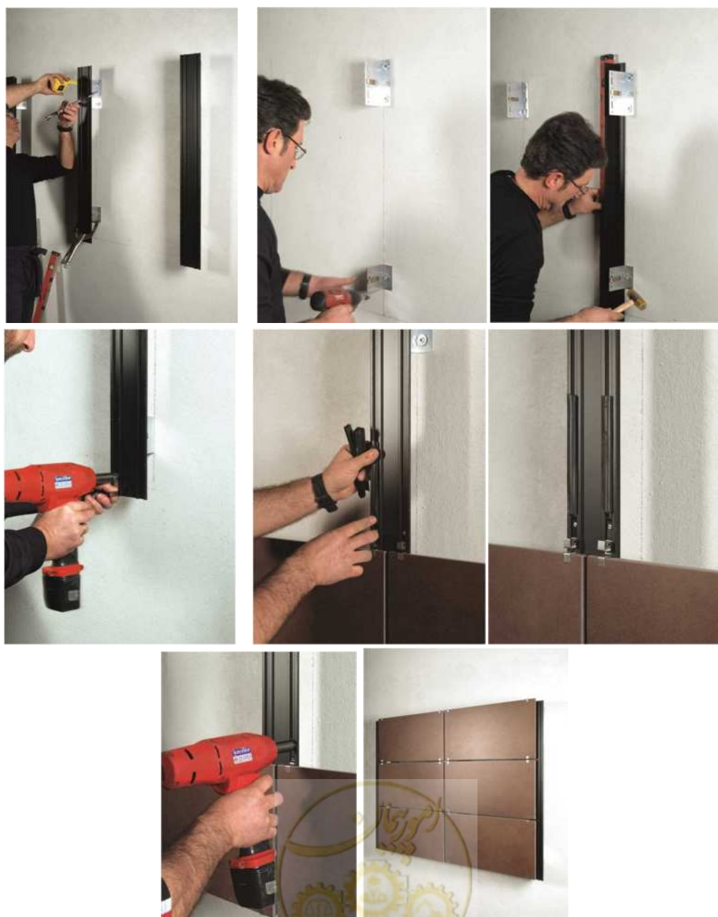
شکل ۷-۲۴- مراحل نصب سیستم نصب نمایان
