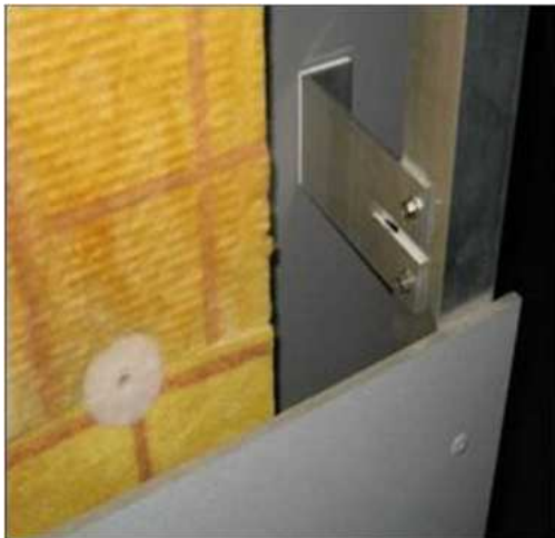
شکل ۶-۴۵- نمونه‌های زیرقاب ساخته‌شده با قطعات آلومینیومی
