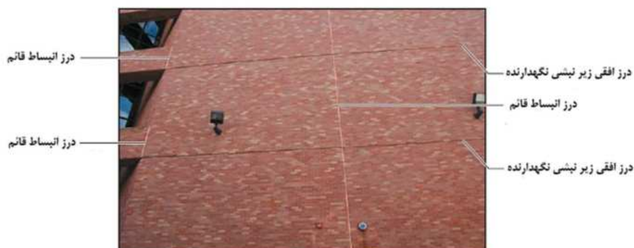
شکل ۵-۱۹- درز انبساطی پیوسته در نمای آجری
