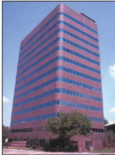
شکل ۵-۲۸- ساختمانی با نما آجری و پنجره‌های پیوسته
