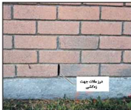
شکل ۵-۱۵- خالی گذاشتن درز ملات جهت زه‌کشی
