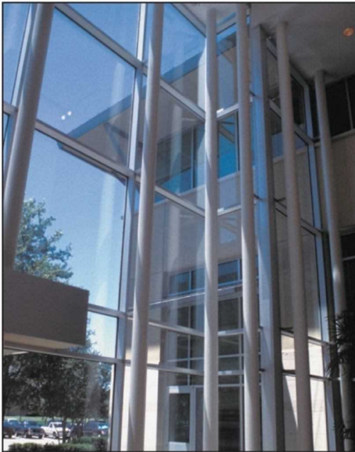
شکل ۸-۱۵- دیوار پرده‌ای بلند، جهت تامین مقاومت جانبی به قاب فولادی سازه متصل شده است
