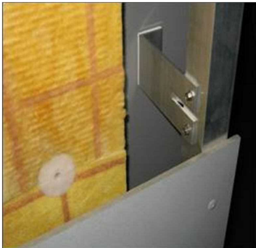
شکل ۶-۴۵- نمونه‌های زیرقاب ساخته‌شده با قطعات آلومینیومی
