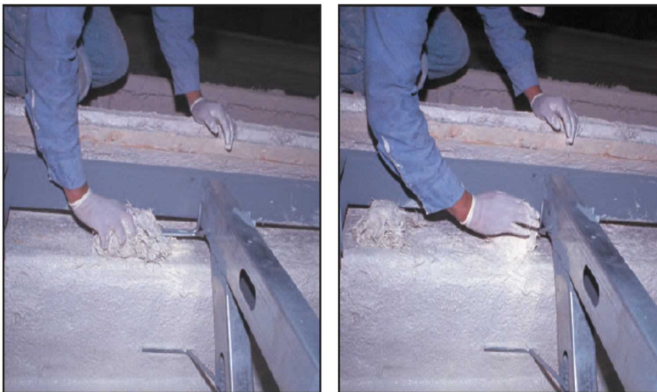
شکل ۶-۴۳- ساختن لایه‌های پیوندی
