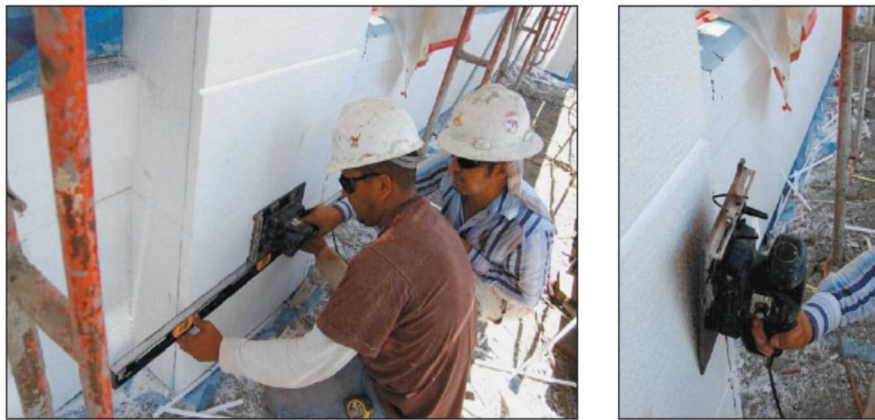
شکل ۶-۱۶- ایجاد شیار بر روی صفحات عایق بعد از صاف کردن
