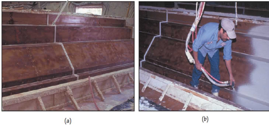
شکل ۶-۴۰-الف) قالب پانل GFRG (ب) پاشیدن لایه آستر بر روی قالب
