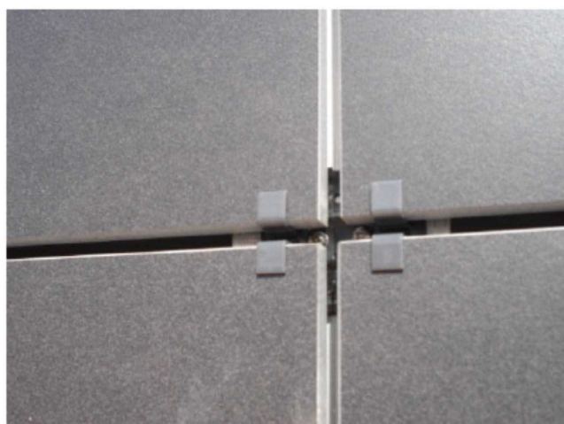
شکل ۷-۲۶- نمایی از سیستم نصب خشک نمایان با استفاده از بتونه و بست مکانیکی
