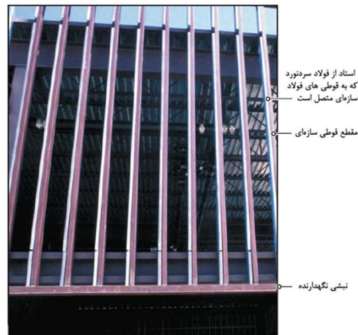
شکل ۵-۳۹- قاب فولادی جهت نصب نمای آجری. قاب فولادی در تراز طبقات به سازه متصل شده است و نبشی تکیه‌گاهی جهت نصب نما به قاب فولادی متصل شده است.
