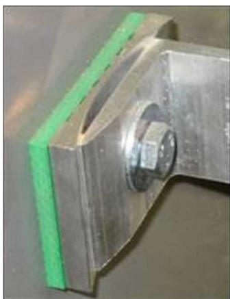
شکل ۶-۴۶- نمونه قطعه اتصال سپری‌های آلومینیومی به دیوار با امکان تنظیم در جهات و زوایای مختلف
