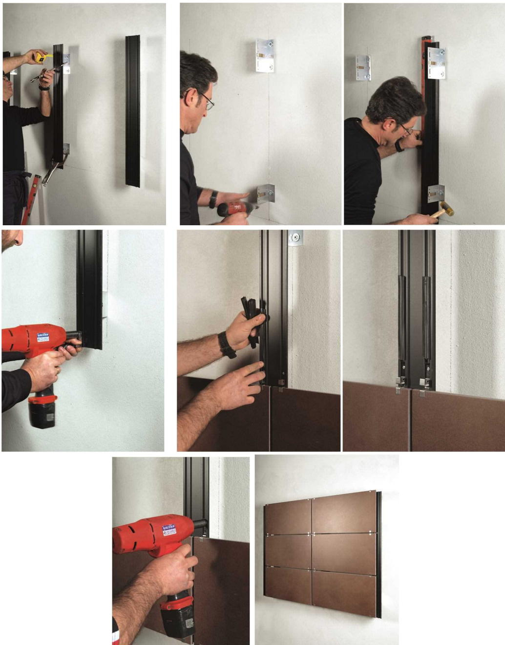
شکل ۷-۲۴- مراحل نصب سیستم نصب نمایان
