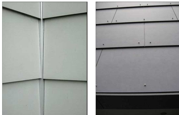
شکل ۶-۶۵- نمای ظاهری سامانه های صفحه سیمانی ساده و دارای همپوشانی از نظر محل اتصال پیچ یا پرچ
