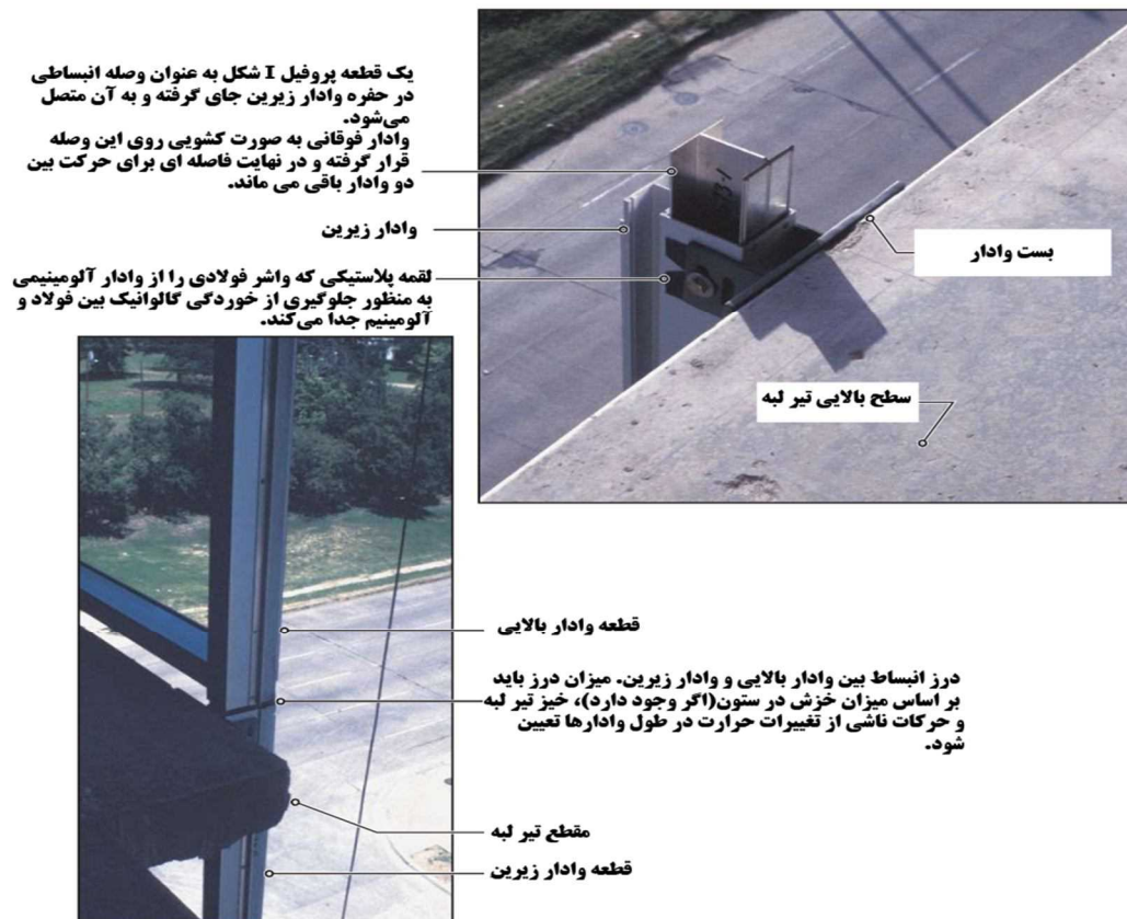
شکل ۸-۸- نمونه اتصال انبساطی بین دو قطعه وادار
