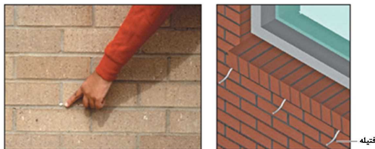
شکل ۵-۱۷- فتیله‌های از جنس کتان جهت حفره‌های زه‌کشی
