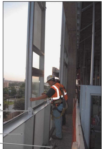
وصله ها در قطعه زیرین. این وصله ها جهت توسعه نما و نیز جابجایی کردن آنها کاربرد دارند. قطعاتی که نصب شده اند بست های بار ثقلی
