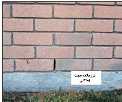
شکل ۵-۱۵- خالی گذاشتن درز ملات جهت زه‌کشی
