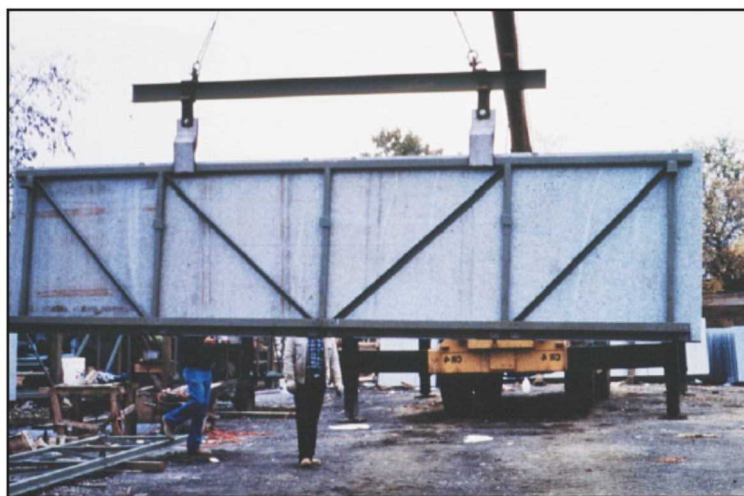
شکل ۴-۲۵- پانل دیواری پرده‌ای پیش‌ساخته سنگی
