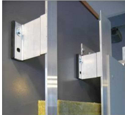
شکل ۶-۴۵- نمونه‌های زیرقاب ساخته‌شده با قطعات آلومینیومی
