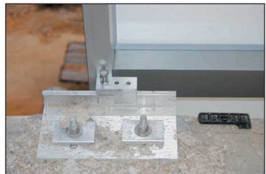
مهر یکی از قطعات نما به سازه بوسیله بست های بار ثقلی
