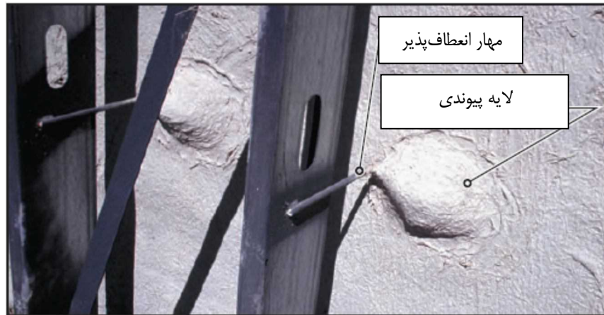
شکل ۶-۳۸ - لایه پیوندی و مهارهای انعطاف‌پذیر
