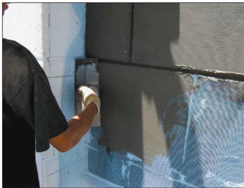
شکل ۶-۱۸- اجرای لایه‌های پوششی
