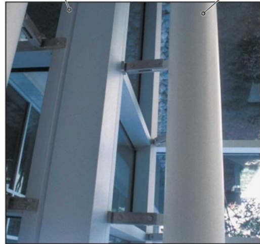
شکل ۸-۱۵- دیوار پرده‌ای بلند، جهت تامین مقاومت جانبی به قاب فولادی سازه متصل شده است
