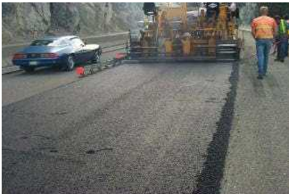
شکل ۳- ۱۳- لکه نواری ایجاد شده ناشی از وجود جعبه دنده تعبیه شده در وسط تیغه ماریپچ فینیش
