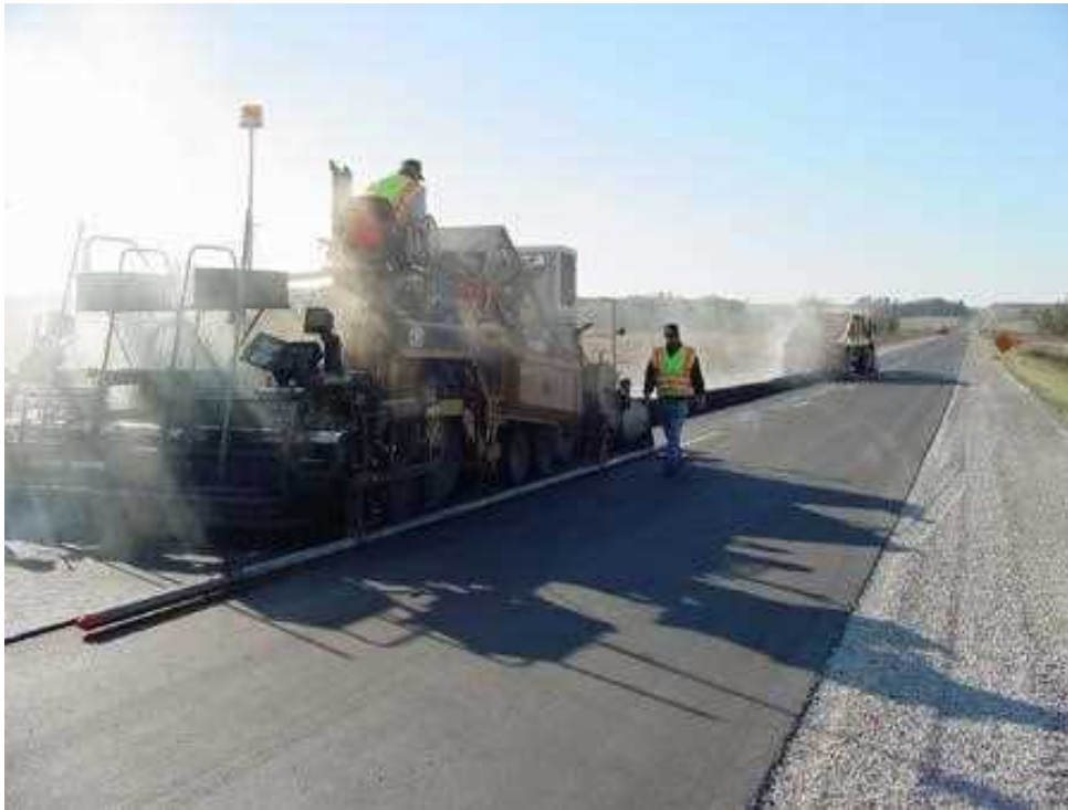
شکل ۳- ۱۹- پخش مخلوط آسفالت با فینیشر و ترازبندی سطح
