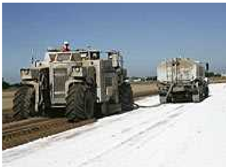
شکل ۳-۲۰- نمونه‌ای از عملیات تراکم و تثبیت لایه‌های زیرسازی با استفاده از آهک
