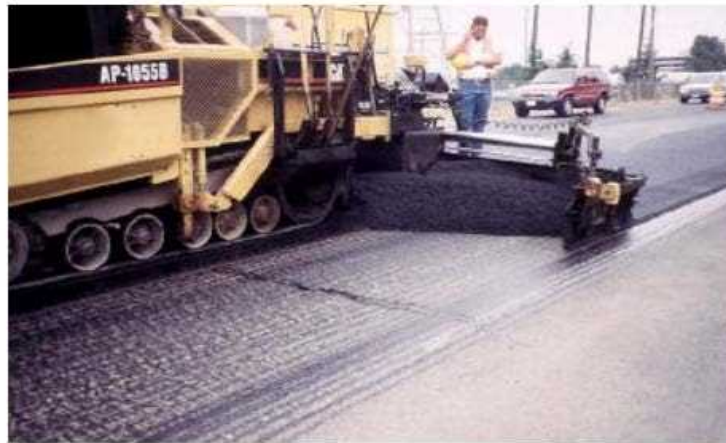
شکل ۳- ۱۶- نماهایی از قطعه افزاینده طول شمشه دستگاه فینیشر (قطعه تعریض)
