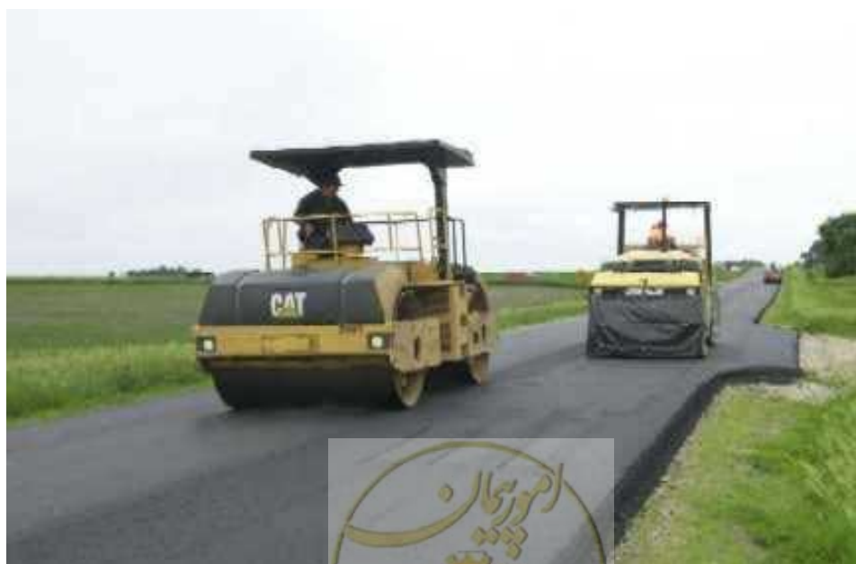
شکل ۳-۲۱- عملکرد ابتدایی غلتک زنی
