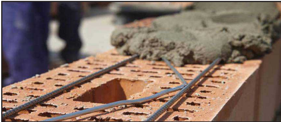
شکل 3-1- میلگرد بستر خرپایی قبل از پخش کردن ملات بستر بر روی آن
