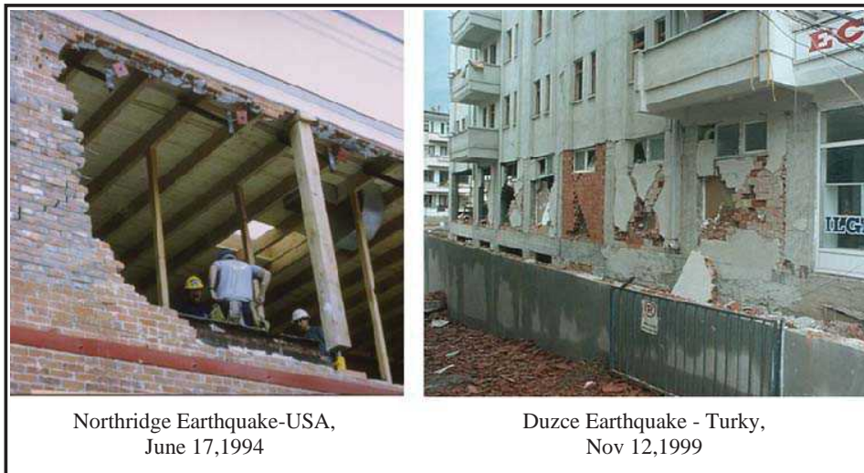
شکل 1-5- تخریب خارج از صفحه میانقاب‌های بنایی غیرمسلح در زلزله‌های نورتریج و دووز
