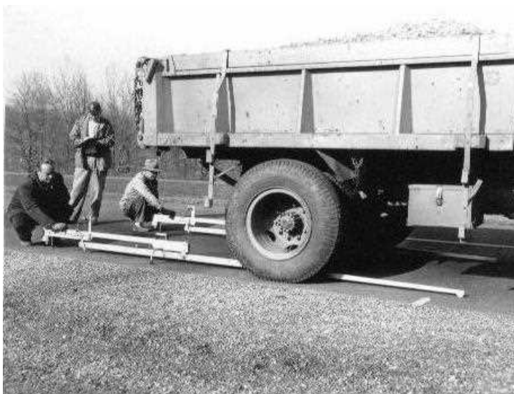
شکل ۲- تیر بنکلمن در آزمایش بزرگ آشتو
