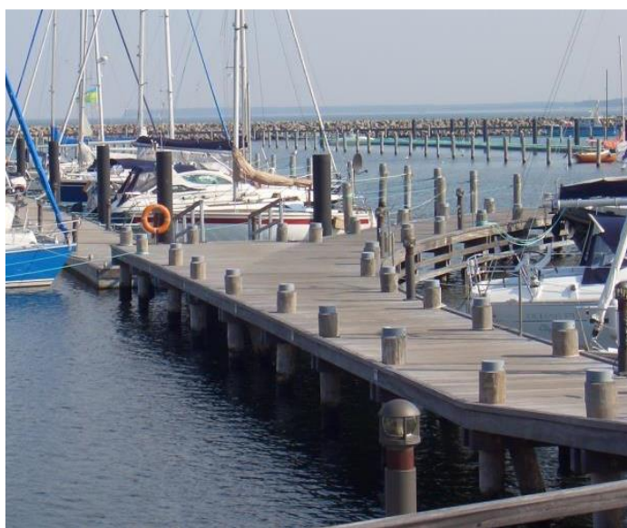
شکل ۳-۱۸- اسکله شمع و عرشه
