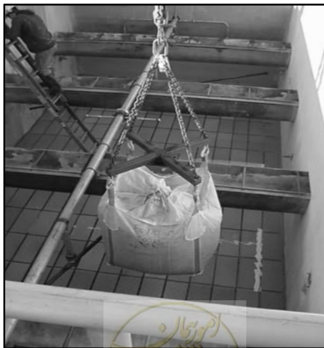
شکل ۵-۲- نحوه بلند کردن مصالح موجود در کیسه بزرگ
