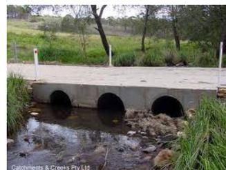
کالورت بسته: این سازه یک کف مصنوعی دارد و همچنین اثر بیش‌تری روی بستر و کناره رودخانه وارد می‌کند.
