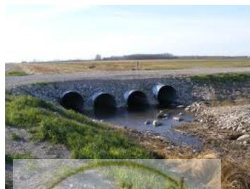
آبگذر جاده: انتقال آب رودخانه توسط لوله و بالای تراز بستر صورت گرفته و بستر رودخانه تحت تاثیر قرار می‌گیرد.
