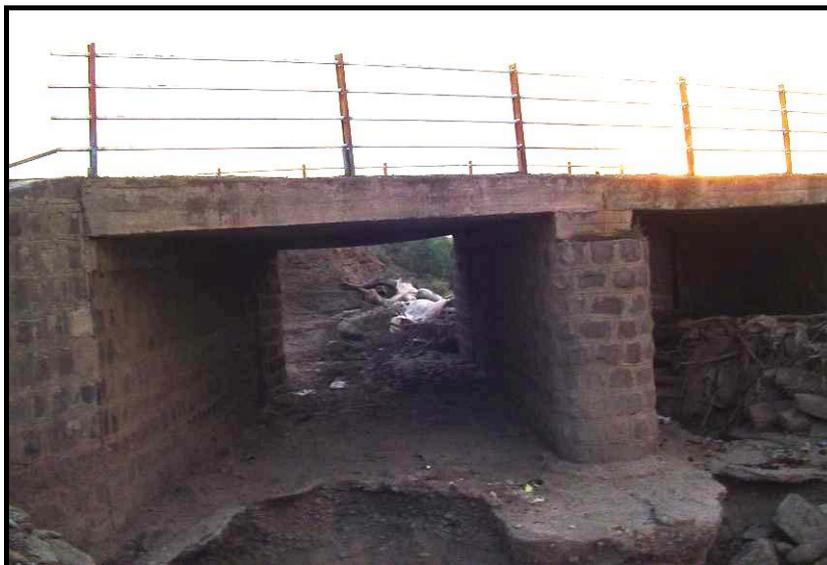
شکل ۷-۱۹- آبخستگی شدید در بستر و تخریب پی در محل پایه‌ها در مسیل فروان
