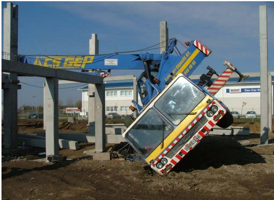
شکل ۳-۵- نمونه‌ای از سقوط یک جرثقیل متحرک
