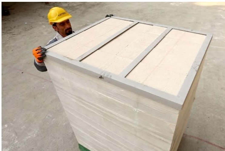
شکل ۱-۱۰- حمل پالت‌های انتقال بلوک‌های AAC
