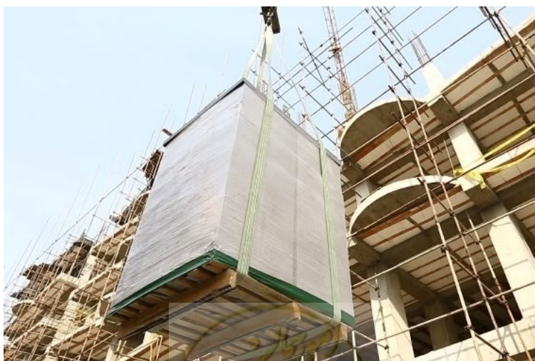
شکل ۱-۱۱- انتقال پالت‌های بلوک‌های AAC در کارگاه
