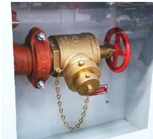
شکل ۹-۱۱- تبدیل \frac{1}{2} به \frac{1}{4} اینچ نصب شده بر روی اتصال شلنگ
