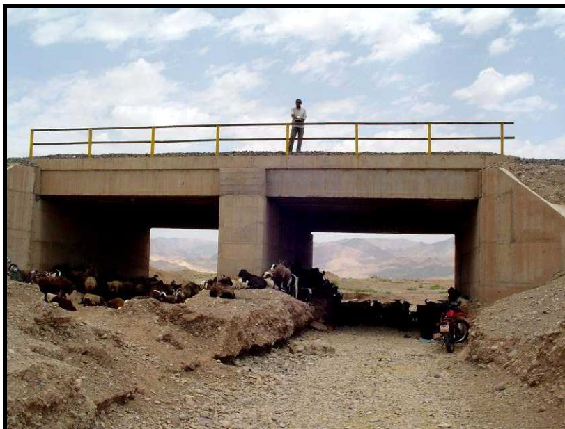
شکل ۷-۱۸- پایین افتادگی بستر و تنگ شدگی در مقطع رودخانه در مسیل کردوان
