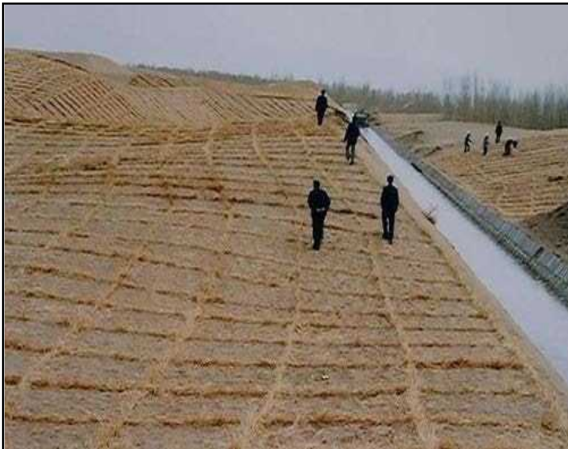
عکس ۲-۶- تثبیت تپه‌ها و پهنه‌های ماسه‌ای با استفاده از ساقه‌های گندم
