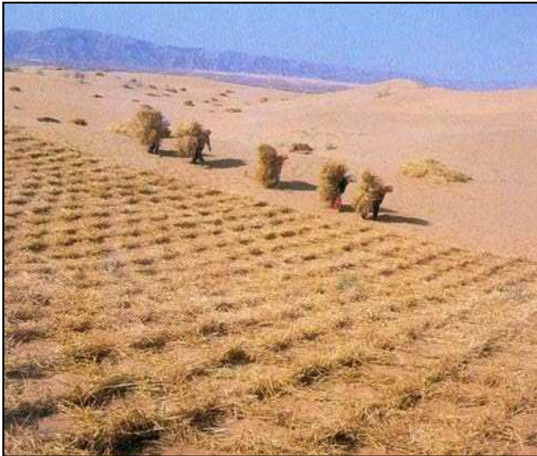
عکس ۶-۳- تثبیت تپه‌ها و پهنه‌های ماسه‌ای با استفاده از ساقه‌های برنج
