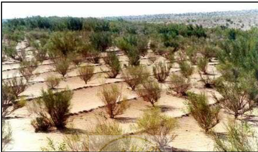
عکس ۳-۵- عملیات توام موانع رسی و کاشت گیاه برای تثبیت شن
