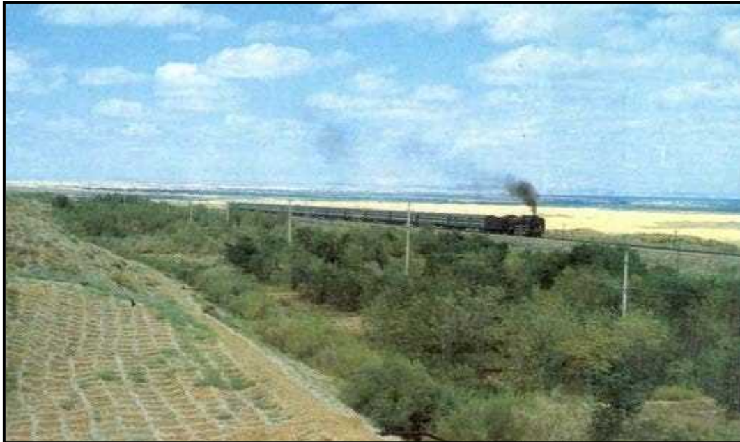
عکس ۱-۵- نمایی از احداث بادشکن‌های زنده و غیرزنده در اطراف ریل راه‌آهن در کشور چین
