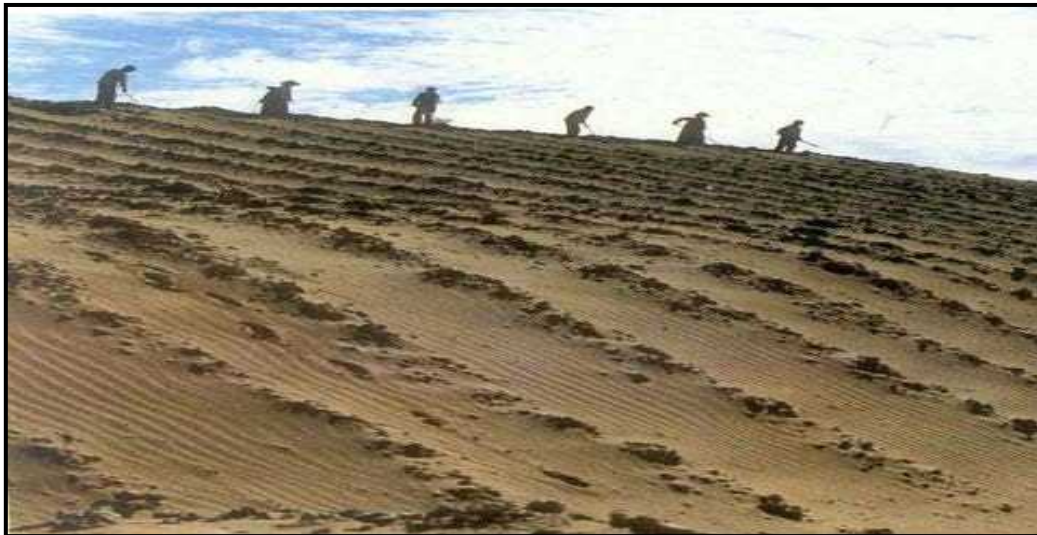
عکس ۶-۱- عملیات احداث موانع خاک رس برای تثبیت ماسه‌های روان
