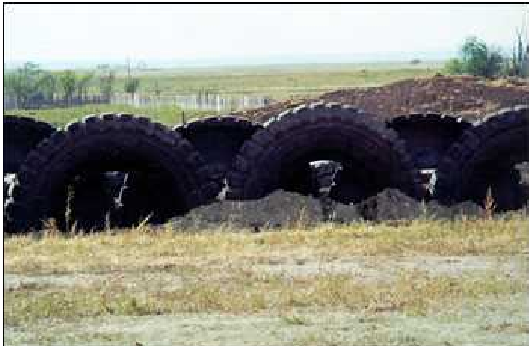
عکس ۴-۱- استفاده از لاستیک‌های مستعمل خودرو جهت احداث بادشکن غیرزنده
