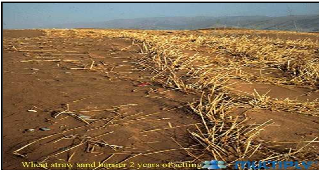
عکس ۲-۵- نمایی از موانع ساقه گندم (Straw barrier) برای تثبیت تپه‌های ماسه‌ای در منطقه مین چین
