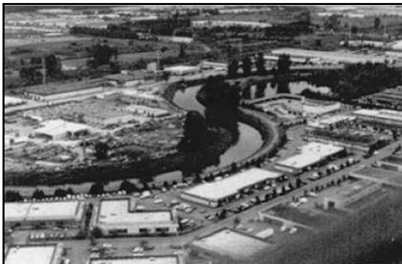
شکل ۶-۶- احداث گوره در طرفین کانال رودخانه با حفظ شکل پیچانرودی آن [۱۷۲]
