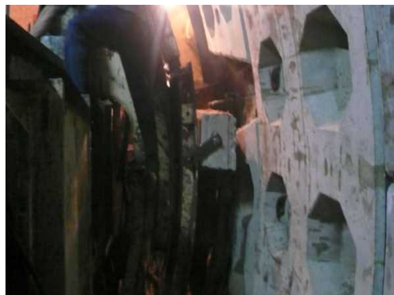
شکل ۱۲-۲۹- و- نصب سگمنت کلید بوسیله ارکتور
