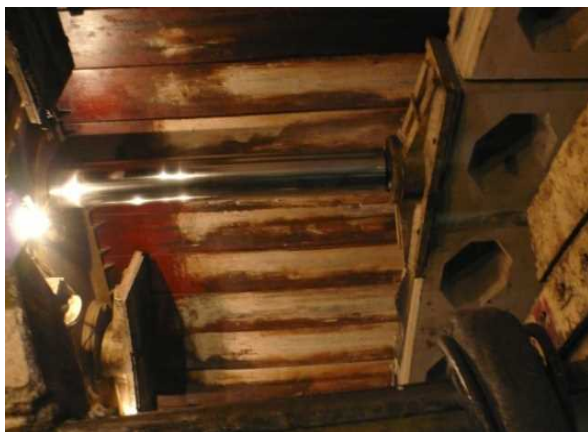
شکل ۱۲-۲۹-ب- جمع شدن جکها پس از پیشروی به اندازه عرض کامل یک رینگ
