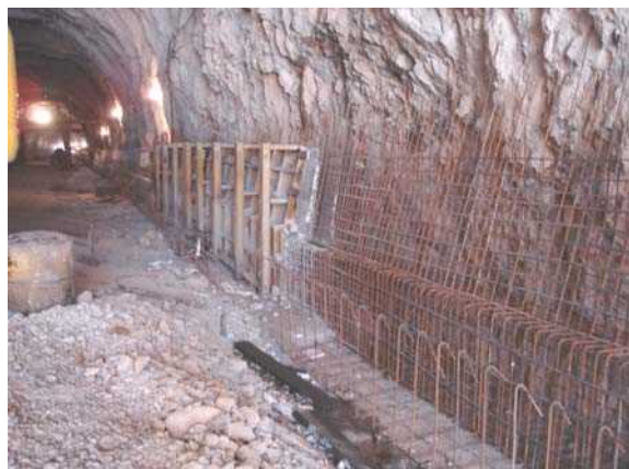
د- آرماتوربندی و قالببندی دیواره
