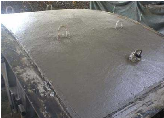
شکل ۱۲-۱۶- پرداخت سطوح بتنی
