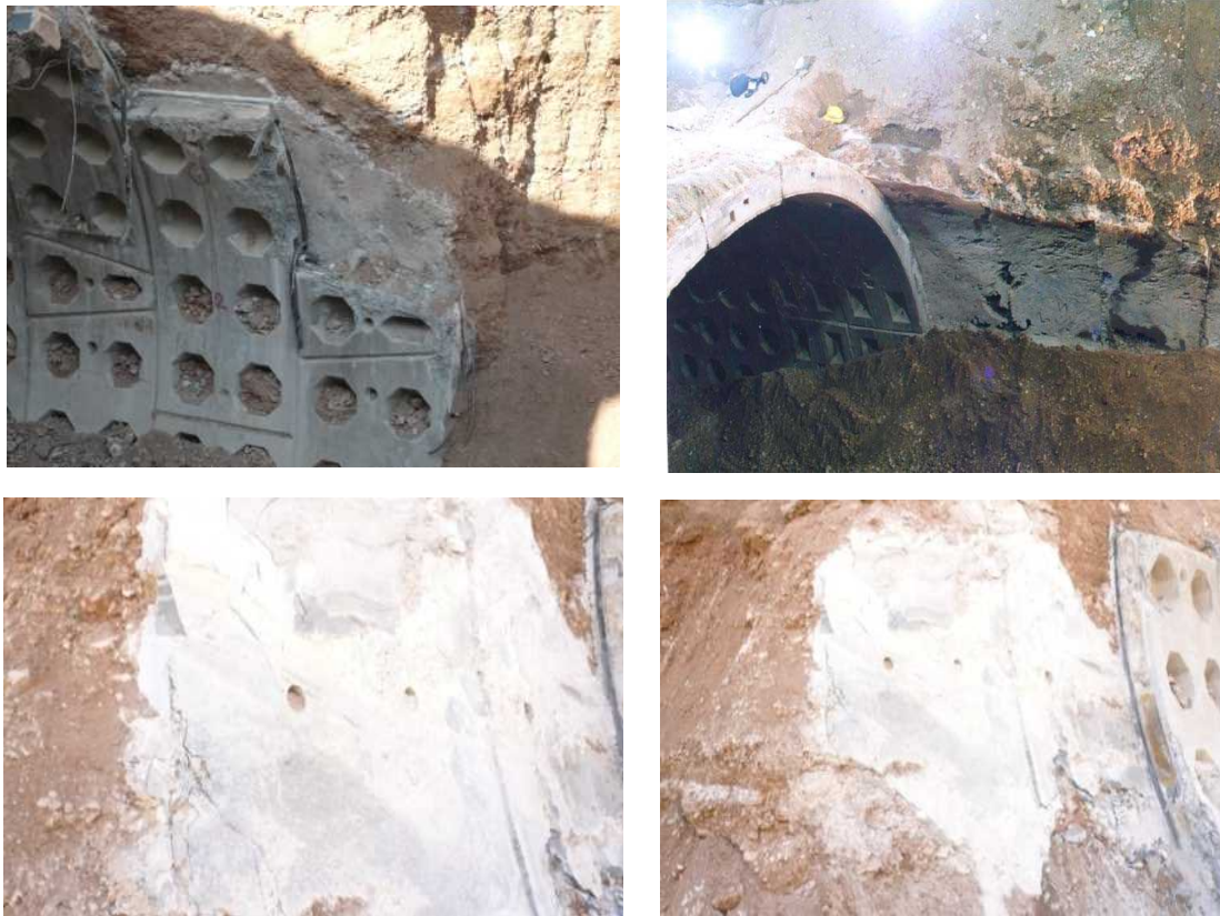
شکل ۱۲-۳۳- نتایج تزریق پشت پوشش داخلی سگمنتی
