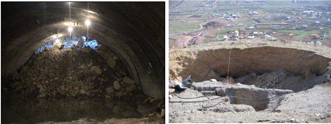
شکل ۳-۳۱- نمایشی از فروکش مواد به داخل تونل
