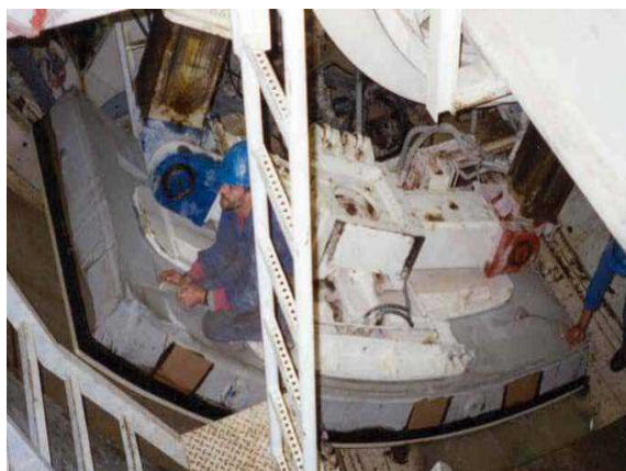
شکل ۱۲-۲۷- تحویل سگمنت در ناحیه کف تونل به دستگاه نصب سگمنت (ارکتور) و نصب آن
