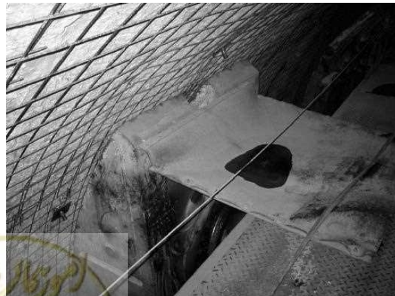
شکل ۵-۱۱- توری سیمی و نحوه نصب آن در حفاری با TBM [۱۰۴]
