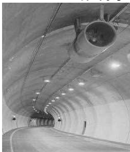
شکل ۵-۱۵-ب- نماهای داخلی از پوشش داخلی بتن برج تونل [۱۰۵]
