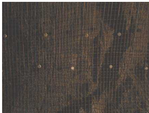
ج- شبکه آرماتوربندی سقف
