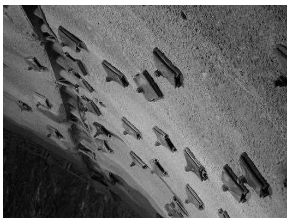
شکل ۵-۸- استفاده از راک بولت جهت تحکیم سقف و دیواره تونل [۱۰۴]
