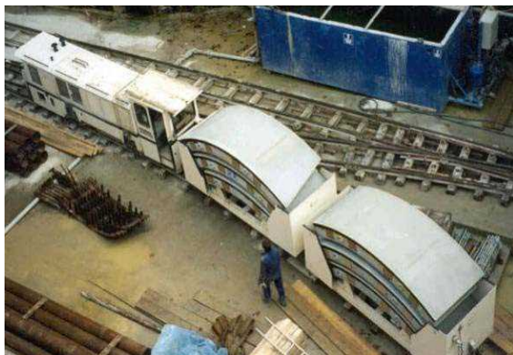
شکل ۱۲-۲۶- نمایی از نحوه انتقال سگمنت به داخل تونل [۲۲۲]
