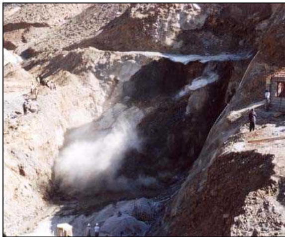
ریزش ترانشه ورودی یک تونل در اثر زمین لغزش [۴۵]
