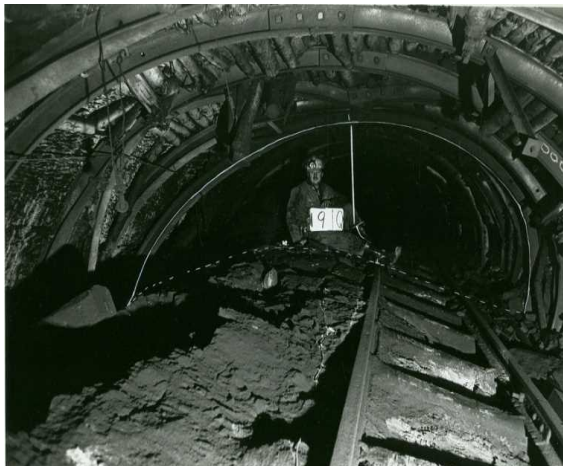
شکل ۳-۲۷- تاثیر زمین آماس پذیر بر روی پایداری تونل [۱۰]
