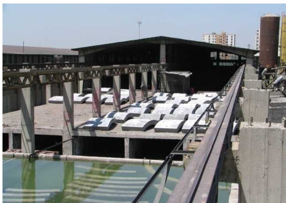
دپوی قطعات برای ورود به استخر با استفاده از جرثقیل‌های سقفی
