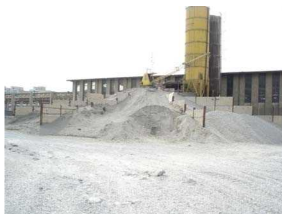
شکل ۱۱-۱- نحوه دپو سیمان و سنگدانه‌های بتن
