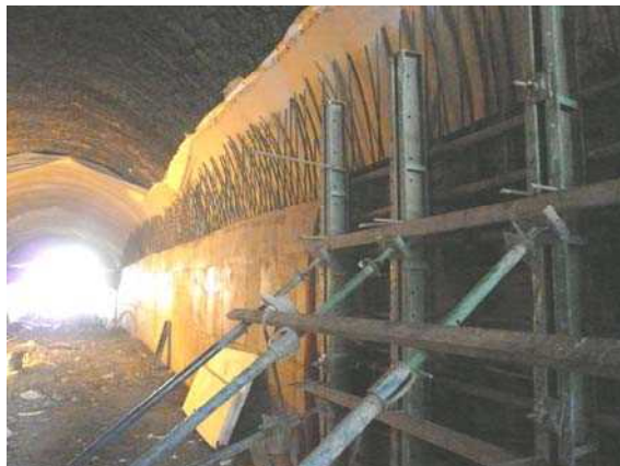
محدوده بتن ریزی شده در کنار محدوده قالب بندی شده
