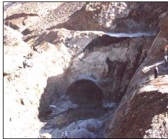
ریزش ترانشه ورودی یک تونل در اثر زمین لغزش [۴۵]
