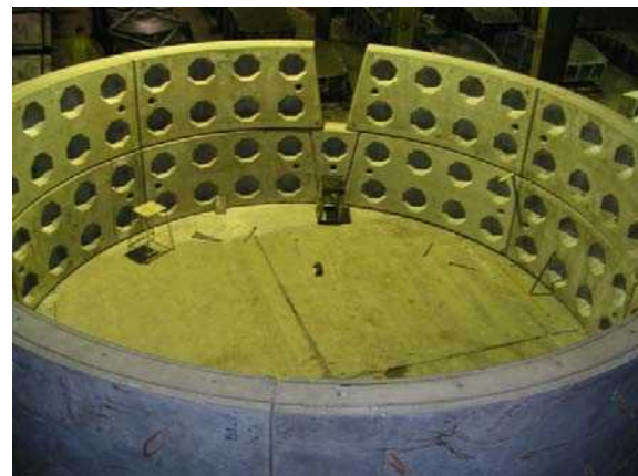
نصب دو رینگ کامل بر روی شابلون
