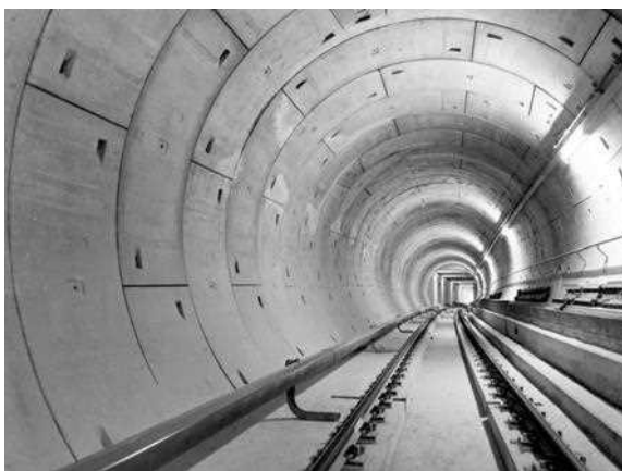
شکل ۱۲-۴- دو نما از پوشش داخلی تونل با سگمنت مستطیلی شکل
