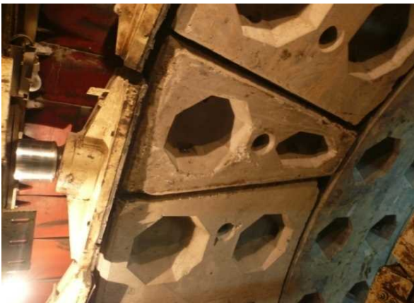
شکل ۱۲-۲۹- ی- جازدن سگمنت کلید با استفاده از نیروی فشاری جکها
