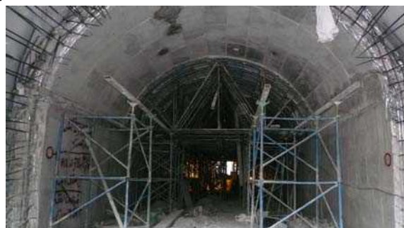
نمای عمومی قالب بندی سنتی سقف تونل
