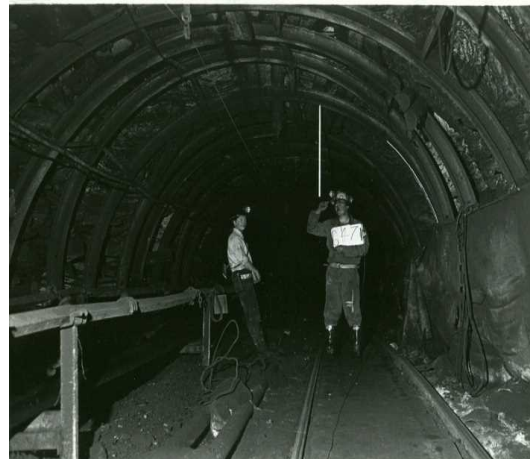
شکل ۳-۲۷- تاثیر زمین آماس پذیر بر روی پایداری تونل [۱۰]
