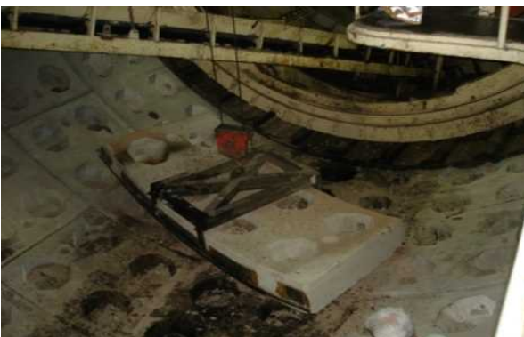
شکل ۱۲-۲۹-ج- تحویل قطعات سگمنت به دستگاه نصب سگمنت (ارکتور)
