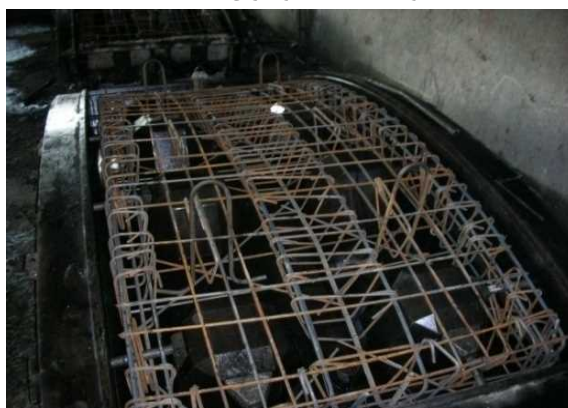
قالب و قفسه آرماتوربندی آماده شده برای بتن ریزی
