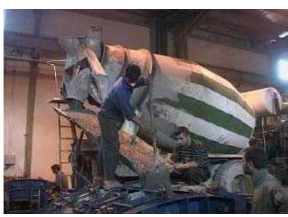
بتن ریزی داخل قالب بوسیله تراک میکسر
