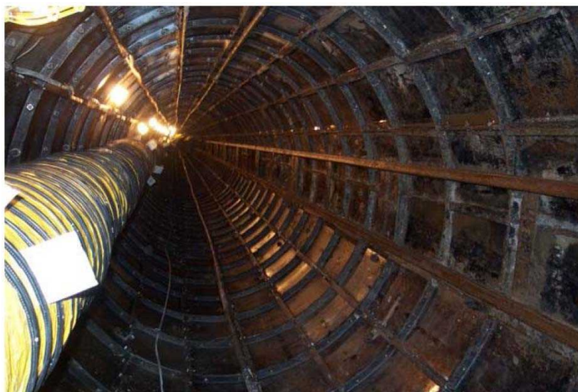
شکل ۵-۱۹- استفاده از صفحات فلزی در پوشش نگهداری تونل متروی بالتیمور [۱۰۵]
