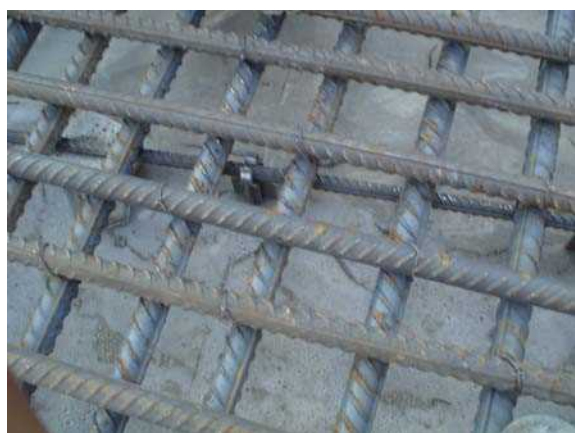
شکل ۱۳-۵- آرماتوربندی کف تونل
