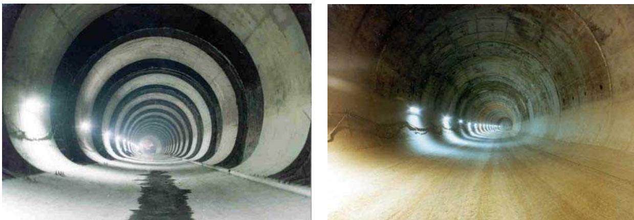
شکل ۲-۴-الف - دو نما از تونل با مقطع نعل اسبی
