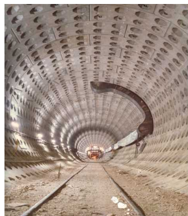
شکل ۱۲-۴- دو نما از پوشش داخلی تونل با سگمنت مستطیلی شکل
