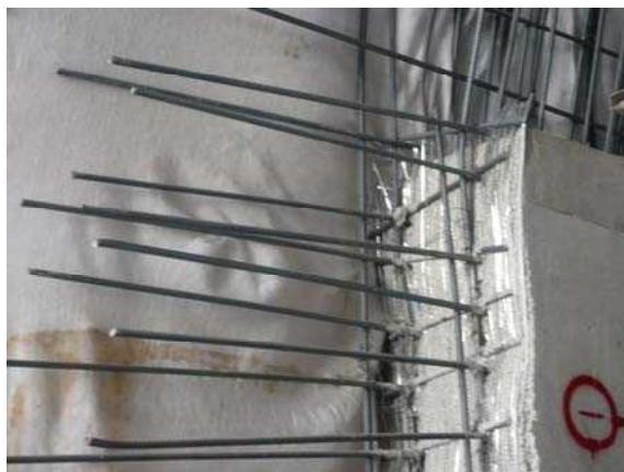
شکل ۱۳-۶- آرماتوربندی دیواره تونل
