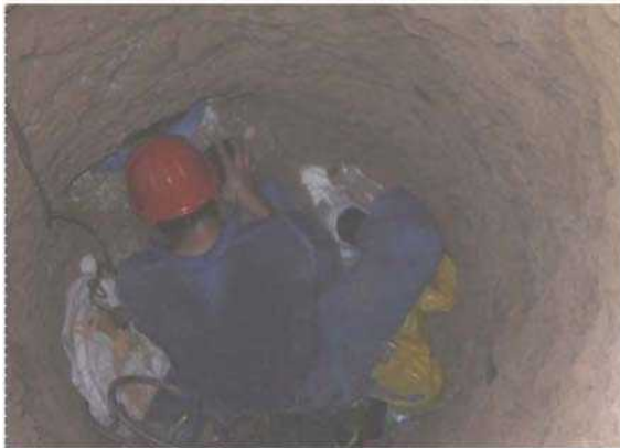
نصب تجهیزات آزمایش بارگذاری صفحه‌ای در داخل چاه اکتشافی
