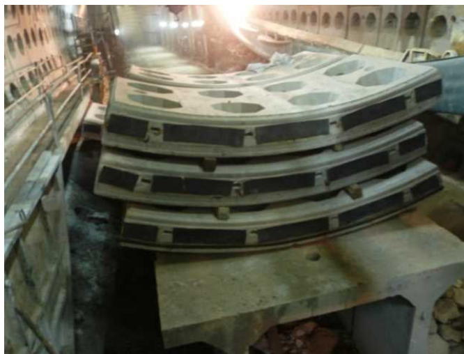
شکل ۱۲-۲۴- نمایی از نصب ضربه گیر بر روی سگمنتها
