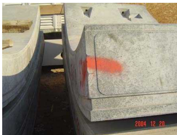
شیار تعبیه شده بر روی سگمنت به منظور نصب نوارهای آبی‌بند
