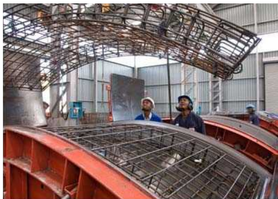
نحوه جاگذاری شبکه آرماتوربندی داخل قالبها
