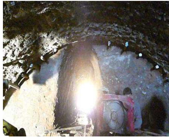
شکل ۵-۶- دو نما از نحوه اجرای فورپلینگ در تونلها
