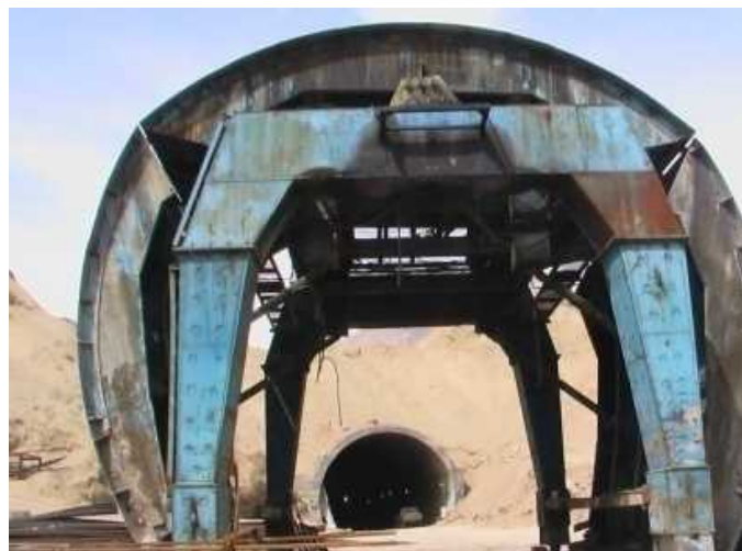
قالب غیر تلسکوپی قوسی به قطر ۱۰ متر
