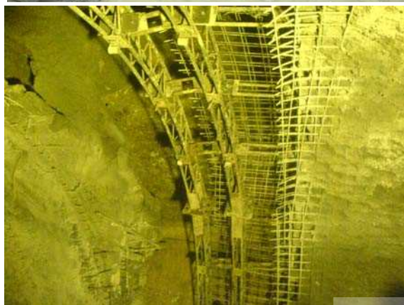
شکل ۵-۱۳- تیرهای مشبک و نصب آنها
