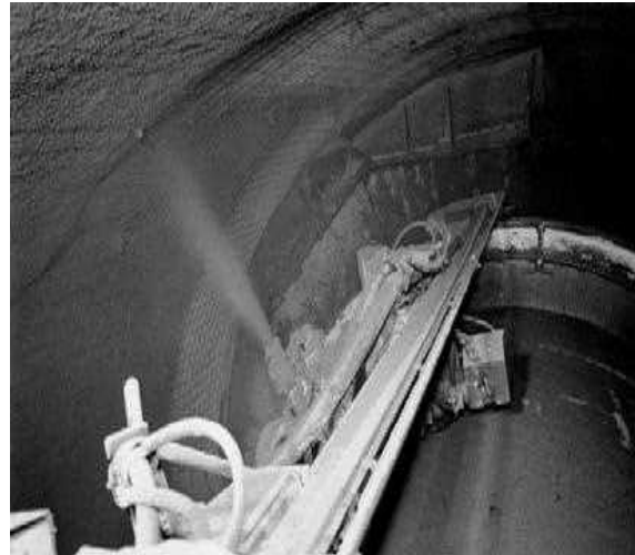
شکل ۵-۱۰- اشکال مختلف نحوه اجرای شاتکریت [۱۰۴]
