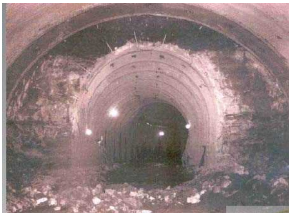
شکل ۳-۲۸- (الف) و (ب) دو نمونه تاثیر زمین آماس پذیر بر روی حفاری تونل [۱۱]
