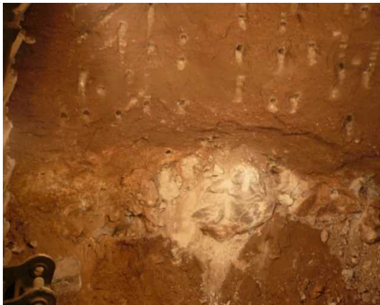
لایه سنگ در ارتفاع سه متری از مقطع تونل (کاهش ارتفاع لایه سنگی) در کیلومتر حدود ۱۷+۷۷۰ (بر اساس شکل ۴-۶۰)
