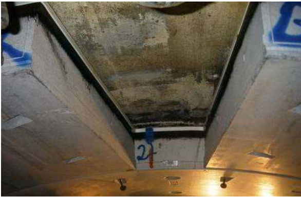
شکل ۱۲-۲۹- ه- فضای خالی برای نصب سگمنت کلید
