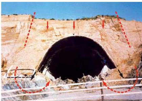
شکل ۱۰-۵- فرآیند تشکیل طاق در تونل [۲۱۲]
