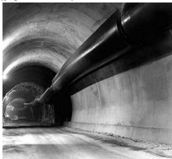
شکل ۵-۱۵-ب- نماهای داخلی از پوشش داخلی بتن برج تونل [۱۰۵]
