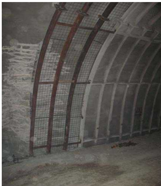
شکل ۵-۱۲- نحوه اجرای سیستم نگهداری اولیه بصورت ترکیبی از قاب فلزی، شاتکریت و مش
