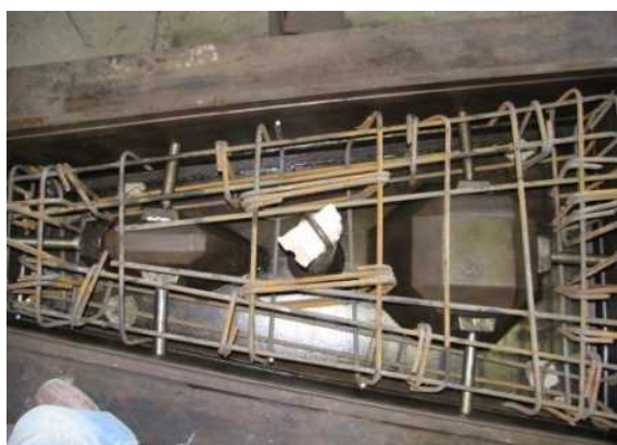
یک نمونه شبکه آرماتور برای سگمنت کلید
