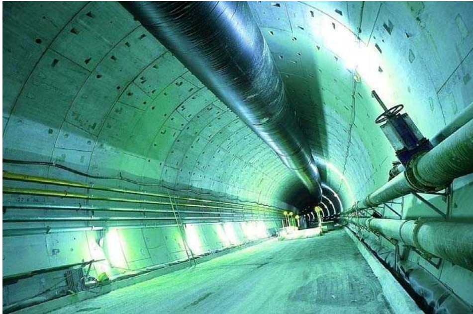
شکل ۵-۱۶- تونل با پوشش نگهداری سگمنتی [۱۰۵]
