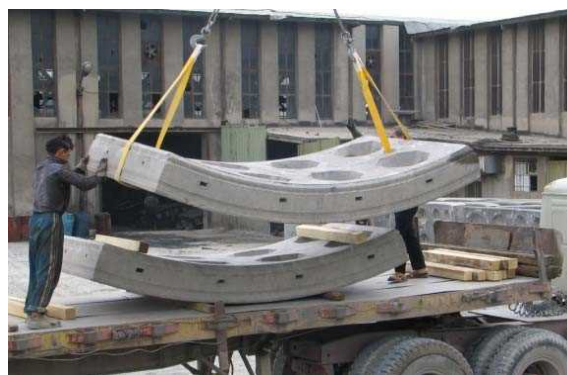
نحوه بارگیری قطعات سگمنتی بر روی کامیون کفی
