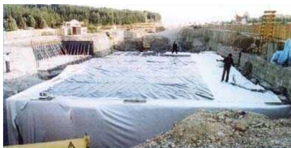
شکل ۱۳-۳- الف- اجرای ورق‌های PVC تونل متروی شیراز (روش حفاری کند و پوش)
