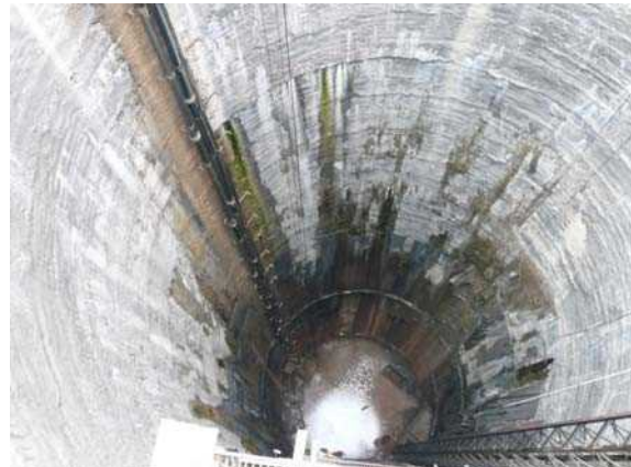
شکل ۳-۴۸ - هجوم آب به داخل شفت ورودی یک تونل بدلیل پایین بودن سطح تونل از سطح آب زیرزمینی [۲۸]
