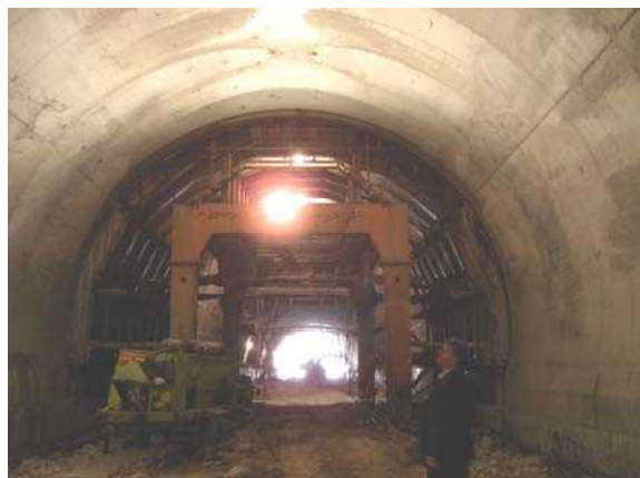
ب- قالب بندی سقف با استفاده از قالب لغزان
