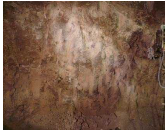
لایه سنگ در تمام مقطع سینه کار تونل در کیلومتر حدود ۱۷+۸۳۰ (بر اساس شکل ۴-۶۰)
