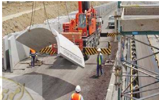
شکل ۱۲-۴۳- نماهای مختلفی از نصب قطعات بتنی پیش ساخته در تونلهائیکه به روش کند و پوش حفاری می شوند [۲۴۴]
