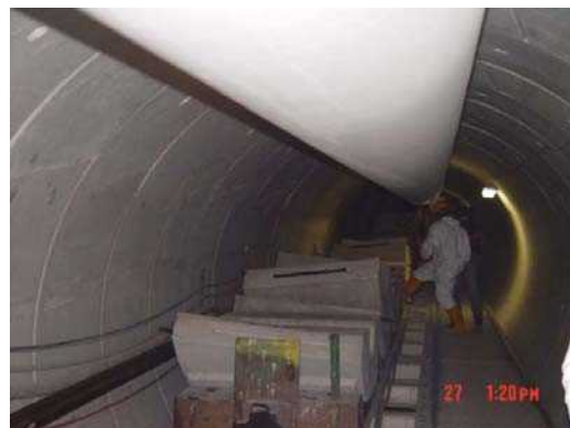
شکل ۱۲-۲۶- نمایی از نحوه انتقال سگمنت به داخل تونل [۲۲۲]
