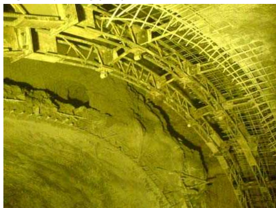
شکل ۵-۱۲- نحوه اجرای سیستم نگهداری اولیه بصورت ترکیبی از قاب فلزی، شاتکریت و مش
