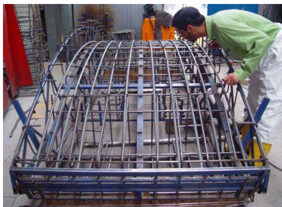
ساخت شبکه آرماتور بر روی شابلون
