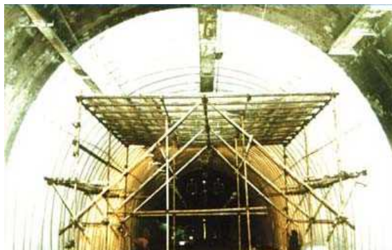
شکل ۱۳-۱- عایق رطوبتی تونل کندوان
