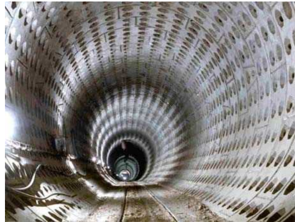
شکل ۲-۱-الف- تونل با مقطع دایره قبل از کف سازی
