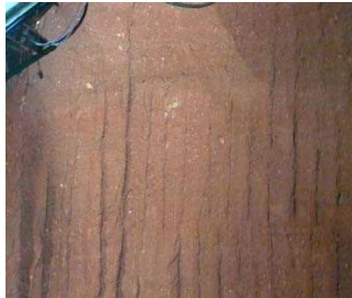
مقطع سینه کار تونل قبل از برخورد به لایه سنگی
