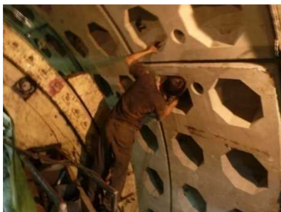
نصب بولتها پس از نصب هر قطعه سگمنت
