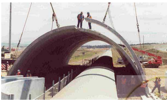
شکل ۱۲-۴۳- نماهای مختلفی از نصب قطعات بتنی پیش ساخته در تونلهائیکه به روش کند و پوش حفاری می شوند [۲۴۴]
