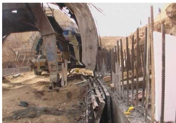
شکل ۱۳-۱۲- قالببندی و بتن ریزی جدولها
