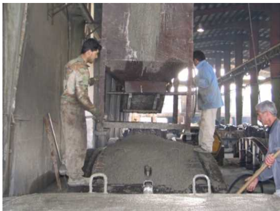
بتن ریزی داخل قالب با استفاده از باگت
