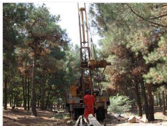
الف- حفاری گمانه ماشینی
