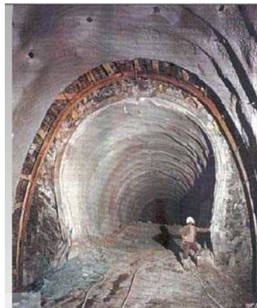
شکل ۳-۲۸- (الف) و (ب) دو نمونه تاثیر زمین آماس پذیر بر روی حفاری تونل [۱۱]
