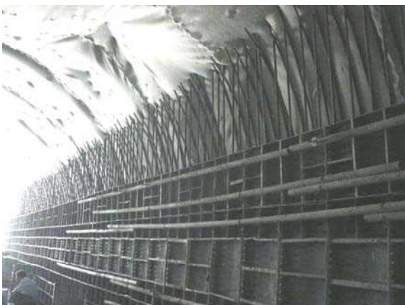
شکل ۱۳-۶- آرماتوربندی دیواره تونل
