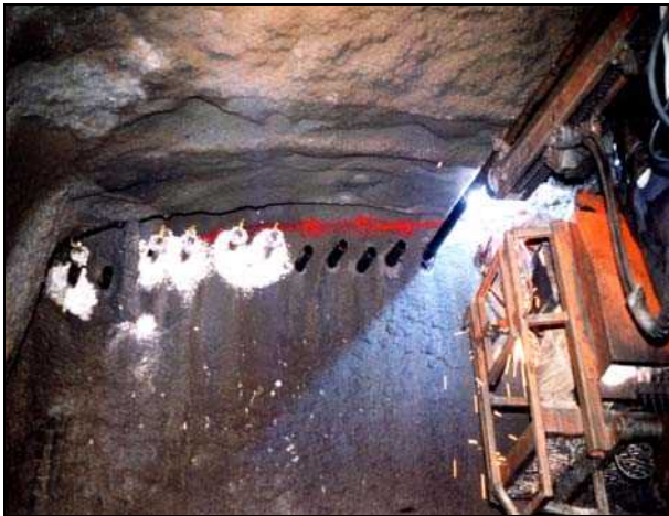
شکل ۵-۶- دو نما از نحوه اجرای فورپلینگ در تونلها
