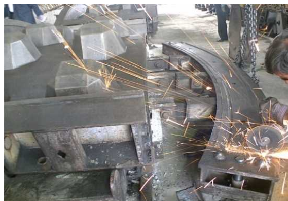
ساخت قالب برای قطعات سگمندی
