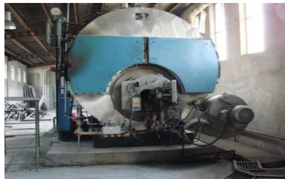
شکل ۱۲-۱۷- سیستم تولید بخار (بوiler)
