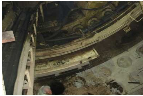
شکل ۱۲-۲۹- ج- نصب قطعات سگمنت بوسیله دستگاه نصب سگمنت (ارکتور) TBM
