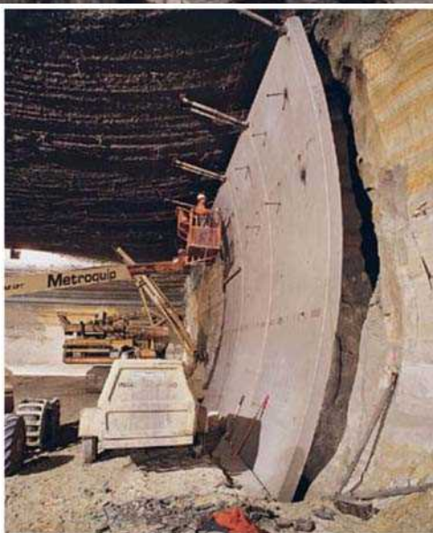
شکل ۱۲-۴۴- نمونه اصلاح شده بیل کاتر پیلار ۳۲۵ جهت نصب قطعات بتنی پیش ساخته (سگمنت) در داخل تونل [۲۴۴]
