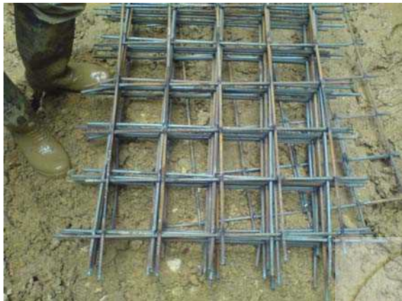
شکل ۵-۱۱- توری سیمی و نحوه نصب آن در حفاری با TBM [۱۰۴]
