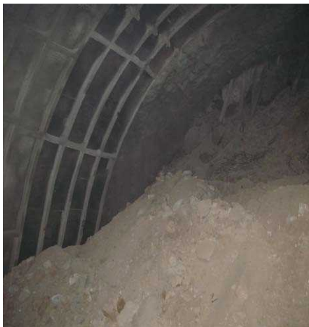
شکل ۵-۱۲- نحوه اجرای سیستم نگهداری اولیه بصورت ترکیبی از قاب فلزی، شاتکریت و مش
