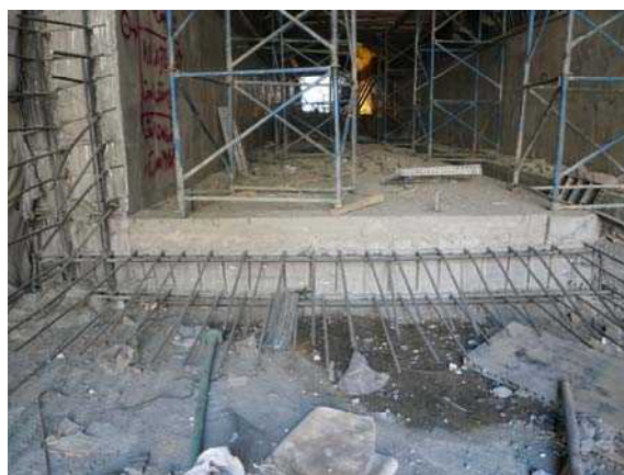
شکل ۱۳-۵- آرماتوربندی کف تونل
