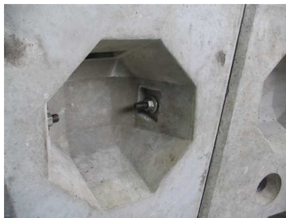
اتصال سگمنتها با استفاده از بولت مستقیم
