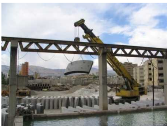
بیرون آوردن قطعات از استخر
