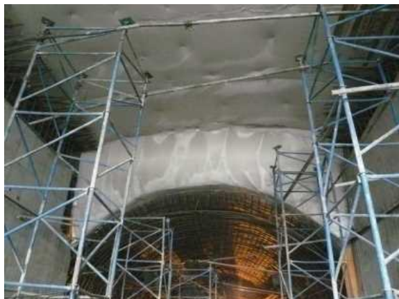
شکل ۱۳-۳- ب- اجرای عایق بندی دیواره‌ها و سقف
