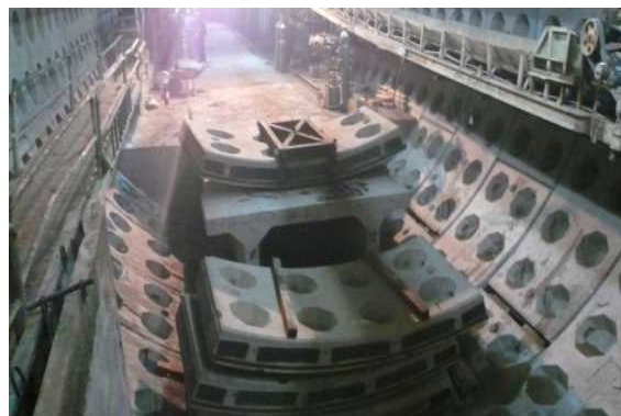
شکل ۱۲-۲۹-پ- انتقال سگمنتها به پشت دستگاه حفار TBM
