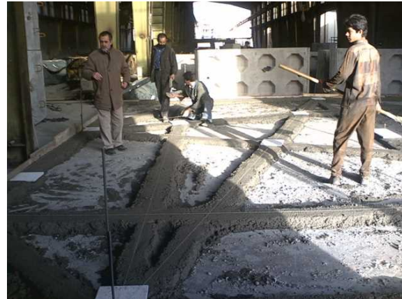
ایجاد شابلون رینگ به وسیله نقشه برداری بر روی زمین
