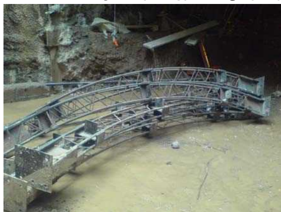
شکل ۵-۱۲- نحوه اجرای سیستم نگهداری اولیه بصورت ترکیبی از قاب فلزی، شاتکریت و مش
