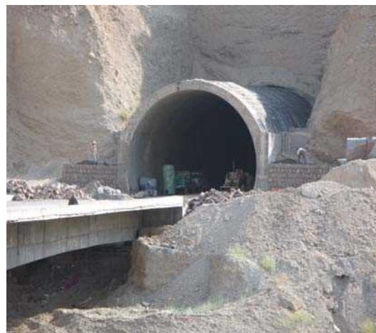
شکل ۵-۱۵-الف- نماهای بیرونی از پوشش داخلی بتن برج تونل [۱۰۵]
