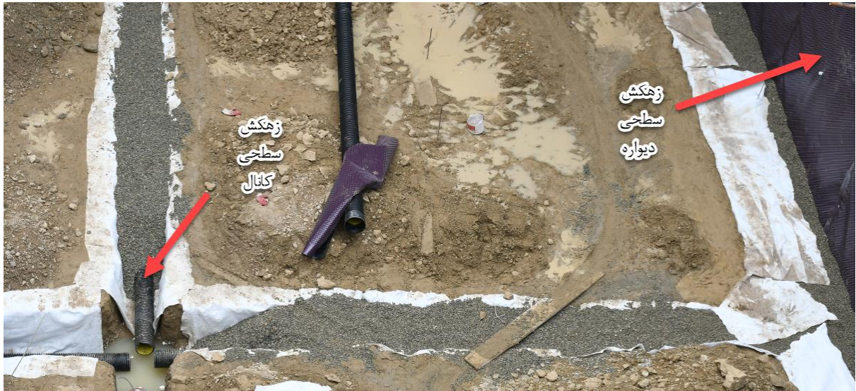
شکل ۱-۱۳- نمای از زهکش سطحی دیواره و کانال
