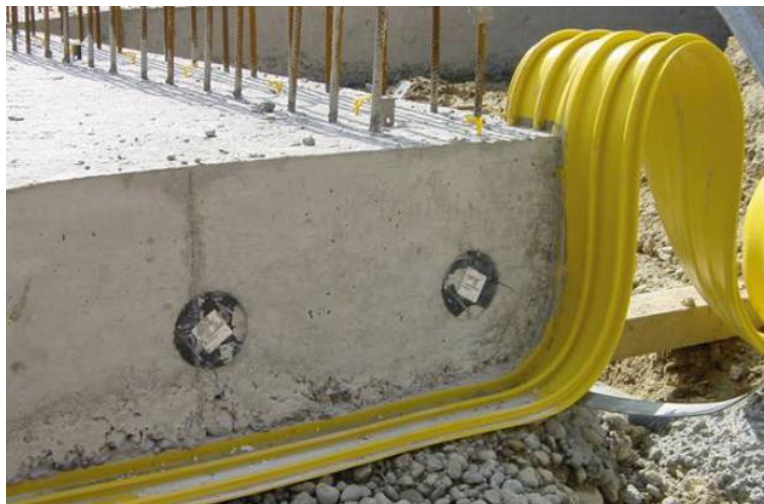
شکل ۳-۲۸- آب‌بندی درز به وسیله واتراستاپ خارجی
