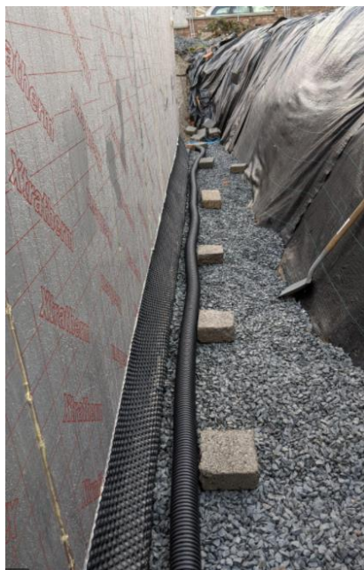
شکل ۱-۱۵-۱- نمایی از زهکش سنتی - شن‌ریزی پشت دیوار
