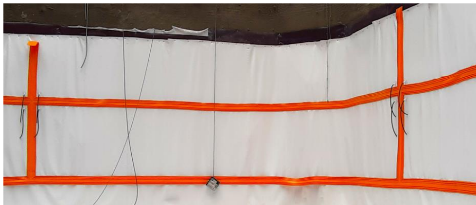
شکل ۳-۱۵- نمای از واتراستاپ پروفیلی جوش شده به ژئوممبران PVC
