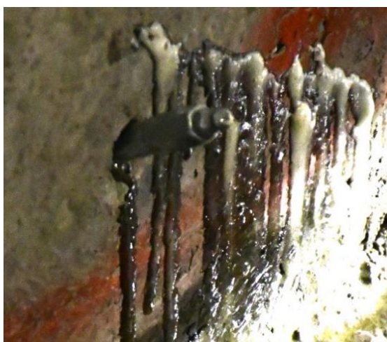
شکل ۶-۱- نمایی از تزریق فوم پلی یورتان در ترک دیواره جهت آب‌بندی
