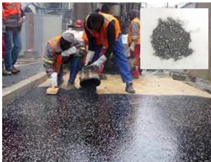
ب) نمونه اجرایی آسفالت ماستیک ریزدانه
