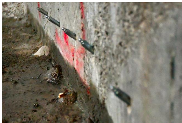
شکل ۳-۶- نمایشی از پکر گذاری و تزریق در درز اجرایی کف و دیواره
