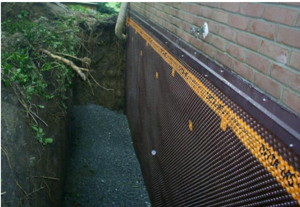
شکل ۱-۱۷- نمای از سیستم زهکشی خارجی
