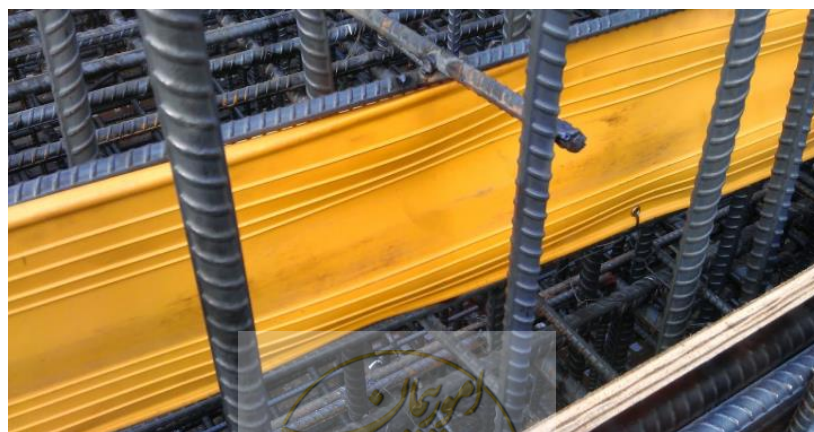
شکل ۳-۱۶- نمای از واتراستاپ پروفیلی میان درز
