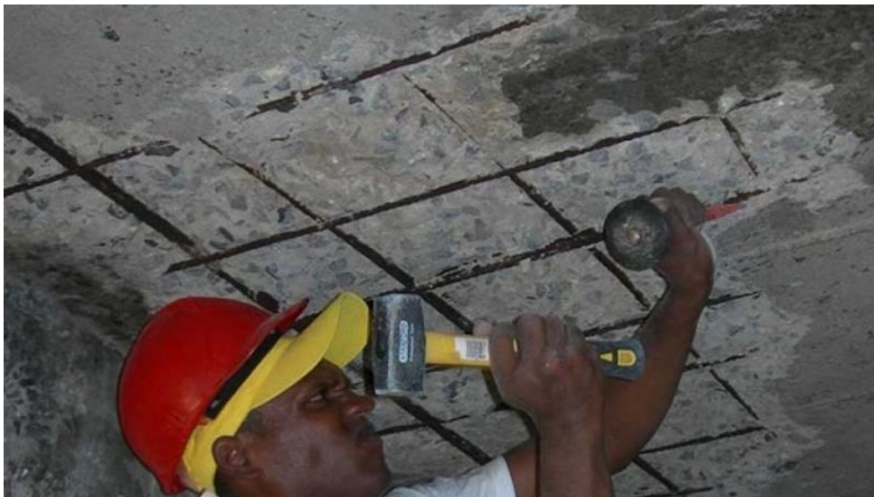
شکل ۶-۲- نمایی از ترمیم محدوده شن زده جهت اجرای عملیات تزریق
