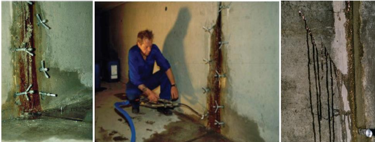
شکل ۶-۹- عملیات تزریق در درزهایی با نشب آب
