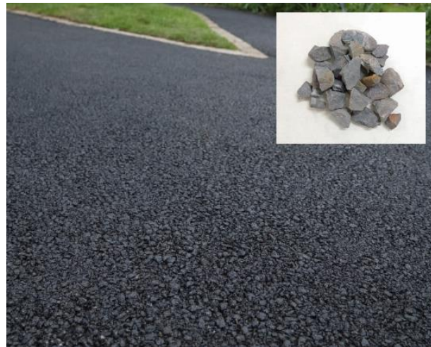
ب) نمونه اجرایی آسفالت ماستیک درشت دانه
