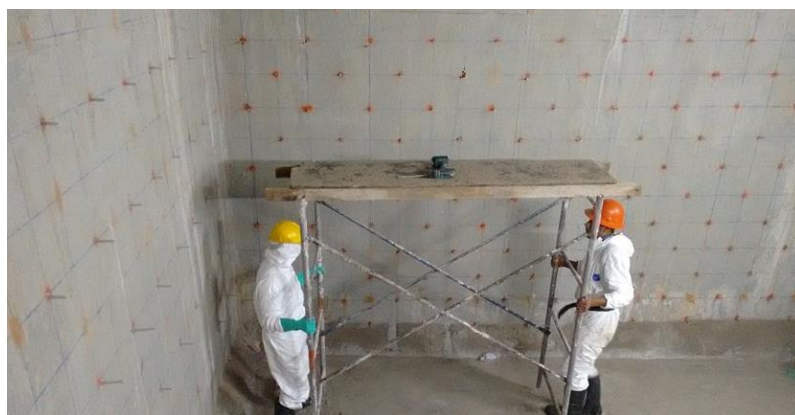
شکل ۴-۶- نمایشی از پکر گذاری با چیدمان مربعی جهت تزریق پرده آببند در پشت دیواره
