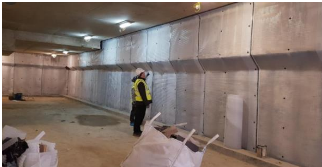
شکل ۱-۱۶- نمای از سیستم زهکشی داخلی
