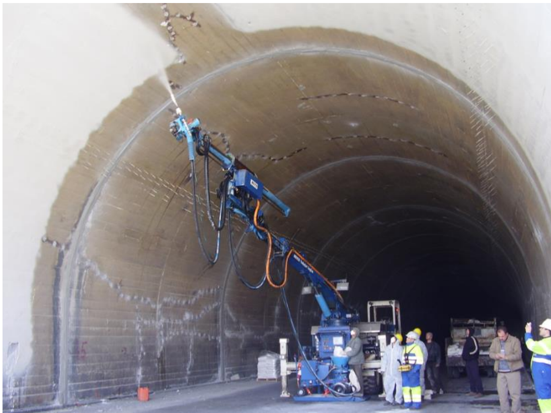
شکل ۱-۹- استفاده از آب‌بند بر پایه سیمان و مواد بلوری شونده در سازه زیرزمینی
