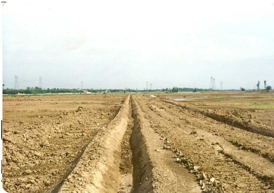
شکل شماره ۷- اراضی تسطیح شده و کانال های انتقال آب و جاده های بین مزارع
