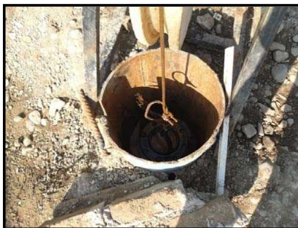
شکل پ. ۱-۱۴- عملیات اسیدشویی چاه
