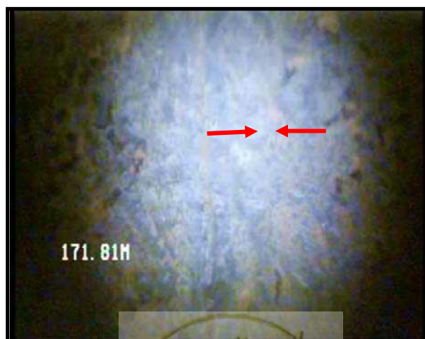
شکل پ.۱-۴- تصویر عملیات ویدئومتری سطح استاتیک ۱۷۱/۸۱ متر
