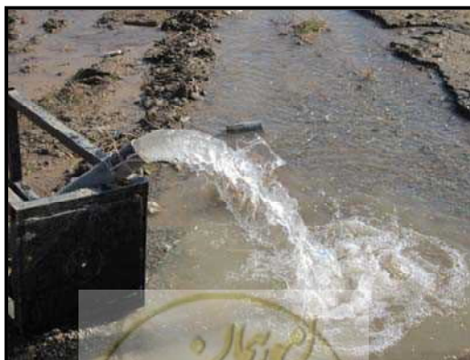
شکل پ.۱-۱۶- مراحل صاف شدن در هنگام پمپاژ موضعی همراه با استفاده از سیستم اولتراسوند
