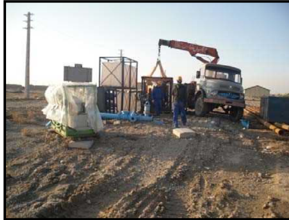
شکل پ.۱-۵- عملیات پاکسازی و فعال‌سازی چاه
