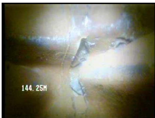
شکل پ.۱-۱۰- تصویر حاصل از ویدئومتری در عمق ۱۴۴/۲۵ متری
