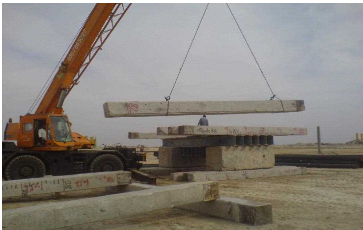
شکل الف-۶- جابجایی شمع از محل قلاب‌های تعبیه شده که کمترین لنگر ماکزیمم را ایجاد می‌نماید.
