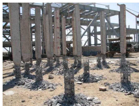
شکل الف-۱۱- بریدن راس شمع‌های بتنی با کمک تخریب (سمت راست) و توسط اره‌های مخصوص (سمت چپ)
