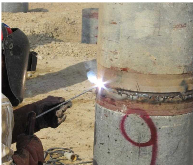
شکل الف-۷- تطویل شمع با اتصال جوشی
