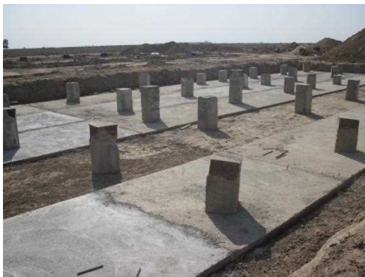
شکل الف-۱۰- دوران غیر مجاز برخی از شمع‌ها حول محور شمع
