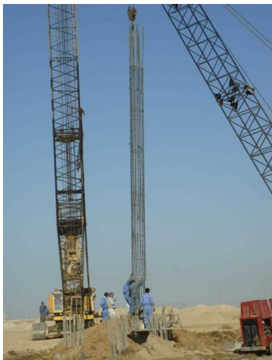
شکل الف-۱۶- استقرار قفسه آرماتور درون شمع درجاریز
