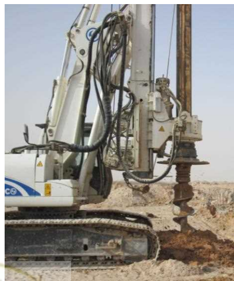
شکل الف-۱۵- دستگاه حفاری شمع درجاریز (تصویر سمت راست)، مته اوگر یا ماریچ (تصویر سمت راست)
