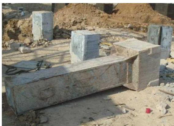
شکل الف-۴- نمونه‌ای از یک دنبالگر (Follower)
