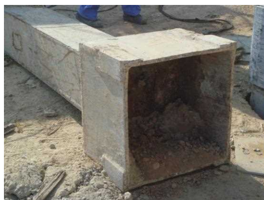
شکل الف-۴- نمونه‌ای از یک دنبالگر (Follower)
