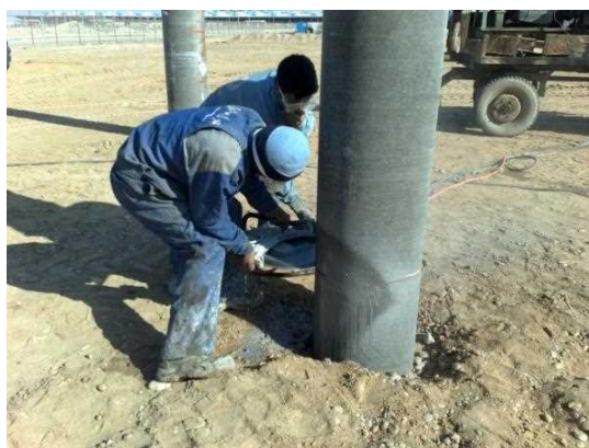
شکل الف-۱۱- بریدن راس شمع‌های بتنی با کمک تخریب (سمت راست) و توسط اره‌های مخصوص (سمت چپ)
