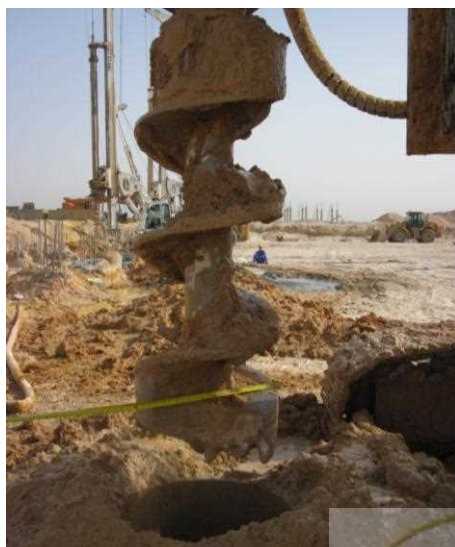
شکل الف-۱۵- دستگاه حفاری شمع درجاریز (تصویر سمت راست)، مته اوگر یا ماریچ (تصویر سمت راست)
