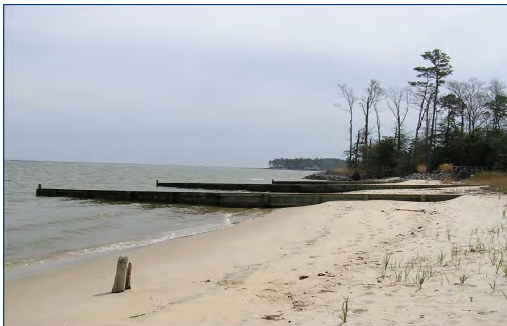
شکل ۳-۱۵- نمونه‌ای از آبشکن‌های گروهی چوبی کوچک که در یک ساحل ماسه‌ای اجرا شده‌اند (اسکاتلند)
