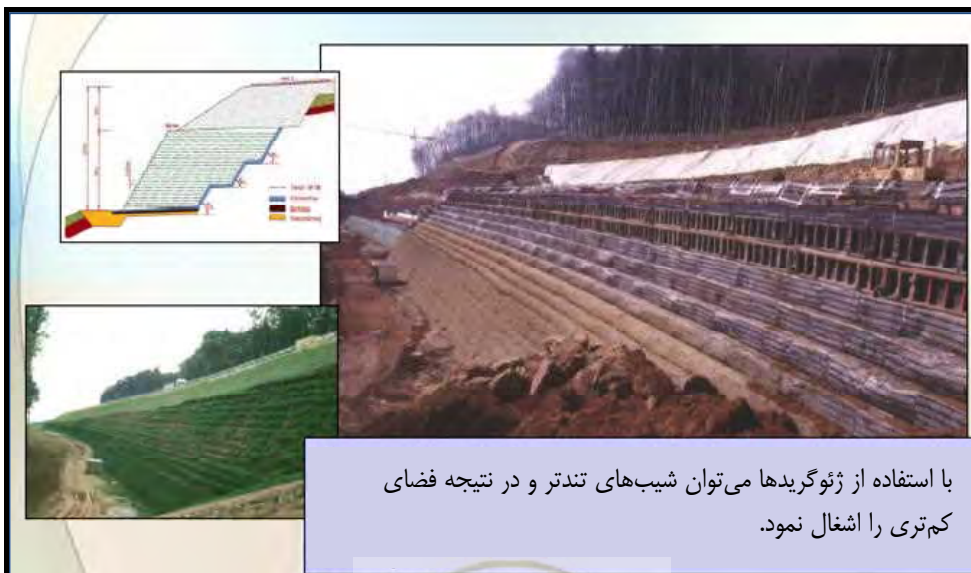
شکل ۳-۲۹- استفاده از ژئوسنتتیک به عنوان تثبیت شبروانی‌ها و پایدارکننده دیوارهای حایل
