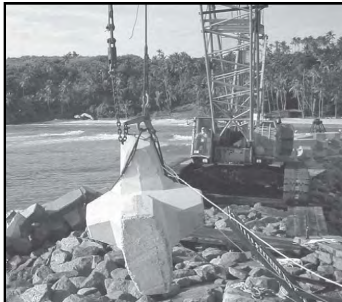
شکل ۵-۲۲- استفاده از قلاب بازشو برای استقرار آرمور
