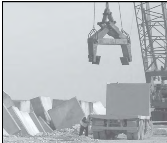
شکل ۵-۶- تریلی کفی که برای انتقال آرمورهای بتنی استفاده می‌شود
