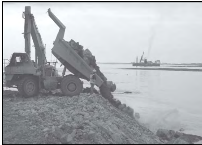
شکل ۵-۸- نمونه‌ای از کامیون‌های کمپرسی چند دیفرانسیلی که برای اجرای موج‌شکن به کار می‌روند
