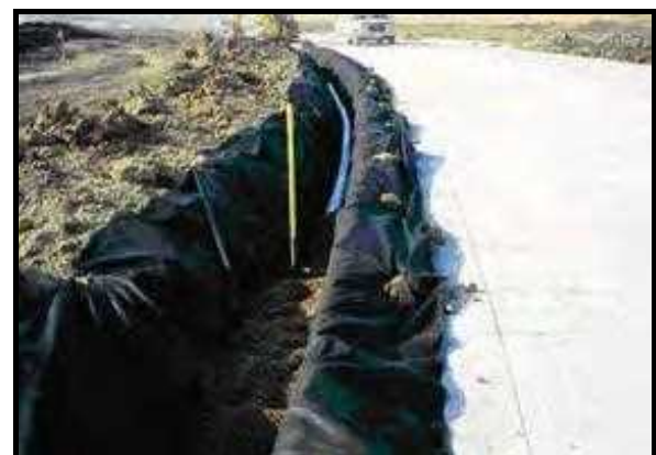
شکل ۳-۳۳- استفاده از ژئوسنتتیک به عنوان زهکش در سازه‌های خاکی
