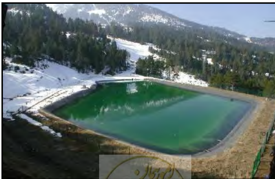
شکل ۳-۳۴- نمونه‌ای از کاربرد ژئوممبران در آب‌بندی یک دریاچه مصنوعی
