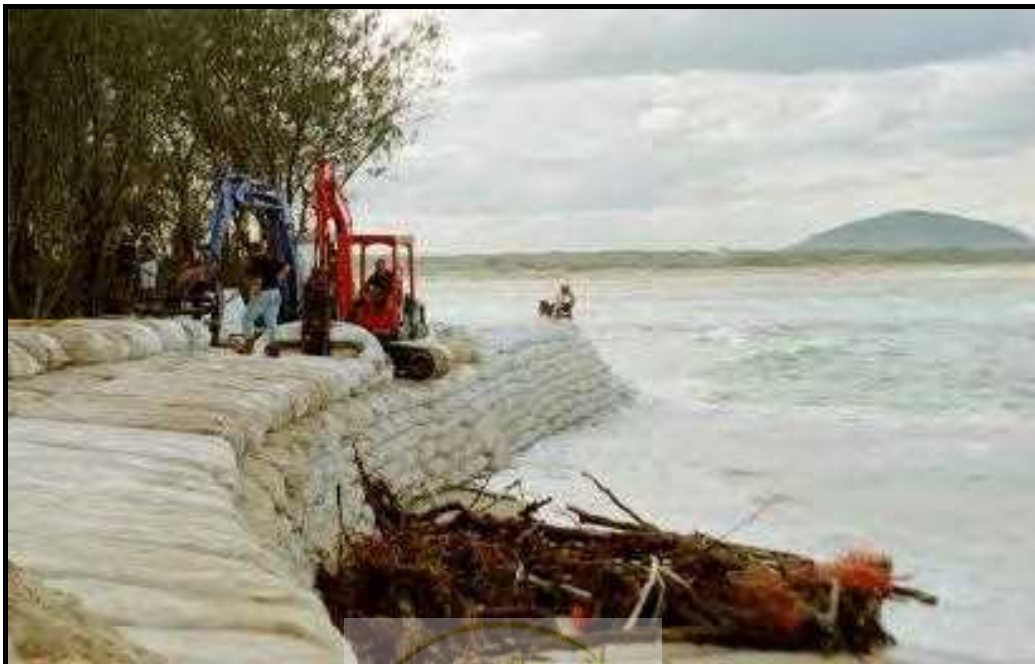
شکل ۳-۳۰- استفاده از ژئوسنتتیک به عنوان سازه نگهبان ساحلی در برابر نیروهای امواج
