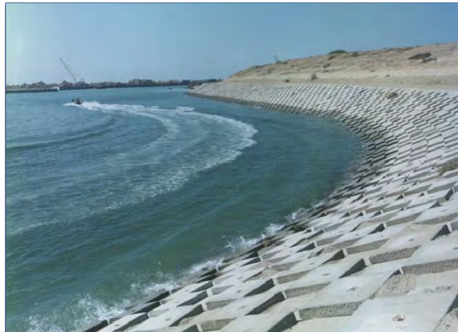
شکل ۳-۴- نمونه‌ای از یک پوشش محافظ ساخته شده توسط قطعات بتنی (بندر شهید کالانتری، ایران)
