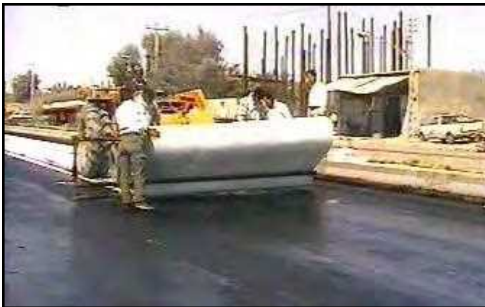
شکل ۳-۲۶- استفاده از ژئوسنتتیک برای روسازی راه
