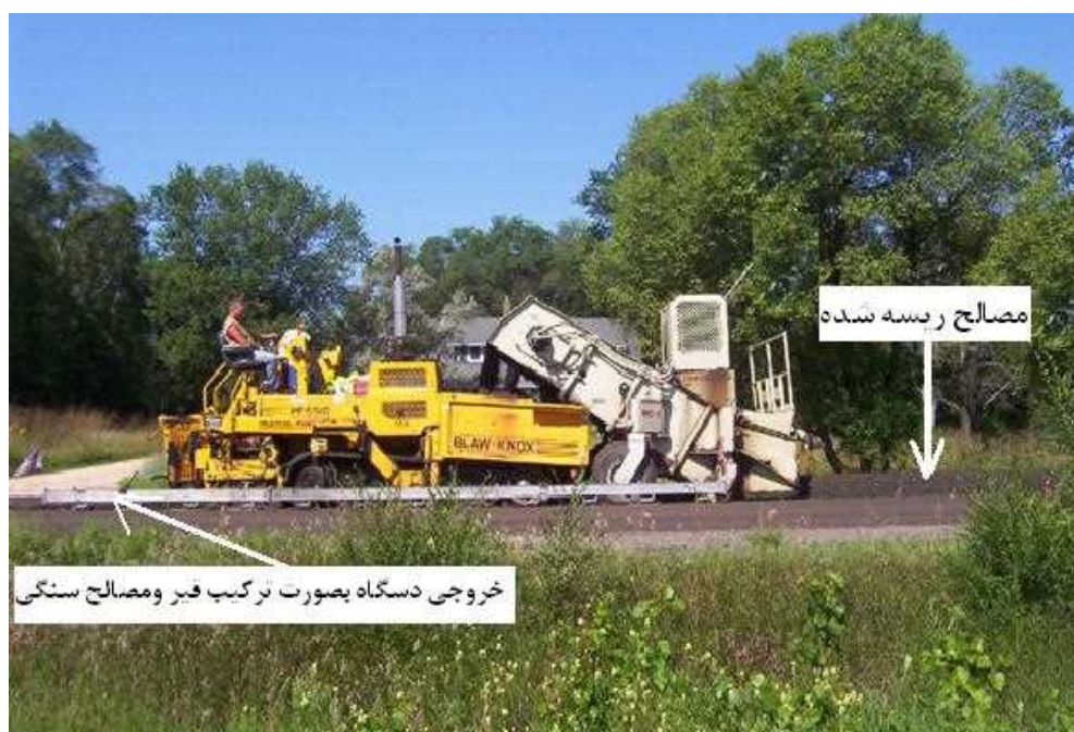
شکل ۵-۳- نمونه‌ای از دستگاه‌های مخلوط‌کننده سیار که عمل جمع‌آوری مصالح سنگی ریسسه‌شده در طول مسیر، اضافه‌کردن فیبر در داخل محفظه و پخش آسفالت سرد را انجام می‌دهند.
