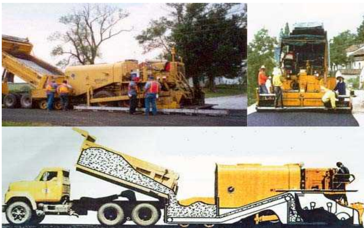
شکل ۵-۶- پخش آسفالت سرد توسط دستگاه فینیشر
