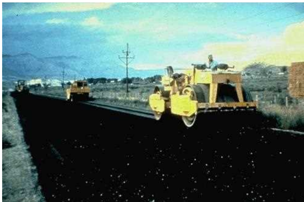
شکل ۵-۷ عملیات غلتک‌زنی لایه آسفالت سرد توسط غلتک‌های چرخ‌لاستیکی و چرخ‌فولادی (از غلتک چرخ فولادی برای غلتک‌زنی پایانی استفاده می‌گردد)
