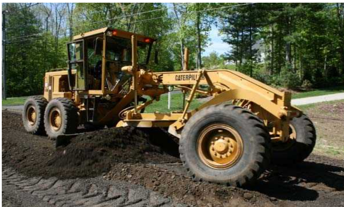
شکل ۵-۵- عمل اختلاط قیر و مصالح توسط گریدر
