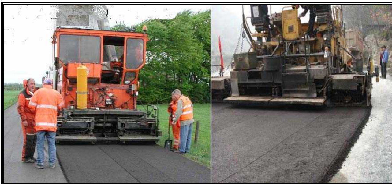
شکل ۵-۹ پخش آسفالت سرد توسط دستگاه فینیشر
