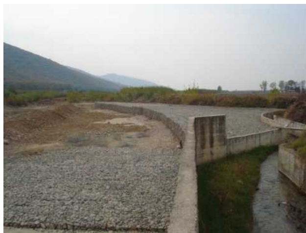
شکل ۵-۳- اجرای کفبند توری سنگی داخل رودخانه
