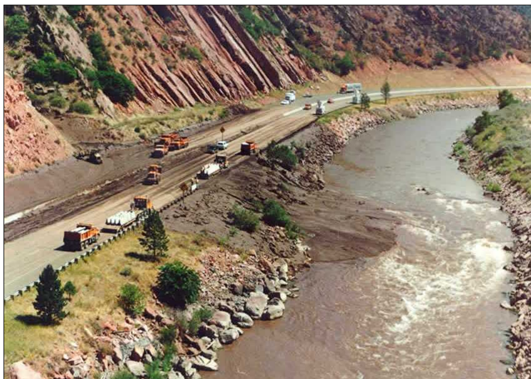
شکل ۵-۱۳- وقوع جریان گلی و ورود آن به رودخانه (ایالات متحده)
