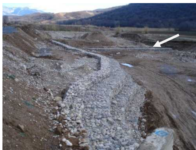
شکل ۵-۴- کفبند توری سنگی پایین دست حوضچه آرامش
