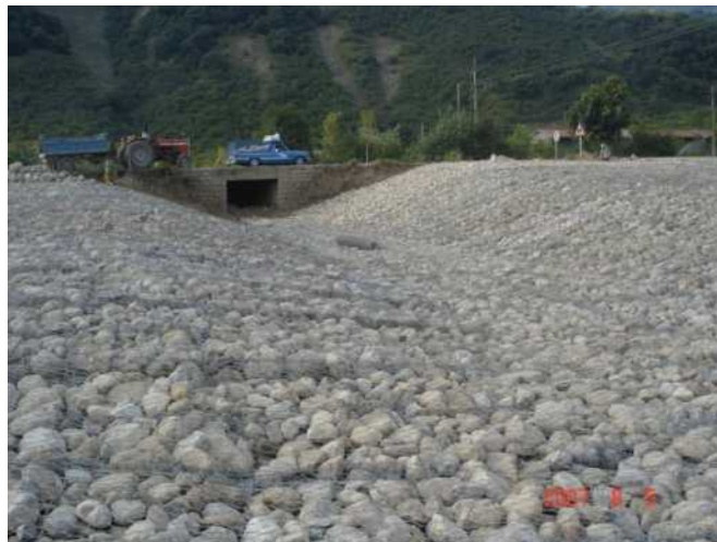
شکل ۵-۶- نمونه‌ای از تشک توری سنگی ساحل راست
